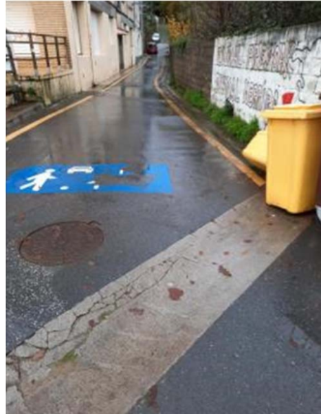
Las lluvias de diciembre de 2020 no afectaron al vial
