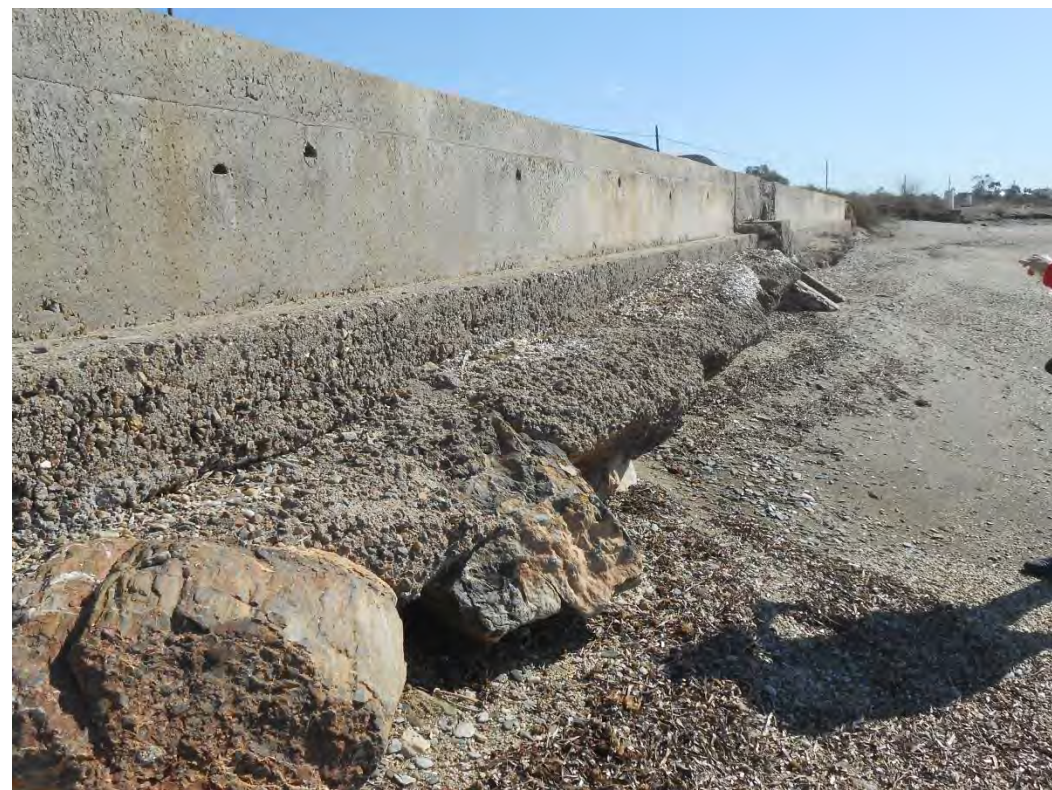
Figura 4. Muro de protección para la carretera comarcal RM-D15
