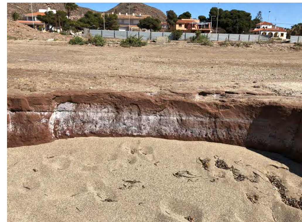
Figura 26. Afloramientos arcillosos en la playa con escalón
