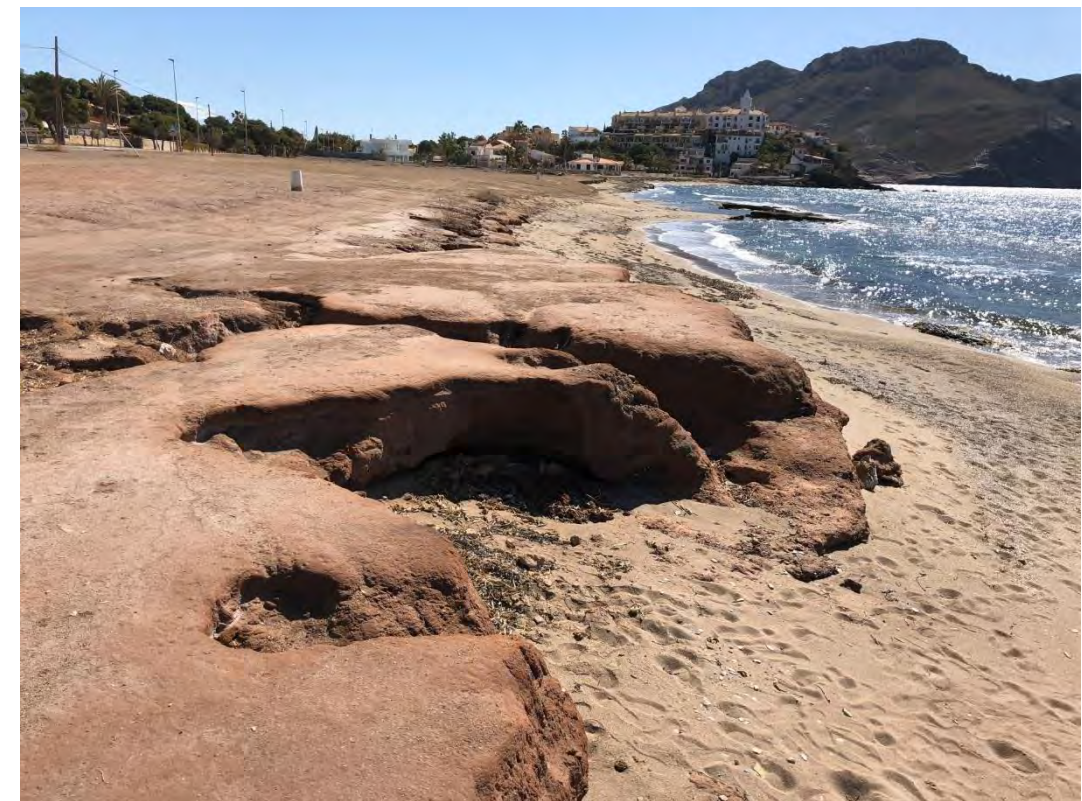
Figura 22. Afloramientos arcillosos en la playa con escalón
