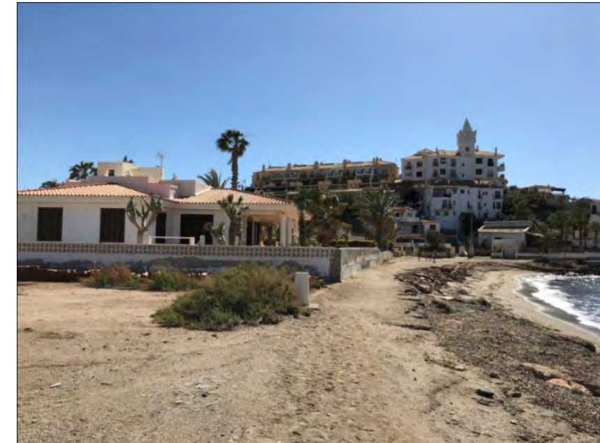
Figura 2. Vertido de escollera no autorizado
