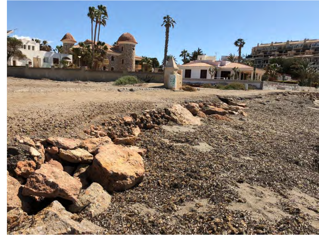
Figura 29. Escollera de protección en la zona Este de la playa a retirar.
