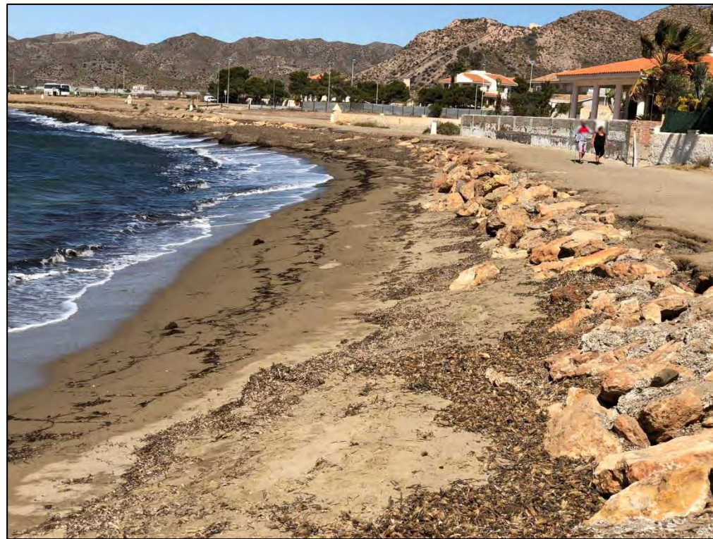
Figura 1. Escollera existente a retirar vertida irregularmente
