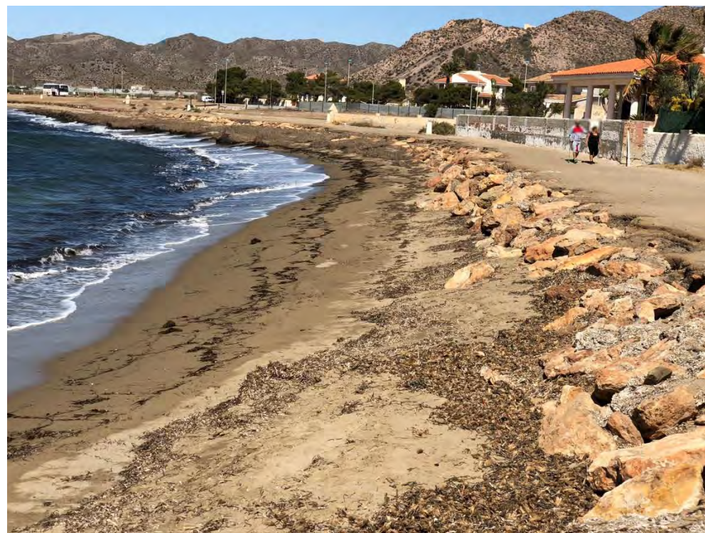
Figura 32. Vista general de la escollera a retirar.
