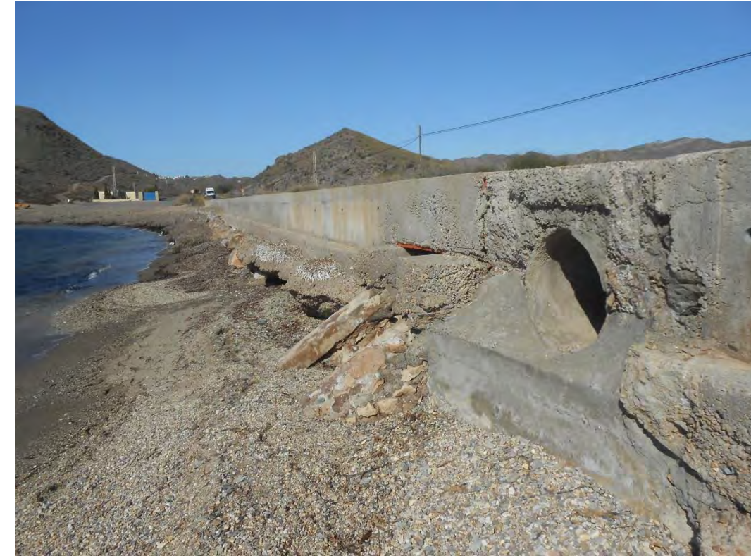
Figura 5. Obra de drenaje transversal I de la carretera comarcal RM-D15
