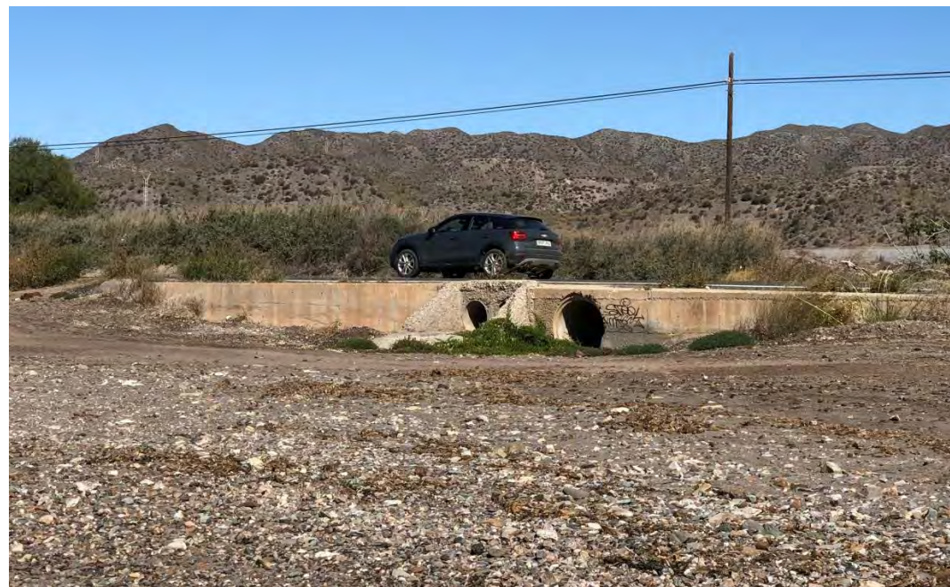
Figura 16. Obra de drenaje transversal II de la carretera comarcal RM-D15
