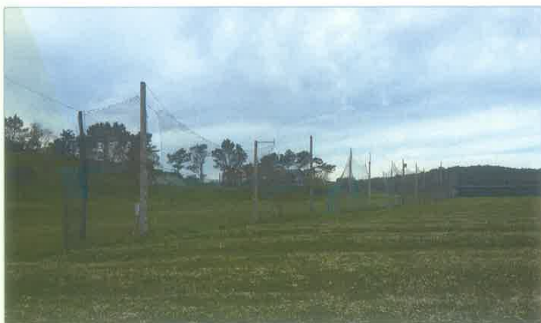
Foto N°1.- Aspecto que presenta la red de protección de la cancha de prácticas junto al Hoyo N°3.
