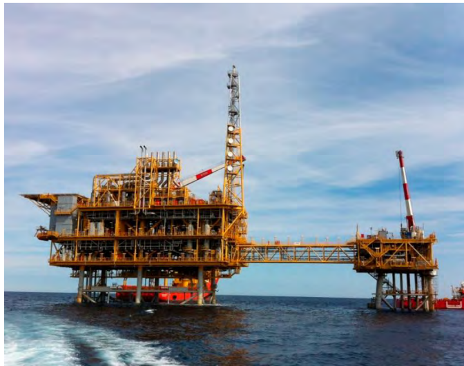
Figura 2: Vista general de las plataformas de proceso (a la izquierda) y la plataforma de pozos (a la derecha).
