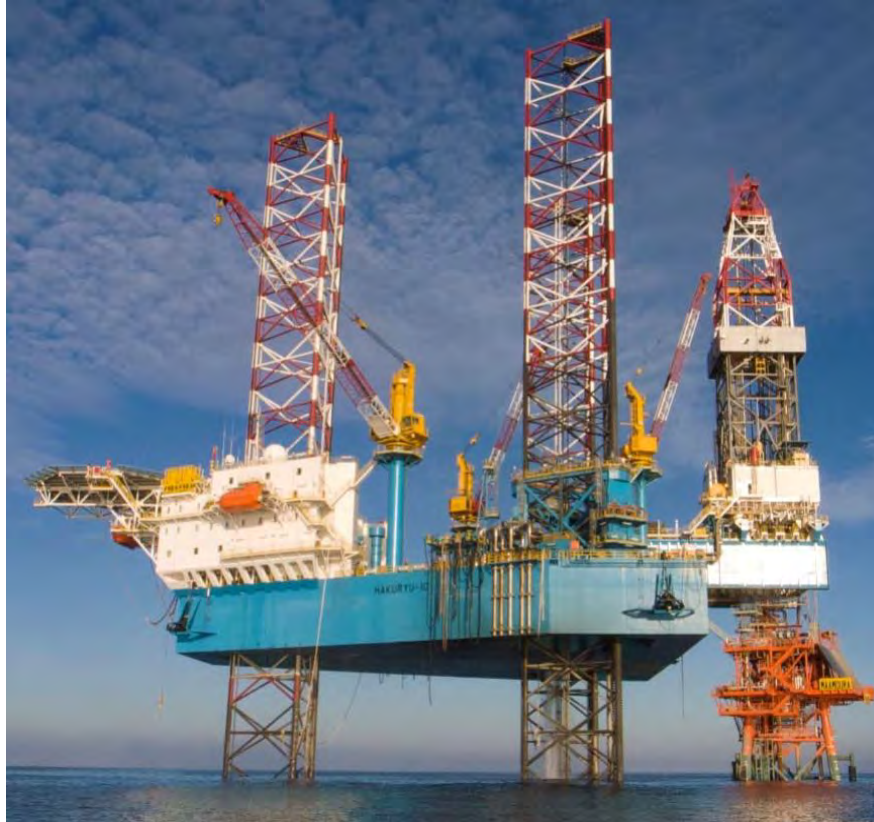
Figura 3: Plataforma móvil de perforación auto-elevadora (Jackup MODU) Hakuryu-H10. Fuente: JDC, 2020.
