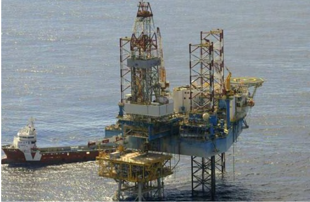
Figura 4: Imagen de la instalación de la plataforma Castor mediante una plataforma Jack up (Fuente: Enagás, 2019).
