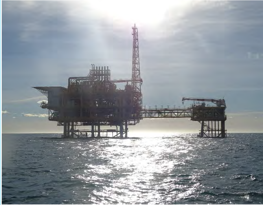
Cara Noroeste de las plataformas de proceso (izquierda) y de pozos (derecha)
