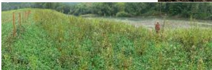
Figura 2.1 Las técnicas de bioingeniería son una herramienta de utilización cada vez más frecuente en restauración fluvial. Empleo de armazones y empalizadas naturales en la actuación del Río Deva en Molleda, CH Cantábrico, 2006. Evolución de la actuación en primavera y verano de 2007
