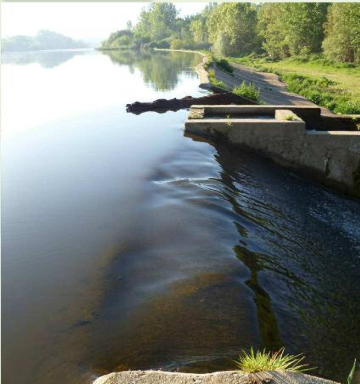
Figura 3.13 Sistemas para evacuación de caudal ecológico: rebaje en azud. Central de Zorita. Río Tormes
