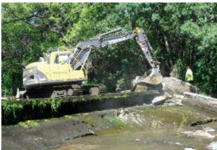
Figura 4.7 Demolición azud Pinilla. CH Tajo
