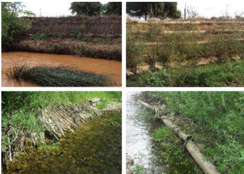
Figura 4.4 Diferentes técnicas de bioingeniería empleadas en restauración fluvial. Sup. Técnica mixta de lechos de ramas y empalizada trenzada (izqda) y Muro krainer (dcha) en Lobón. CH Guadiana. Inf. Aplicación de esteras y rebrote de sauce en el río Lozoya. CH Tajo
