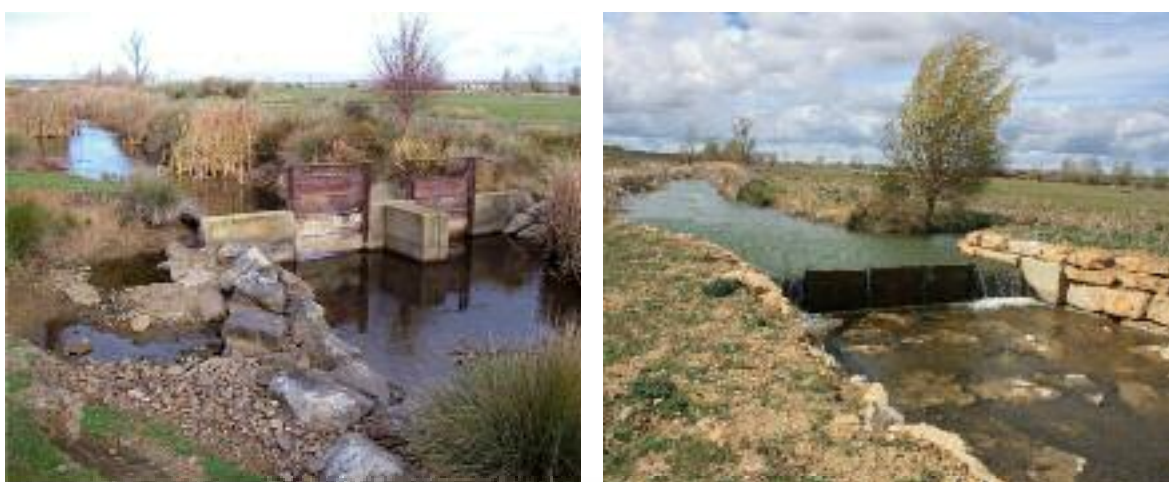
Figura 4.6 Actuación de eliminación de azud de hormigón y sustitución por azud desmontable para permitir la libre circulación de las aguas fuera de la época de riego. Arroyo de la Vega (León).CH Duero. Izq.: Antes de su demolición. Dcha.: Después
