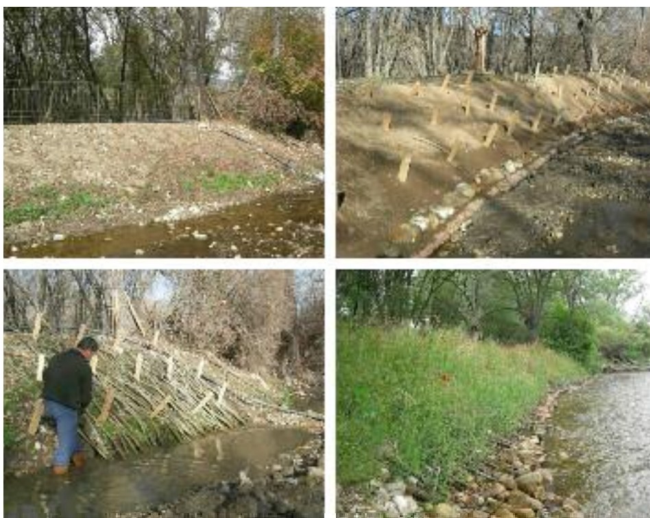
Figura 4.5 Evolución de la aplicación de las técnicas de bioingeniería (i.e. esteras) empleadas en el río Lozoya. CH Tajo
