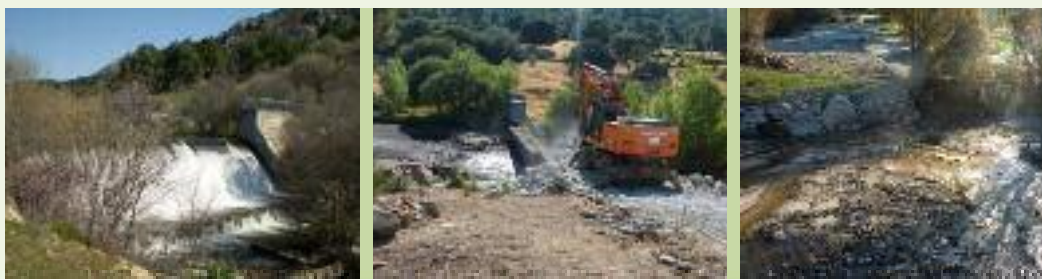
Figura 4.19 Distintos momentos de la eliminación de la presa en el río Cofio (CH Tajo): antes del comienzo de las obras, durante su realización y una vez concluidas
