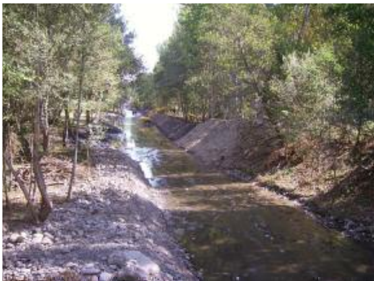
Figura 3.6 El buen estado de un río según lo establecido por la DMA depende en gran medida de sus características hidromorfológicas. La recuperación de antiguos brazos de río ampliando el espacio fluvial es fundamental para la restauración del funcionamiento ecológico del río, Río Sil a su paso por la Martina (Ponferrada)
