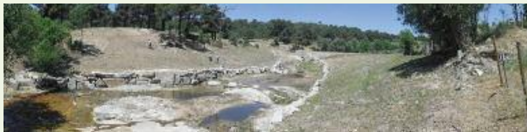
Figura 4.20 Panorámica del tramo de intervención en la primavera siguiente a la finalización de las obras
