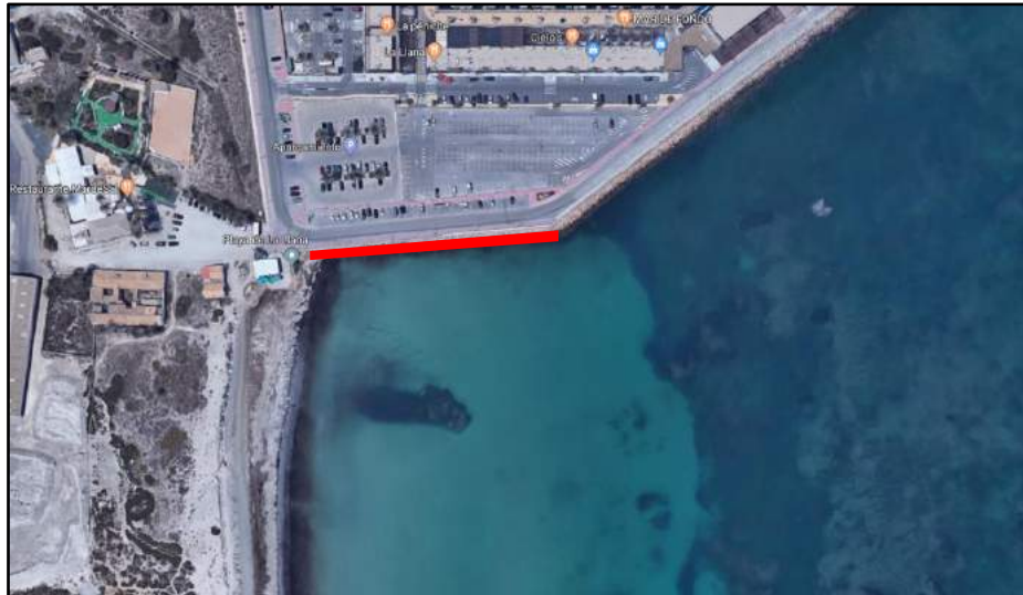
Ilustración 2. Camino de acceso para ejecución del Espigón
