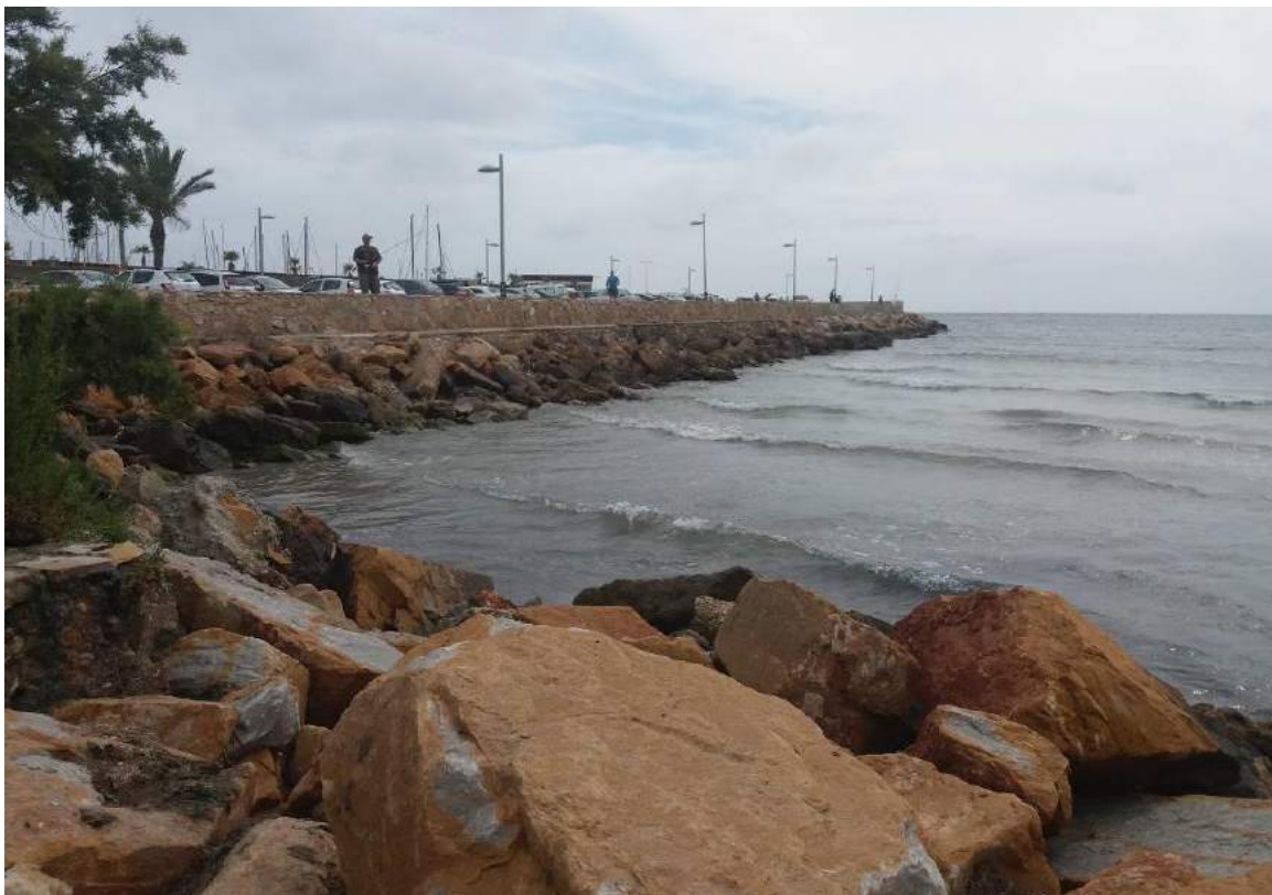
Fotografía 10: Tramo norte de la playa de la Llana.
