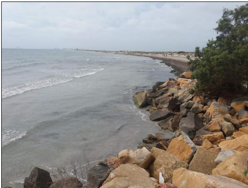
Ilustración 9. Escollera existente en el contradique del Puerto y en la zona de playa
