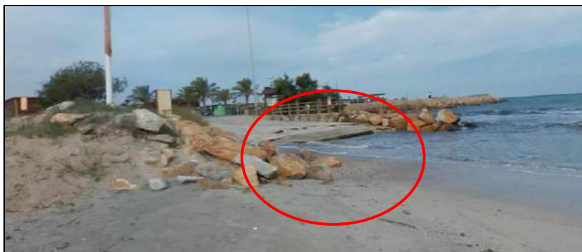
Ilustración 32. Acondicionamiento de la zona de acceso
