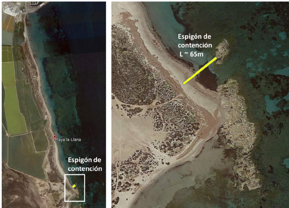
Figura 44. Espigón de contención de arena al final de la playa, longitud de unos 65m permitiendo el paso en la playa entre el dique y la duna
