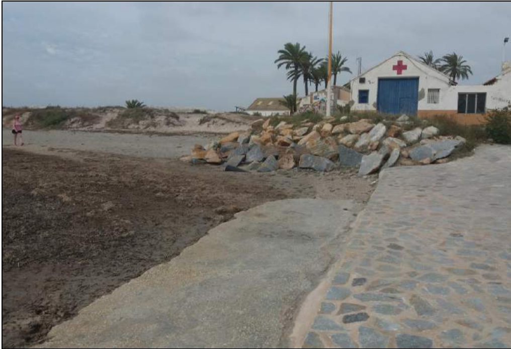
Ilustración 10. Escollera existente en la zona de playa
