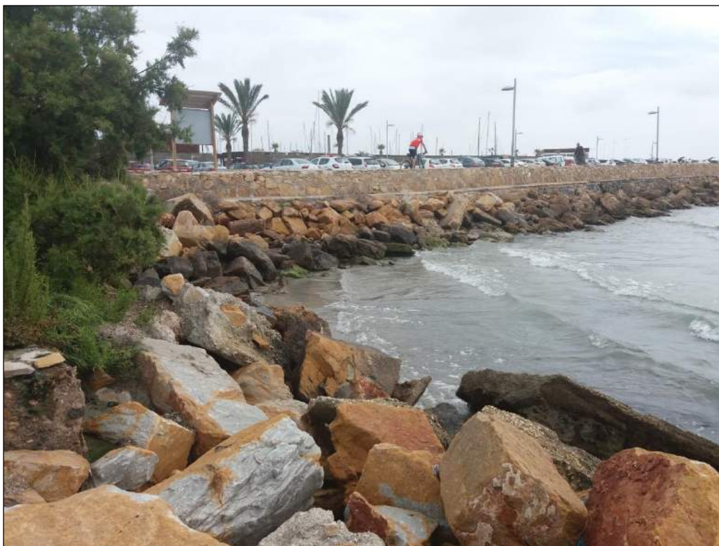
Escollera existente en el contradique del Puerto y en la zona de playa
