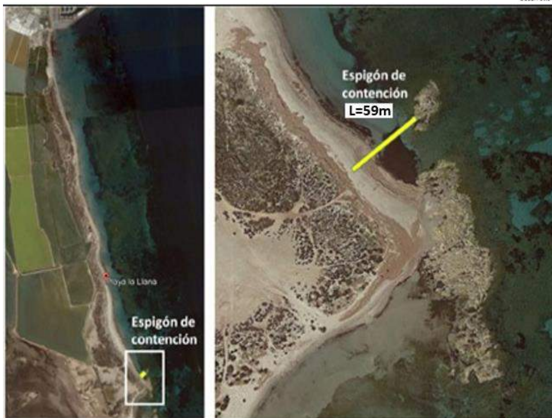
Ilustración 11. Espigón de contención de arena al final de la playa, longitud de unos 59m permitiendo el paso en la playa entre el dique y la duna. Fuente: Actualización del proyecto de acondicionamiento de las playas de La Llana. IH Cantabria (2.020).
