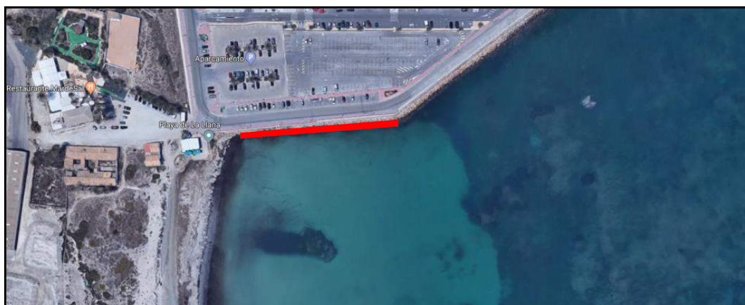
Ilustración 29. Espigón auxiliar en el contradique del puerto
