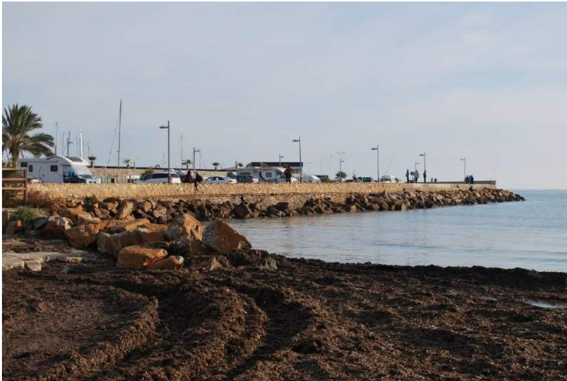
Fotografía 9: Tramo norte de la playa de la Llana.
