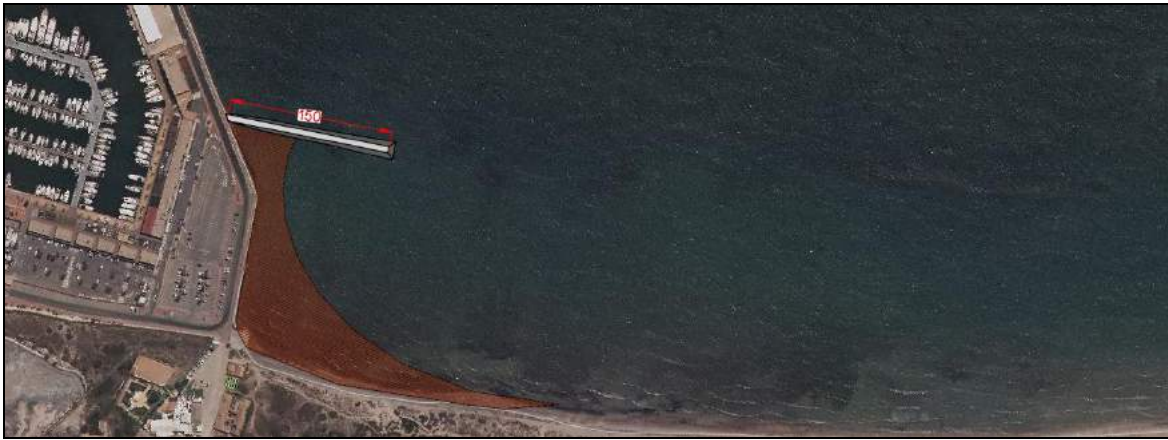
Ilustración 26. Espigón 150m junto al Puerto de San Pedro
