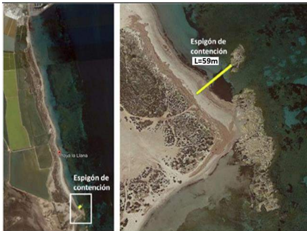
Ilustración 18. Espigón de contención de arena al final de la playa, longitud de unos 59m permitiendo el paso en la playa entre el dique y la duna. Fuente: Actualización del proyecto de acondicionamiento de las playas de La Llana. IH Cantabria (2.020).
