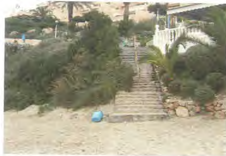
FOTO 2. Vista general de la escalera a adaptar.
