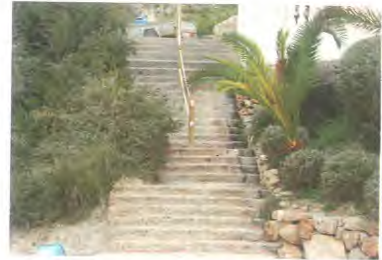
FOTO 3. Detalle de vista general ampliada de la escalera a adaptar.
