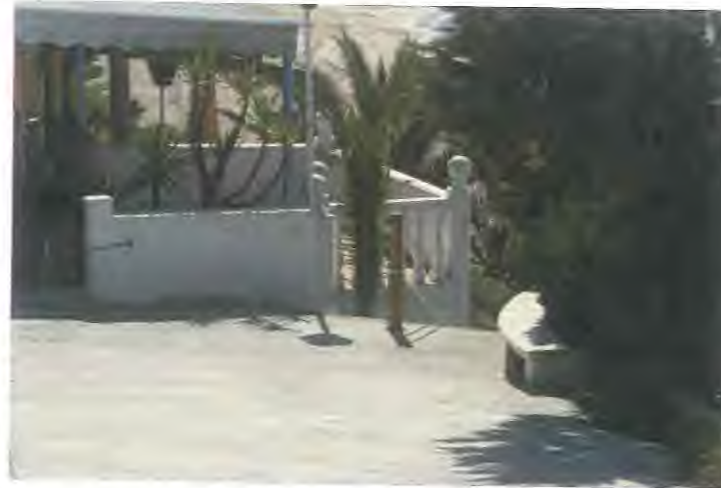
FOTO 5. Arranque de la escalera actual a adaptar.
