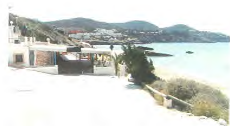
FOTO 6. Vista general del principio de escalera a modificar.
