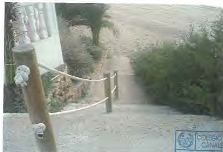
FOTO 8. Detalle ampliado del principio de escalera actual.
