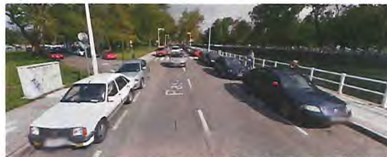
Imagen 4: Zona de construcción del alivio al río Piles (vista hacia el Molinón)
