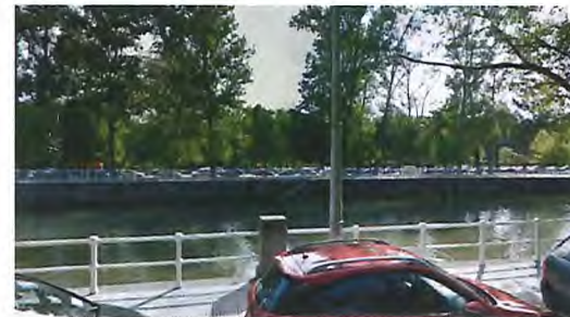
Imagen 2: Zona de cruce del río Piles (ejecución de península)
