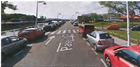
Imagen 3: Zona de construcción del alivio al río Piles (vista hacia la Playa de San Lorenzo)
