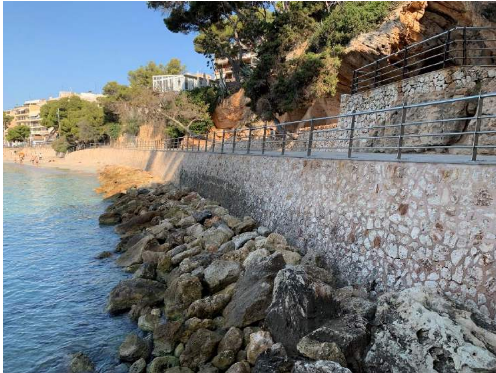
Figura 12.- Vista del muro de contención del tramo 3 del paseo marítimo de Coves Blanques.
