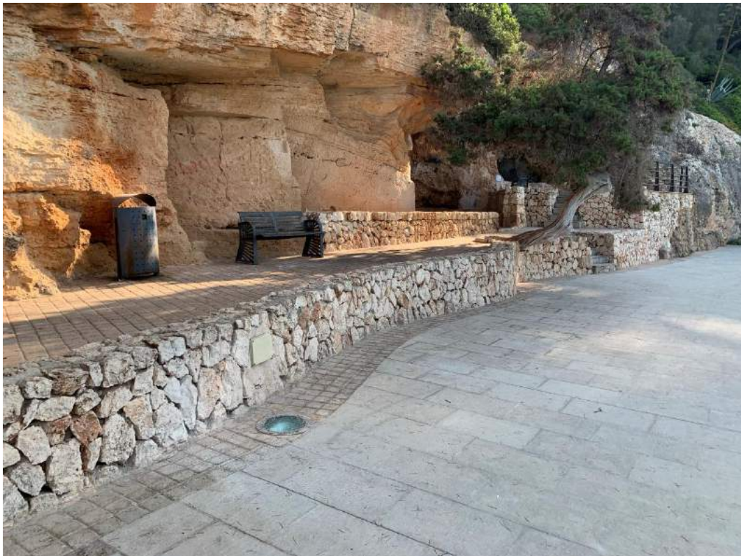
Figura 7.- Tramo 3B del paseo marítimo.
