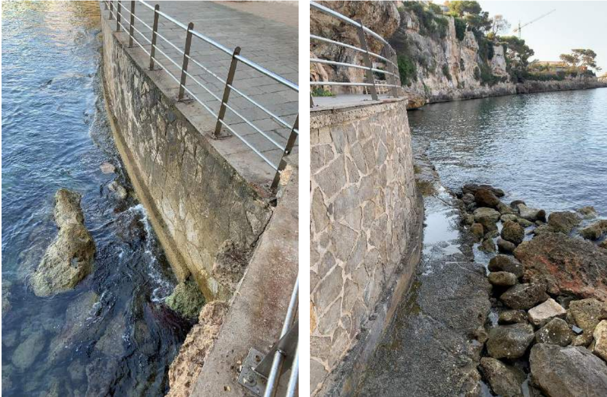
Figura 14.- Vistas del muro de contención del tramo 4 del paseo marítimo de Calas de Mallorca.
