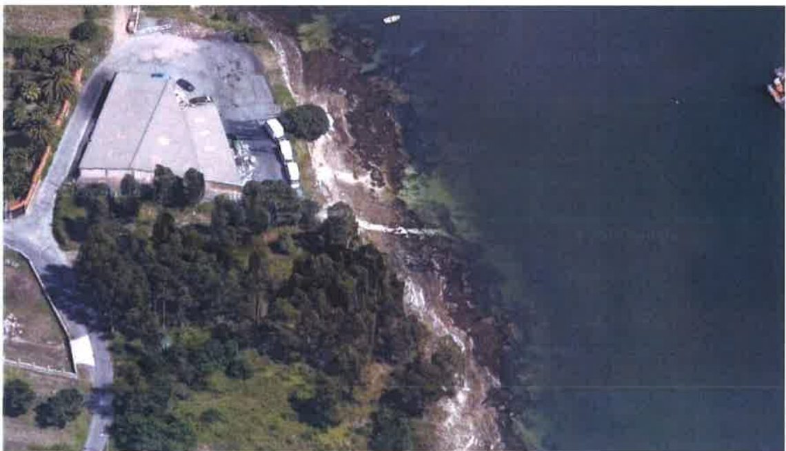
Nave Depuradora de Moluscos de FERNÁNDEZ MARIÑO, S.L.
