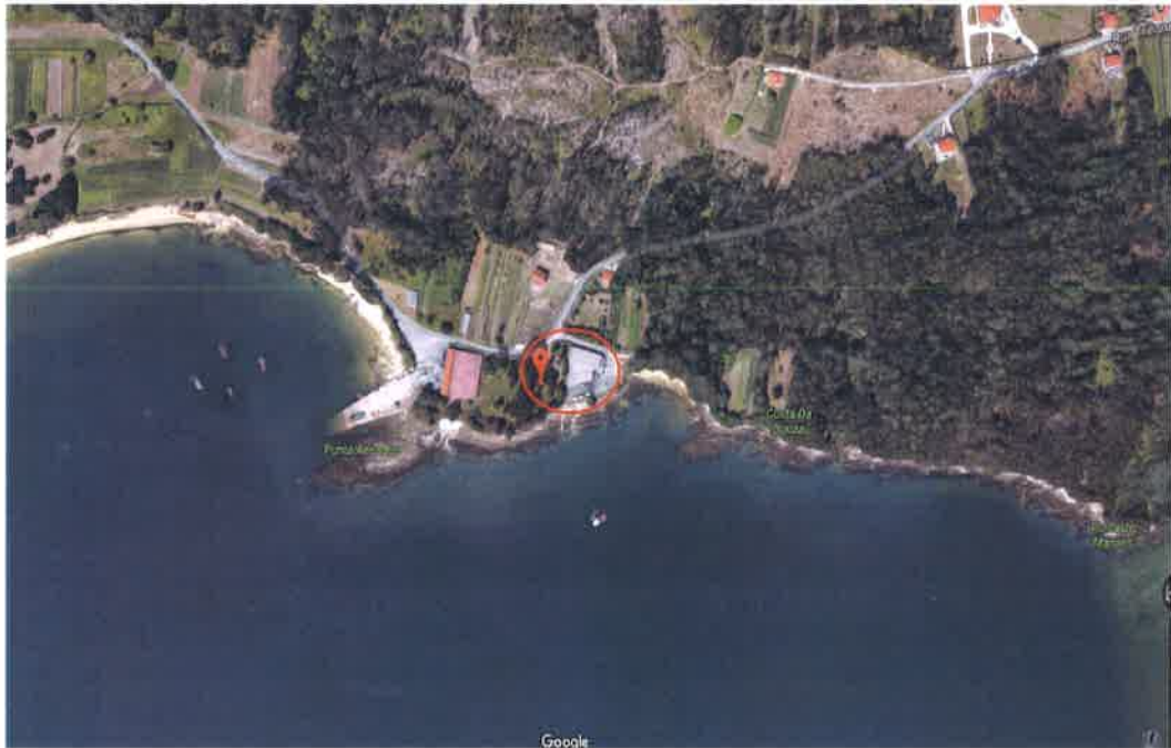
Foto aérea de la Depuradora de Moluscos sita en el Lugar Abanqueiro-Triñanes, BOIRO (La Coruña)
