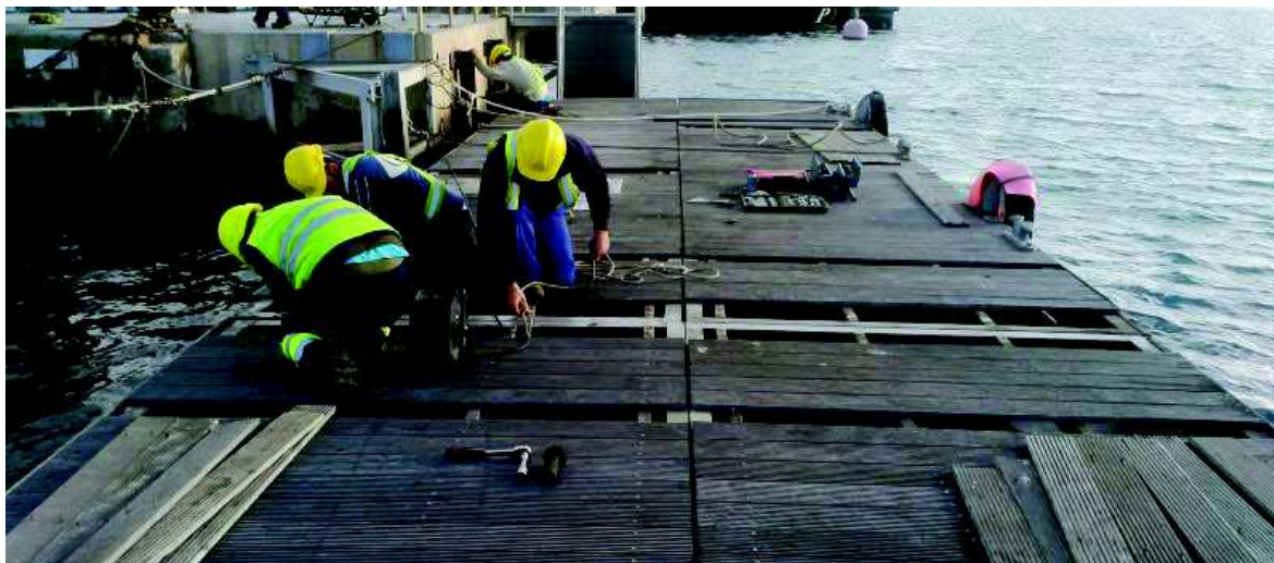
Imagen 1. Desmontaje manual del entarimado de un pantalán.
