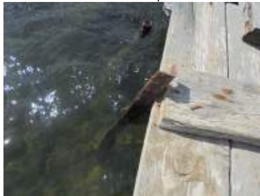
Ejemplo de soporte de material inadecuado para soportar la plataforma
