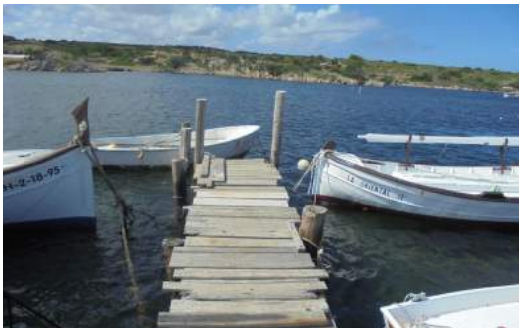
Figura 33. Detalle del pantalán número 3, donde en escasos 3 metros hay 7 pilares, todos ellos en mal estado, la rehabilitación de estos pilares se completaría en este tramo con dos pilares.
