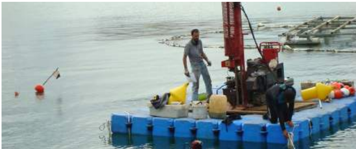
Imagen 2. Hincado de un pilote mediante martillo neumático en pontona de plástico.
