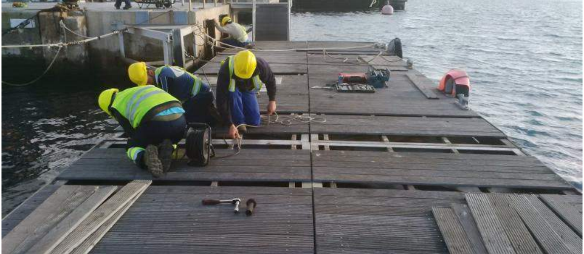
Imagen 1.Desmontaje manual del entarimado de un pantalán.
