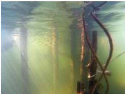
Acumulación de pilares usados a lo largo de los años para aguantar las estructuras
