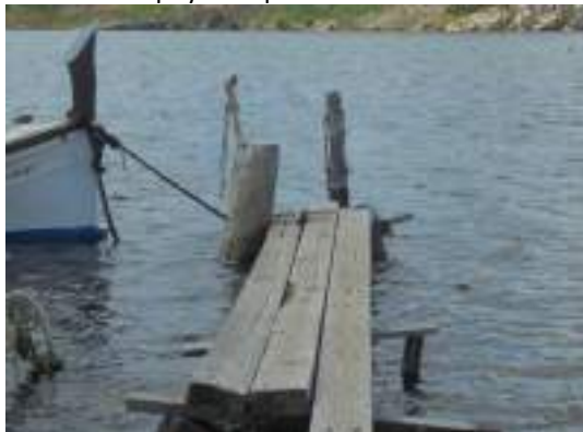
Desigualdad de los materiales, formas, diámetros de los pilares
