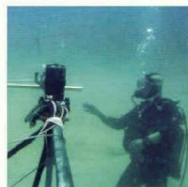
Buzo accionando el brazo del atornillador
