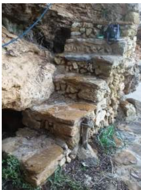
Encuentro entre escalera y rellano final
