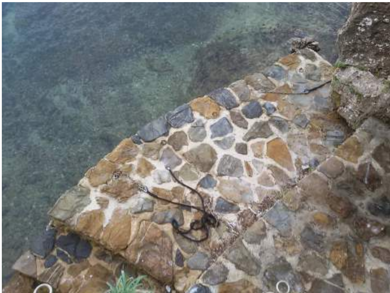
Rellano final de acceso al mar
