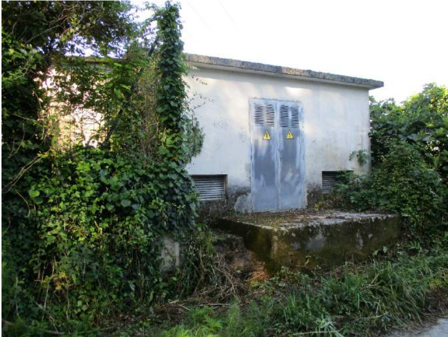
Centro de transformación
