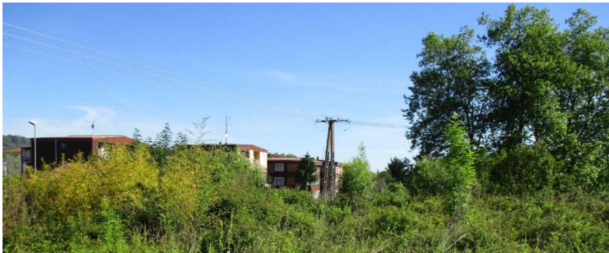
Línea de media tensión en lámina de agua proyectada.
