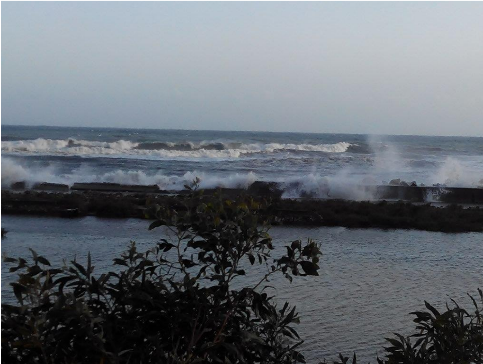
Foto nº 3. Penetración del mar por una de las dos grandes zonas de desmoronamiento del muro de protección tras escollera. En primer plano, zona inundada comprendida entre muro perimetral exterior tras escollera y muro interior.
