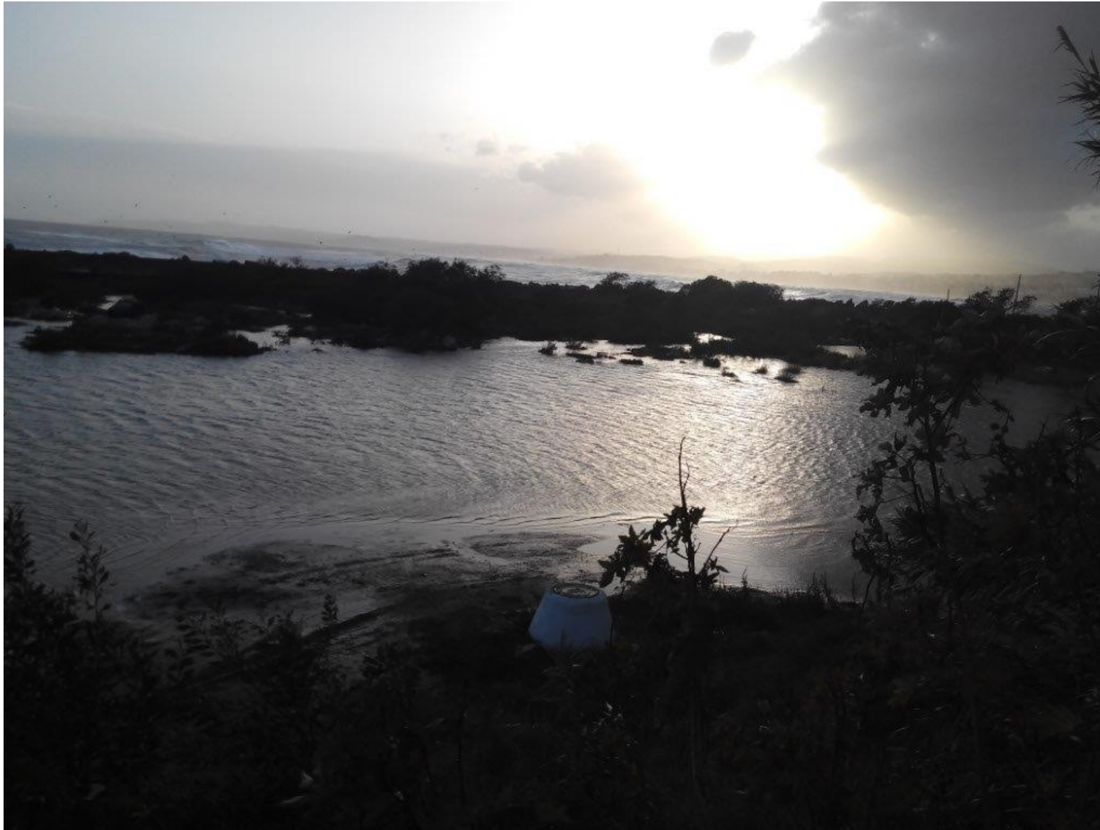
Foto nº 4. Terrenos de estudio inundados en su totalidad desde el muro perimetral exterior hasta la base de línea de edificaciones interior, dónde el terreno aumenta de cota (empieza a acercarse a la cota +2 sobre N.M.M.A.) con cordón de vegetación que se aprecia en primer plano de la foto.
