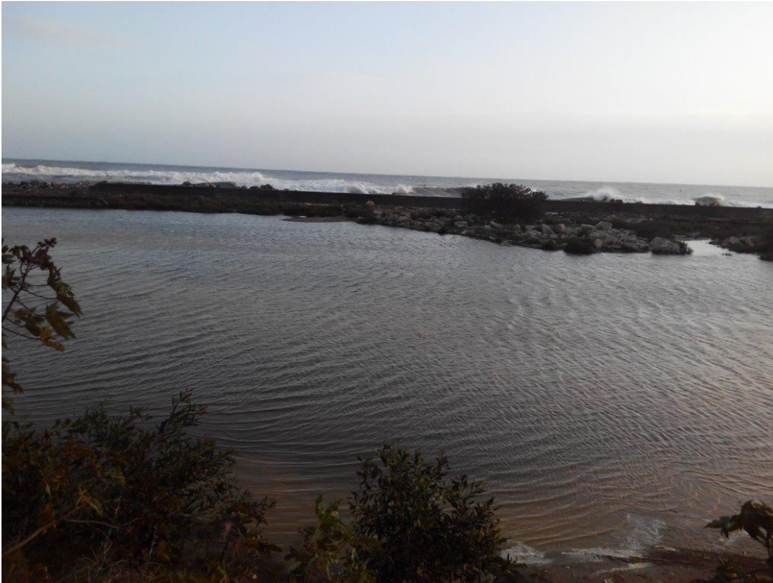
Foto nº 8. Vista tomada desde la rampa de salida de los edificios a la zona (junto al punto de la toma anterior) hacia el muro perimetral exterior, apreciándose la inundación completa de los mismos y la penetración directa del mar por zona de desmoronamientos.
