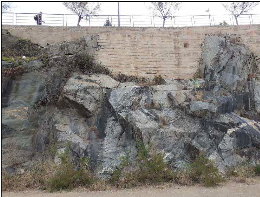
FOTO 1. Talús frontal que s'aixeca per damunt de l'esplanada.
