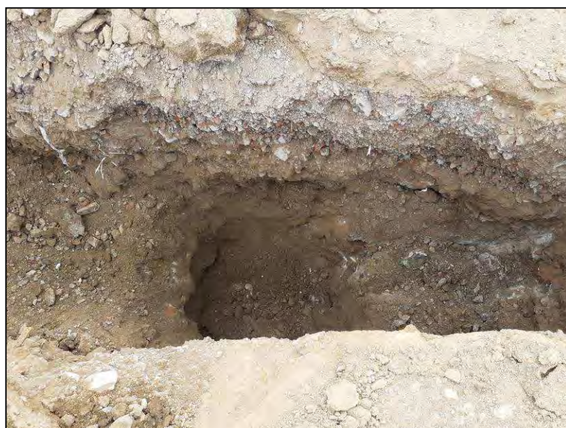
Foto 6. Interior de la cala C-3 amb els fonaments a 1m i la roca a 1,5m.
