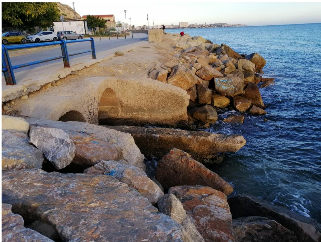
Figura 127 Salida de pluviales del Cocó.
