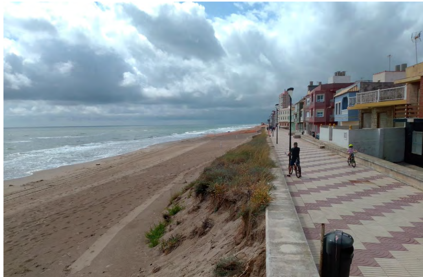
Figura 54. Zona playa Les Palmeres con primer cordón dunar degradado junto al paseo.
