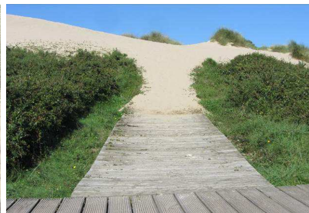
Figura 35. Duna en desplazamiento generando una ruptura de la duna secundaria.
