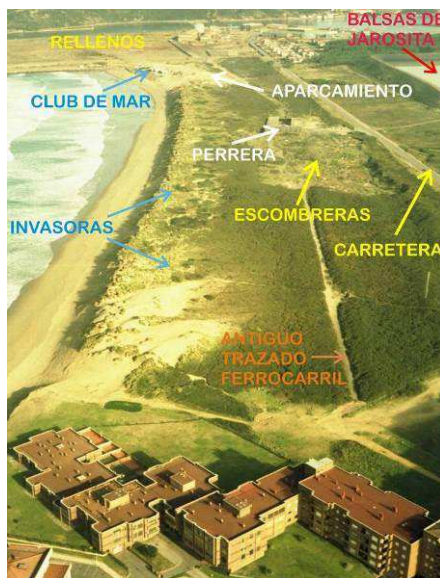
Figura 2. Principales impactos sobre el sistema dunar de El Espartal antes de la restauración finalizada en el año 2007.
