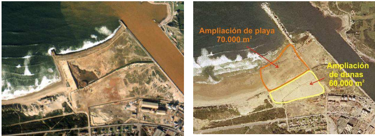
Figura 13. Fotogramas del año 2001 (izquierda) y 2003 (derecha) donde se reconocen las obras de recuperación y construcción del nuevo dique.
