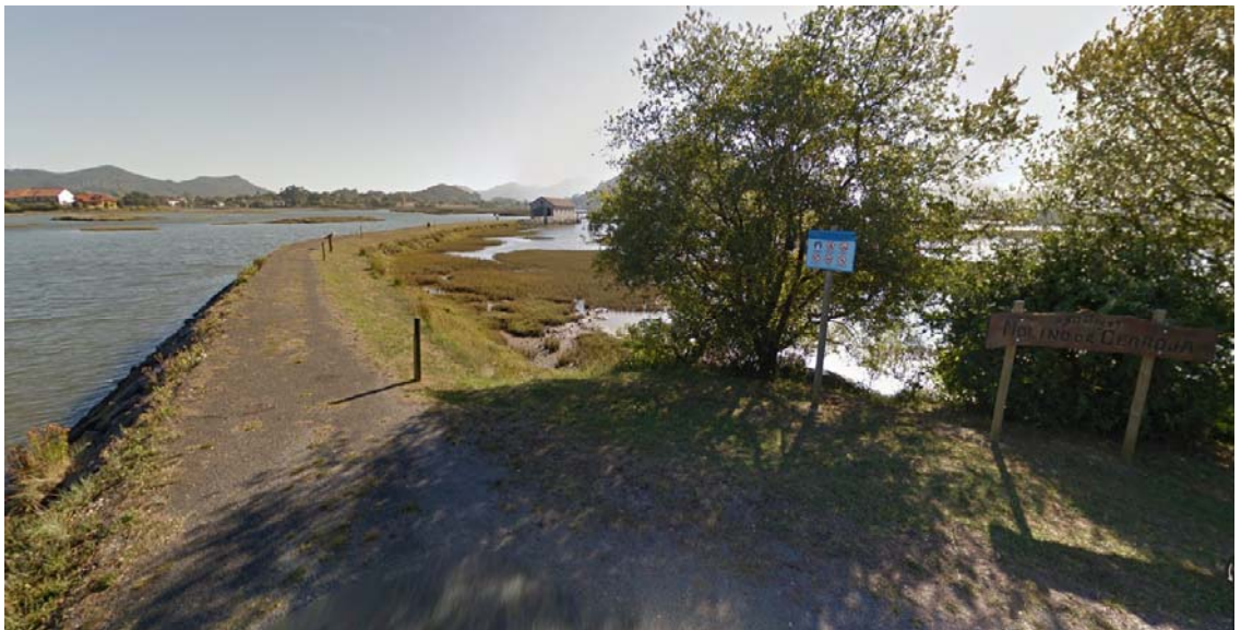
Zona de inicio del espigón norte del molino de marea para acceso al mismo (se ve al fondo), donde no se proyecta intervención alguna.
