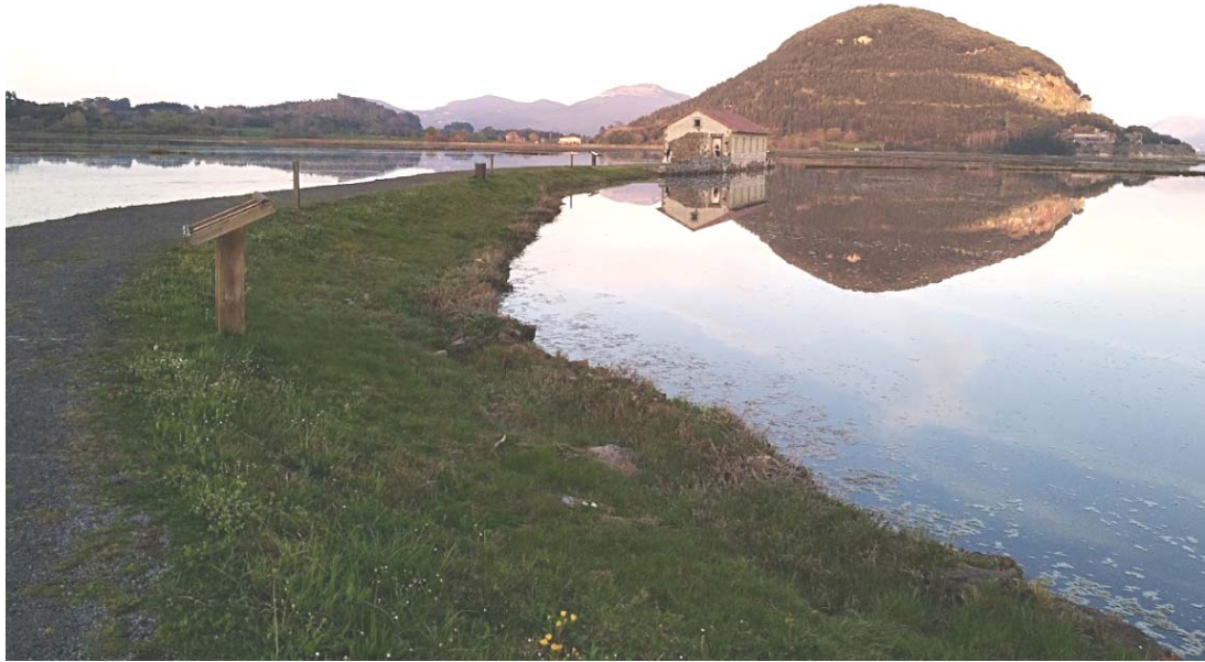
Espigón norte del molino de marea para acceso al mismo, donde no se proyecta intervención alguna.
