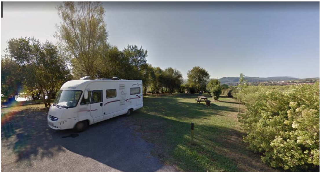
Zona con mobiliario urbano en la actualidad, donde se proyecta el levantado de todo el mobiliario existente y la plantación de árboles autóctonos que completan a los ya existentes.
