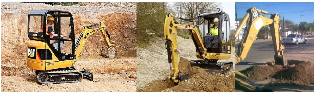
Fotos 16 a 18. Retroexcavadora o “mini-retro” para apertura y tapado de zanjas.
