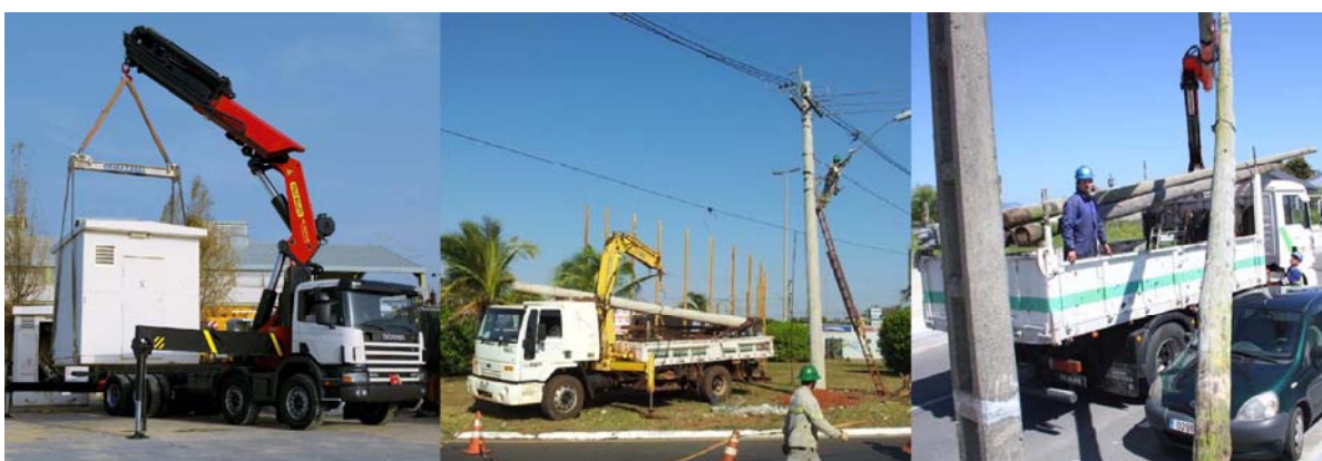
Fotos 24 a 26. Camión grúa, para retirada de postes y torres e apoyo (centro y derecha), carga y descarga de bobinas, y para colocación de transformador monoblock Ormazábal (izquierda).
