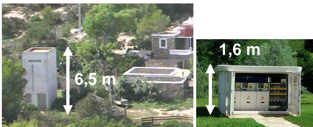
Fotos 31 y 32. Comparación entre el CD "Sal Rossa", a demoler (izquierda), y un CD monoblock de Ormazábal, similar al CD "Nou Sal Rossa" a instalar.
