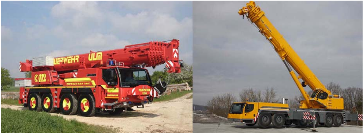
Fotos 27 y 28. Grúa móvil extensible hasta 70 m, para construcción de islote artificial.
