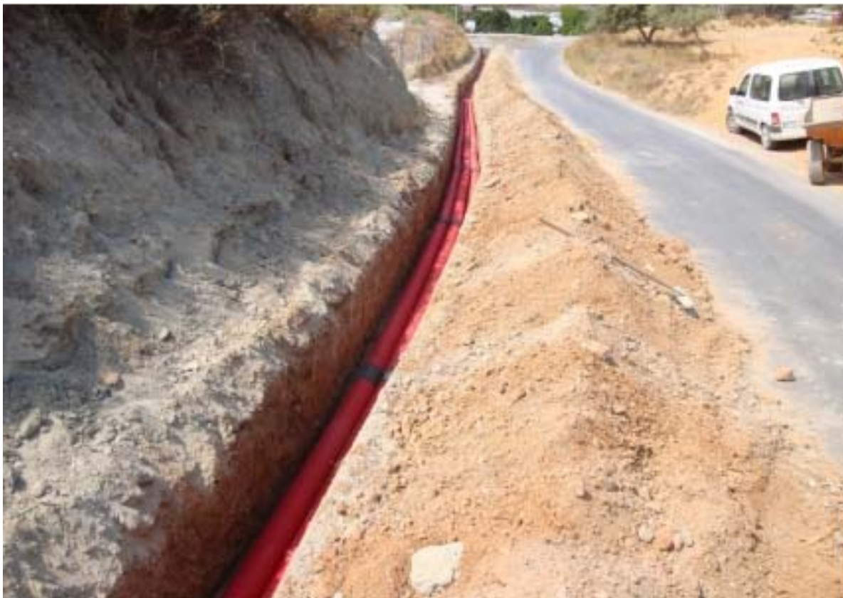
Foto 10. Ejemplo de acopio de tierras a pié de zanja.
