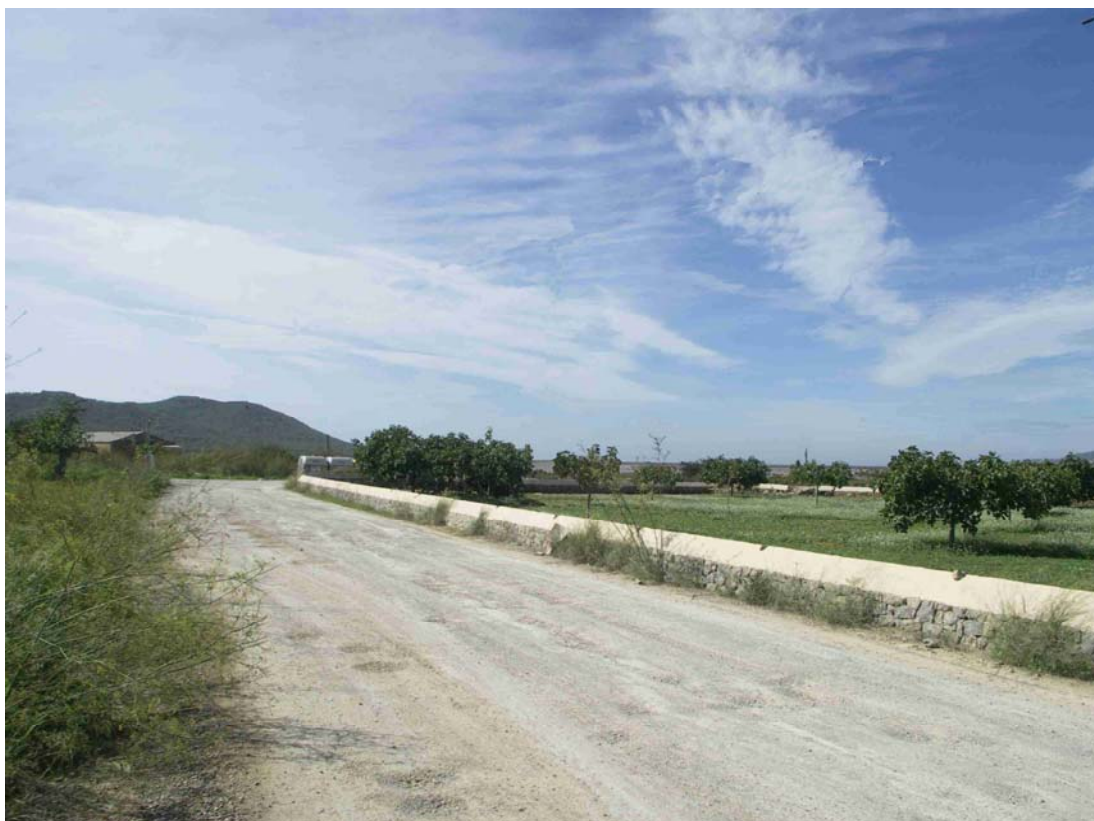
Foto 6. La eliminación de tendidos aéreos va a suponer un beneficio importante para el ámbito del proyecto, desde el punto de vista del paisaje visual.
