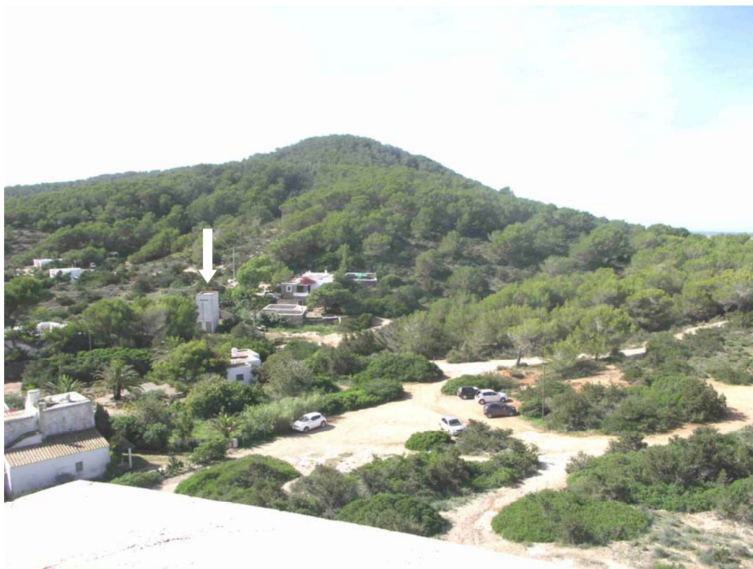
Foto 12. El transformador de sal Rossa se elimina, reduciendo el impacto visual de su entorno.
