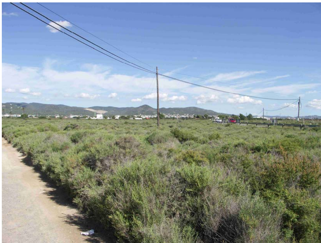
Foto 11. Los tendidos aéreos producen desarmonías visuales y rotura de horizontes. Su emplazamiento a lo largo de la carretera PM-802 aumenta exponencialmente su impacto visual extrínseco.
