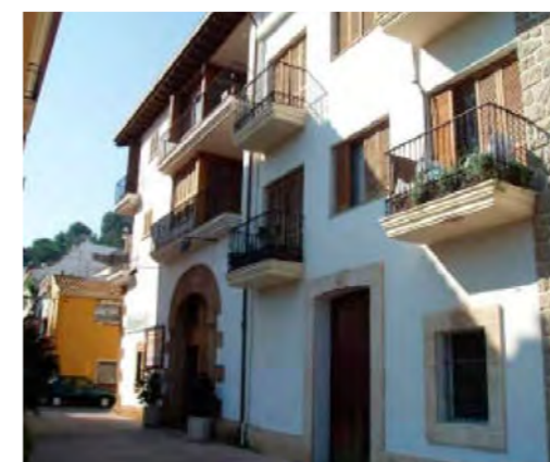
Imagen 108: Almacenes portuarios Puerto de Denia. Fuente: Proyecto de recuperación del tramo de costa entre los puertos de Oliva y Denia.
