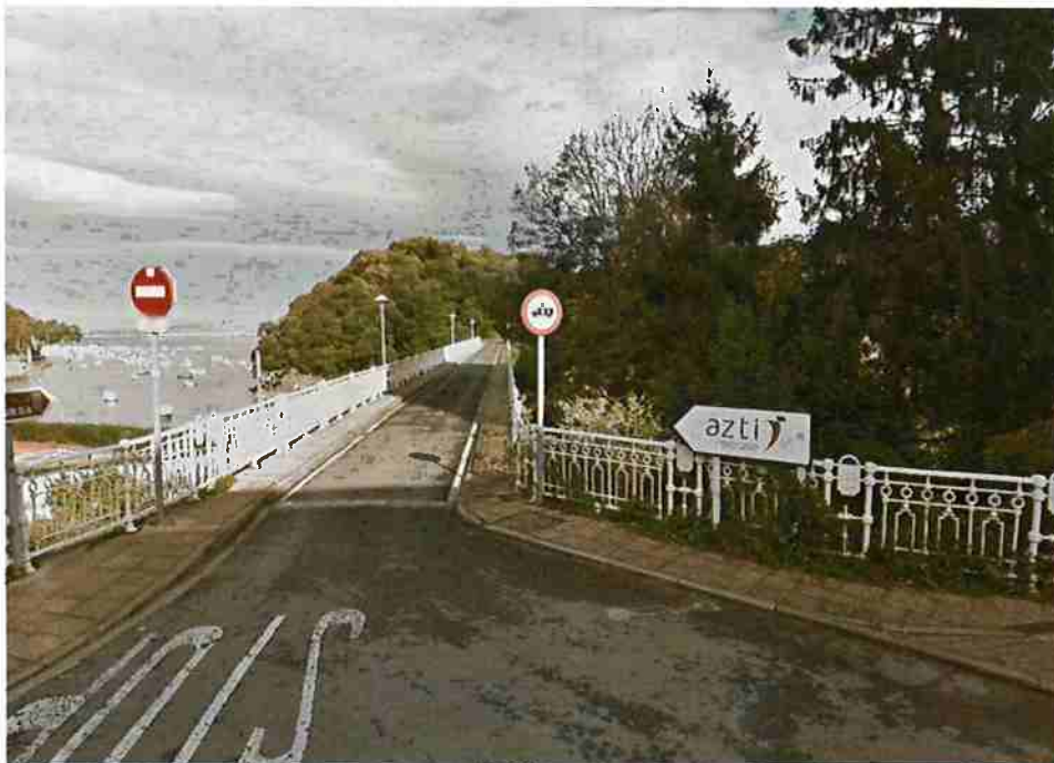
Acceso al puente desde el Barrio Axpe (T.M. Busturia)
