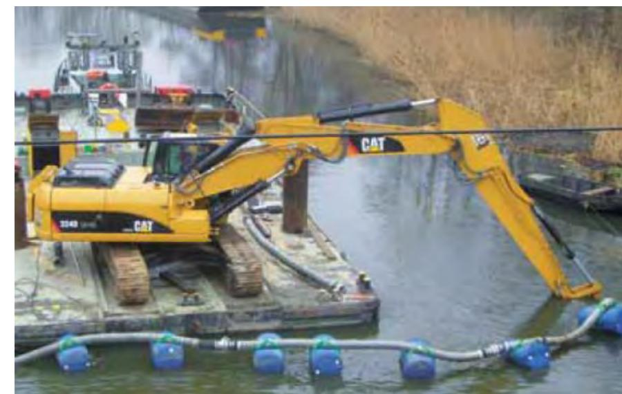
Figura 8.- Ejemplo de manejo de una bomba para dragado dispuesta sobre pontona flotante (Fuente: Dragflow)
