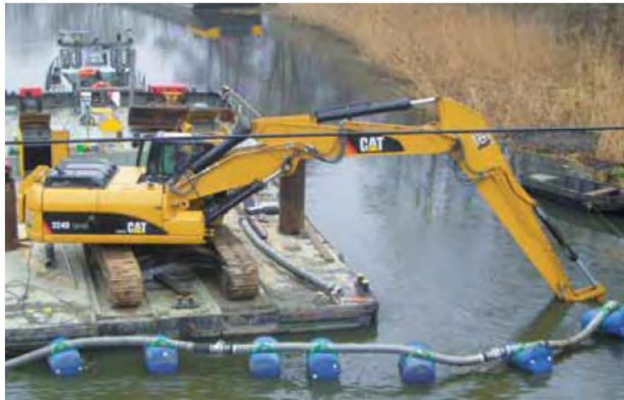
Figura 20.- Ejemplo de manejo de una bomba para dragado dispuesta sobre pontona flotante (Fuente: Dragflow)
