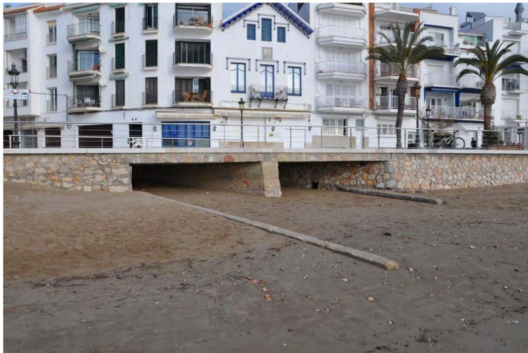
Fotografía 8.- Salida de aguas pluviales (Fuente: elaboración propia)
