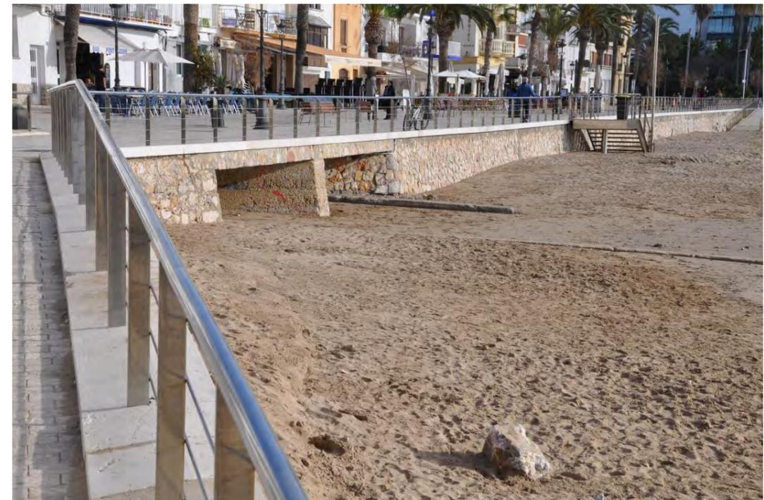
Fotografía 10.- Salida de aguas pluviales y accesos peatonales por levante (izquierda), central y por poniente (derecha) (Fuente: elaboración propia)
