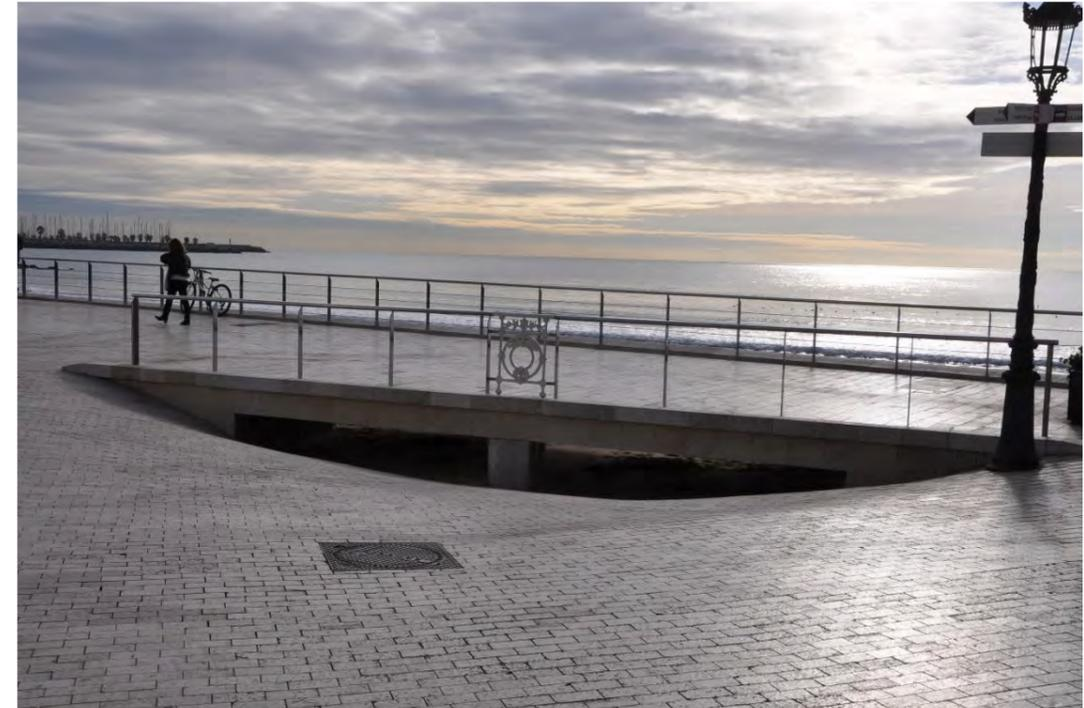
Fotografía 9.- Salida de aguas pluviales (Fuente: elaboración propia)
