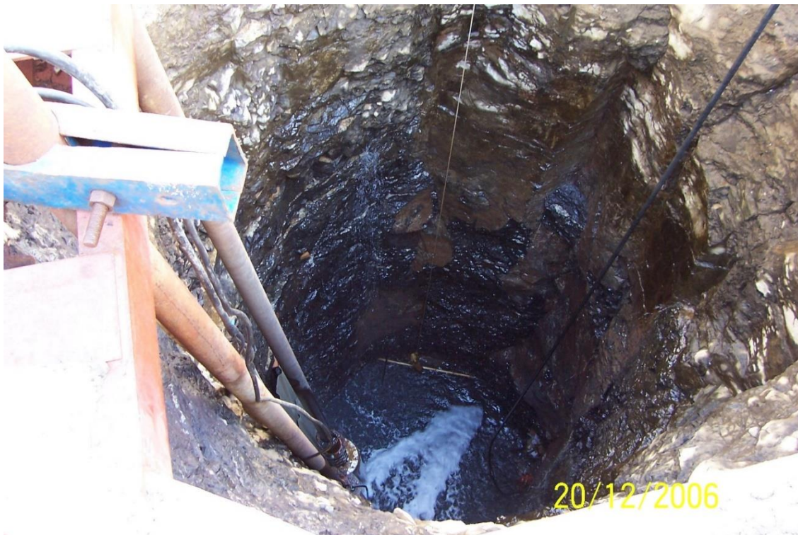
Ilustración 4 Ejecución del Pozo Canario. Hastiales.
