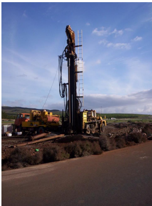
Ilustración 2 Maquinaria para los Sondeos de Investigación
