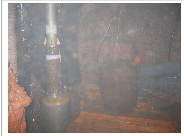
FOTOGRAFÍA N° 6 .- MUESTRA EL NIVEL DEL POZO DONDE SE HA EMBOQUILLADO LA GALERÍA.
