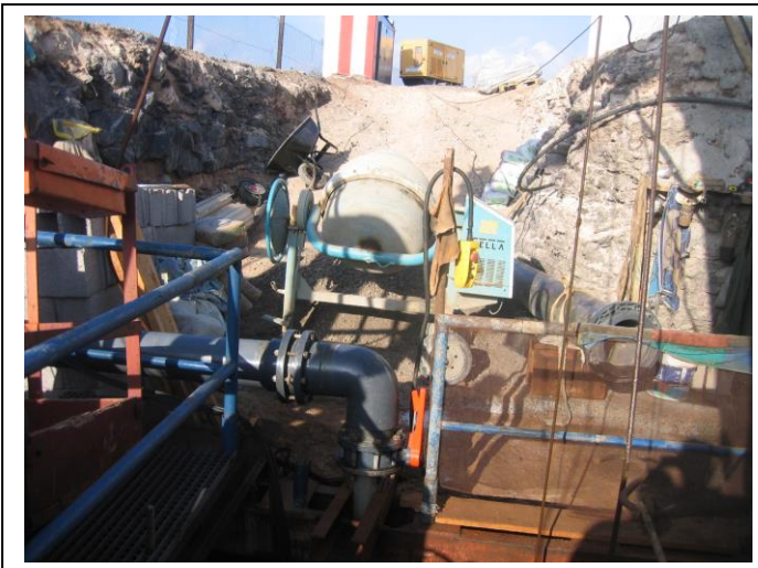
FOTOGRAFÍA N°2.- MUESTRA UNA VISTA DEL POZO QUE TIENE UNA PROFUNDIDAD DE 27 METROS. A LOS 22 M DE PROFUNDIDAD SE HA CONSTRUIDO UNA GALERÍA DE 86 METROS.
