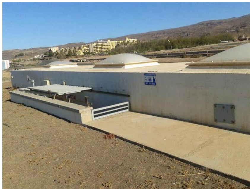
Ilustración 11 Estación de Bombeo. Acceso
