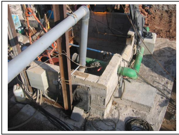
FOTOGRAFÍA N°5.- MUESTRA UNA VISTA DEL BROCAL DEL POZO E INSTALACIONES DEL MISMO.
