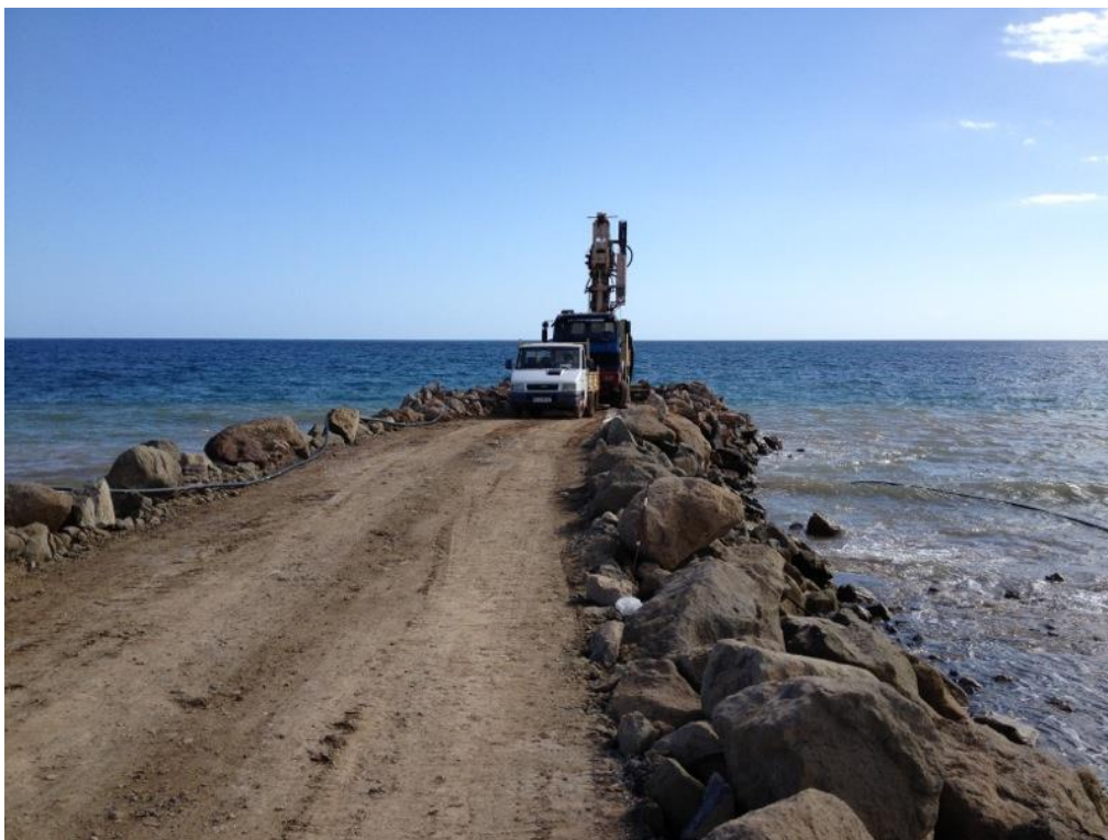
Ilustración 24 Perforación del Sondeo de Conexión a la Galería 1
