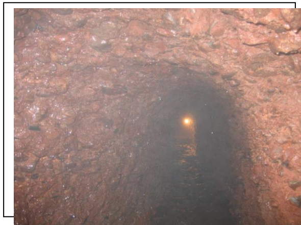
FOTOGRAFÍAS N° 7 Y 8.- MUESTRAN UNA VISTA DEL TERRENO ATRAVESADO POR LA GALERÍA QUE HA LLEGADO A LOS 86 M DE LONGITUD.
