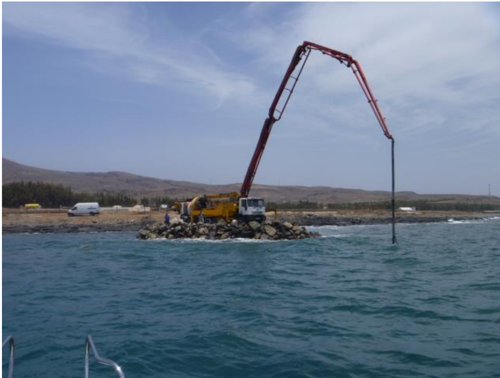
Ilustración 29 Hormigonado de la conducción en zanja (42 metros)
