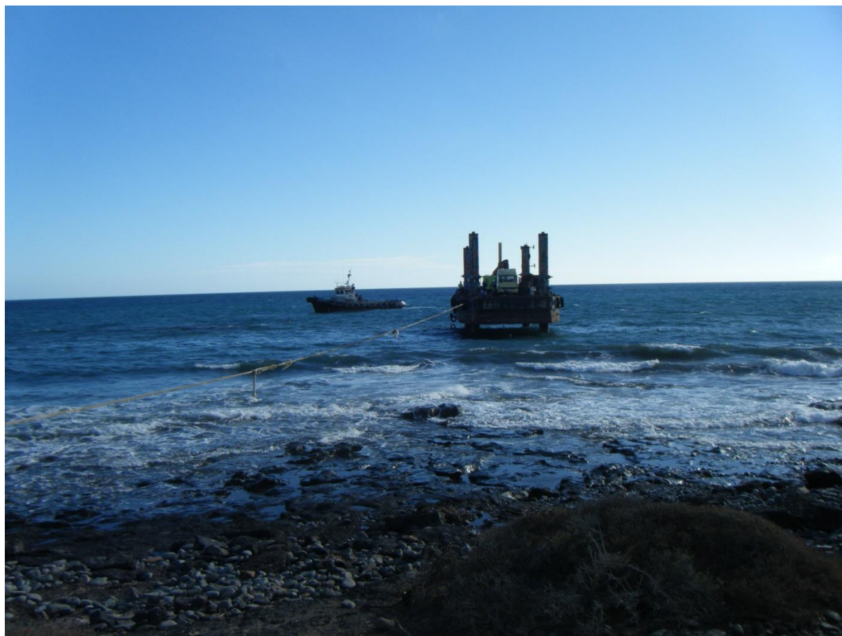
Ilustración 9 Pontona en posición para la ejecución de los Taladros de mejora de permeabilidad
