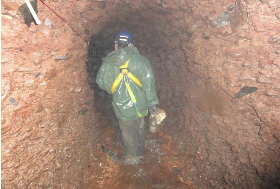
Ilustración 7 Interior de las Galerías sin revestir
