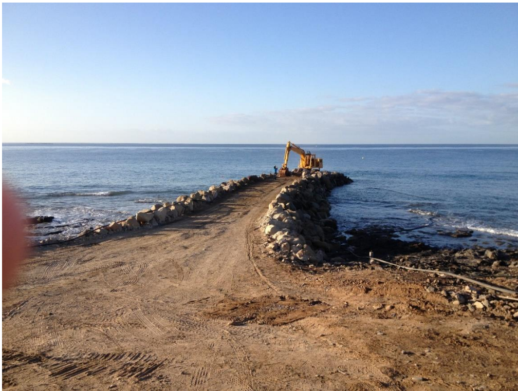
Ilustración 23 Banqueta sobre escollera para perforación de Sondeo de Conexión Galería 1
