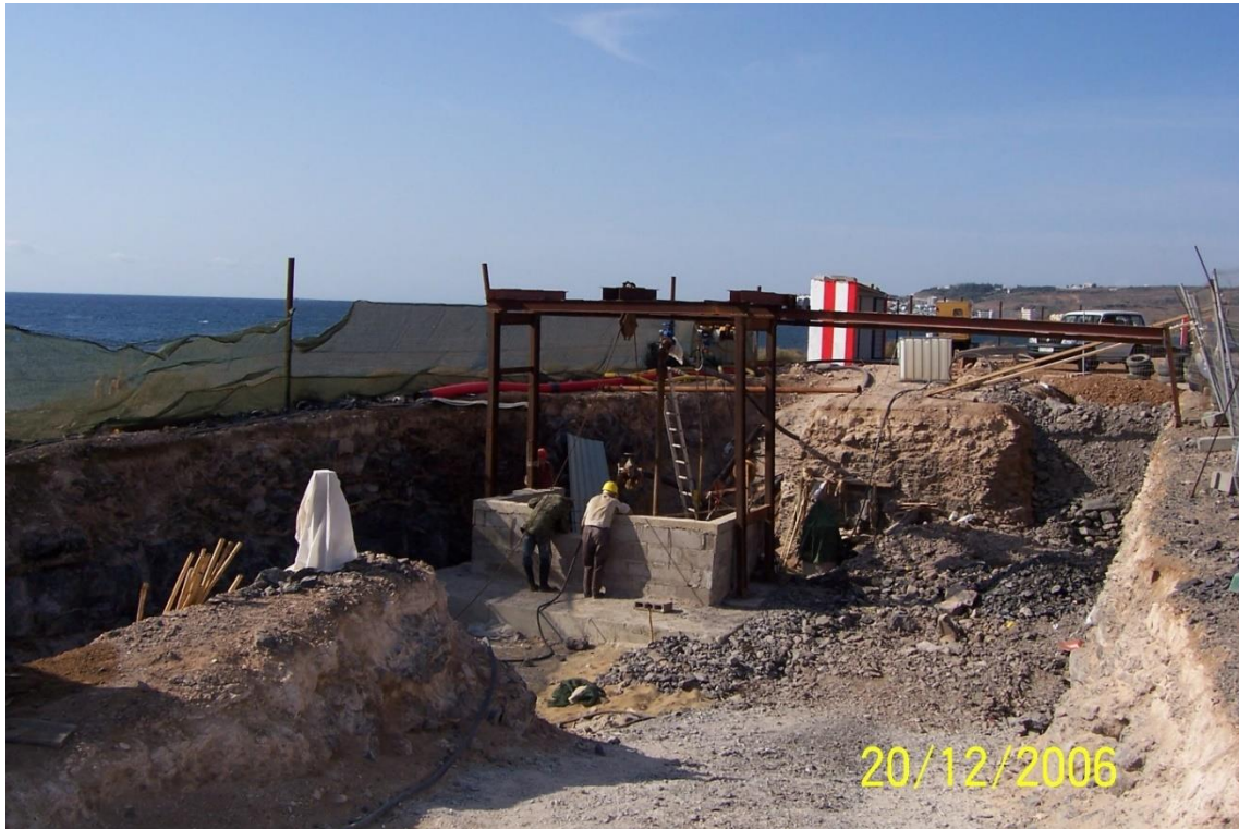
Ilustración 3 Ejecución inicial del Pozo Canario
