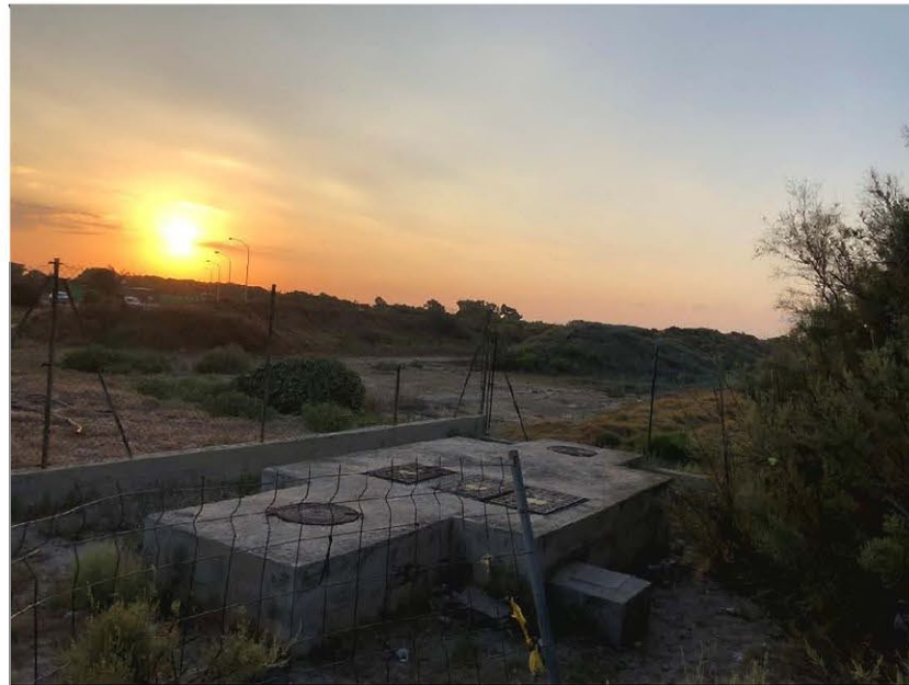
Figura 11. Conjunto de arquetas junto a las antiguas instalaciones deportivas
