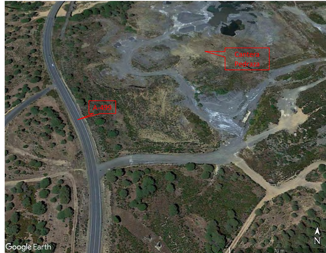
Figura 12. Foto aérea de Google Earth con la situación de la cantera "Pedraza"
