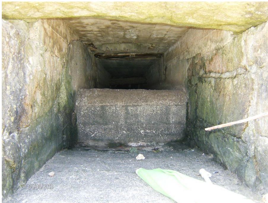
Pared del rebosadero.
