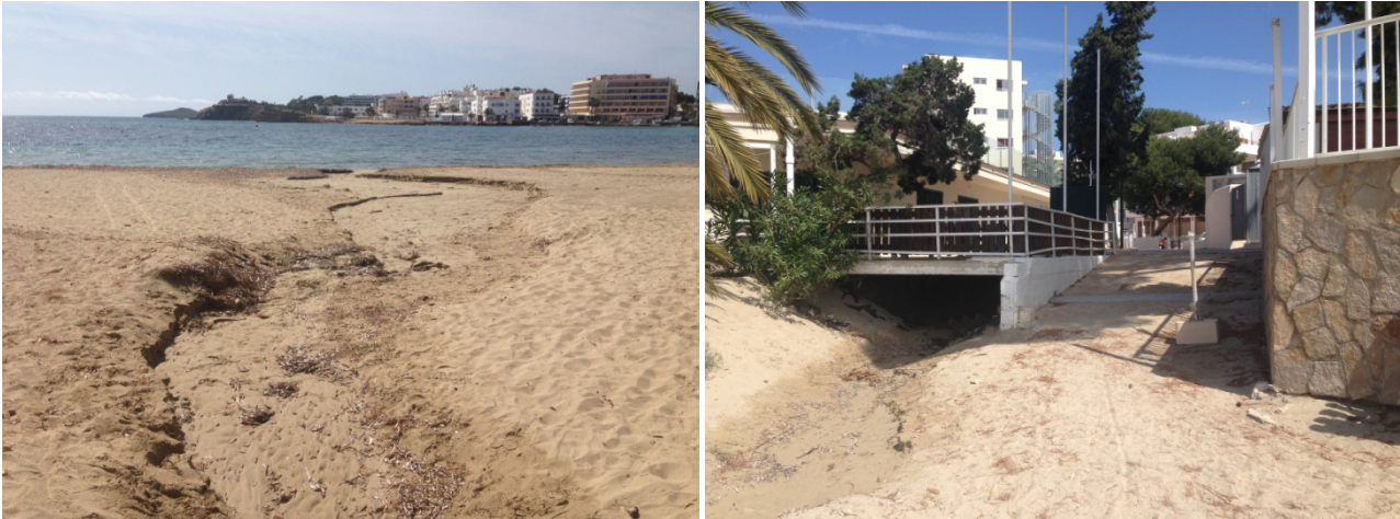
Foto 1.- Área que presenta problemas de arrastre de arena debido a la escorrentía superficial evacuada directamente a la playa desde el punto de vertido actual.
