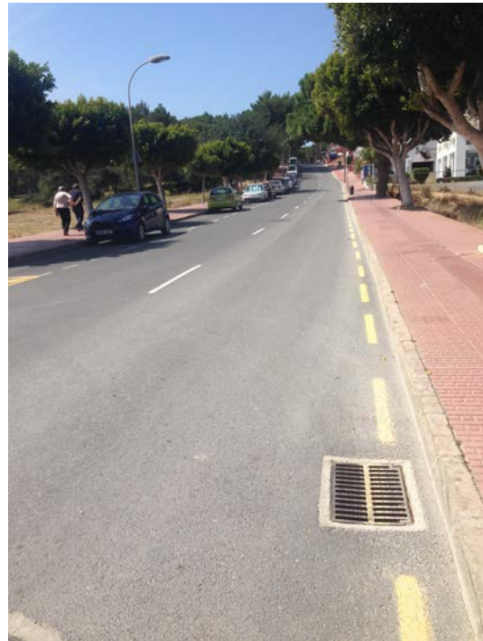
Fotografía 7. Detalle de los imbornales existentes para la recogida de la escorrentía superficial en la avenida Cala Nova. Fuente: Propia.
