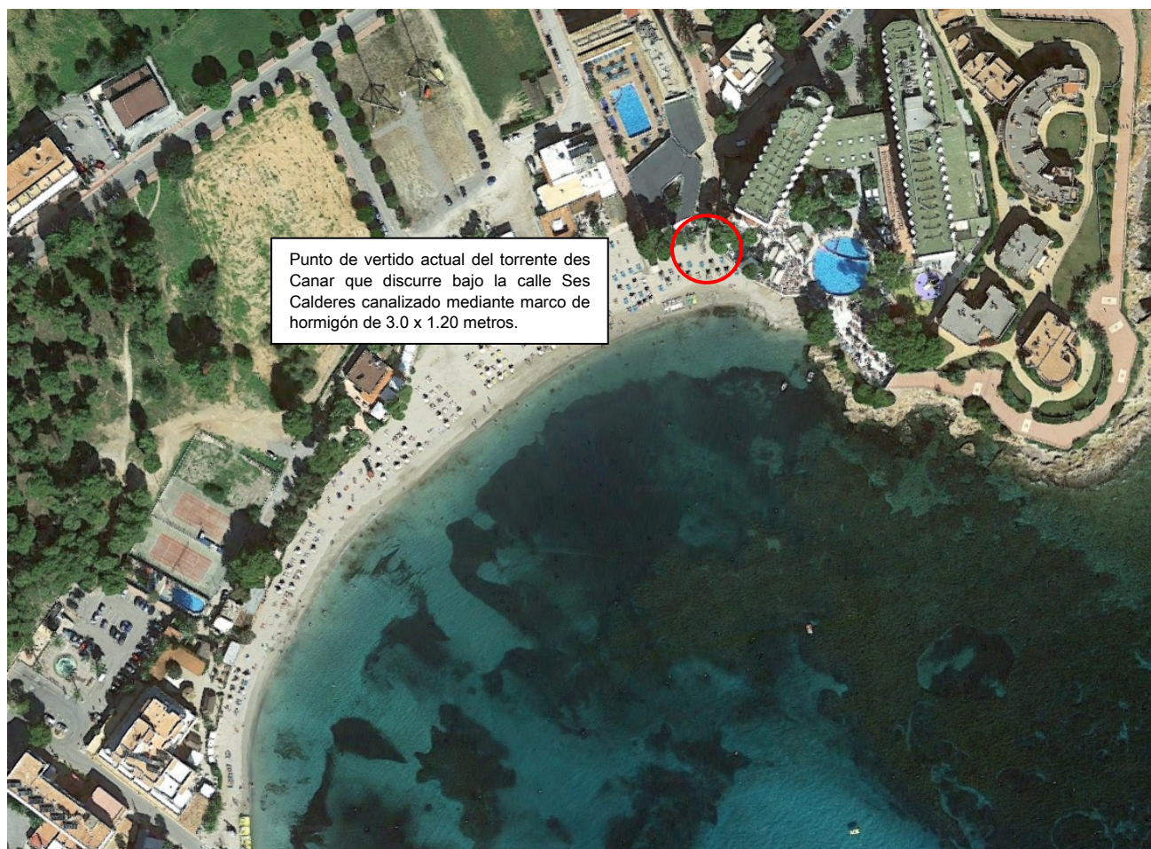
Foto 2. Vista de la playa des Canar y del punto de vertido del encauzamiento del torrente des Canar objeto del proyecto, existente en el extremo Norte.
