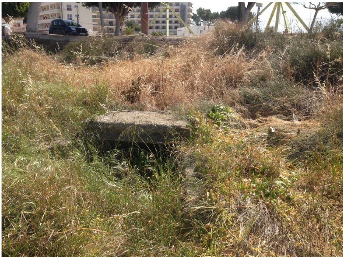
Fotografía 8. Obra de drenaje existente al norte de la avenida Cala Nova. Fuente: Propia.
