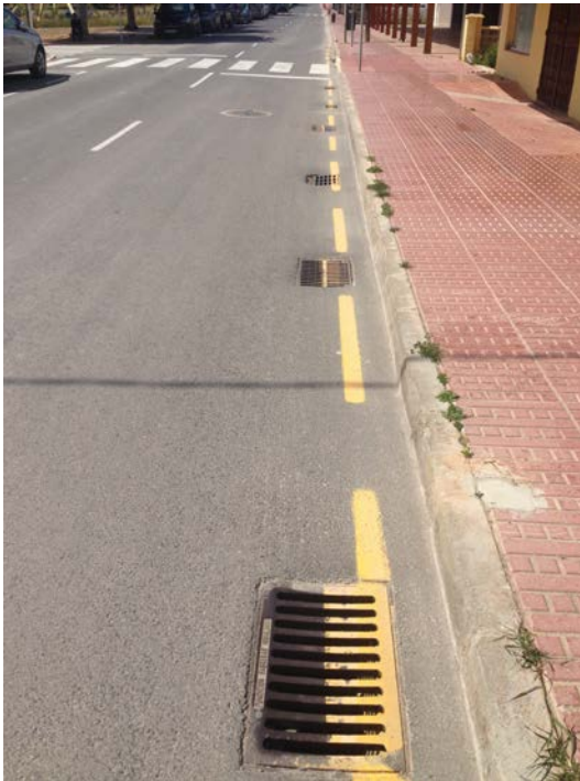
Fotografía 7. Detalle de los imbornales existentes para la recogida de la escorrentía superficial en la avenida Cala Nova. Fuente: Propia.
