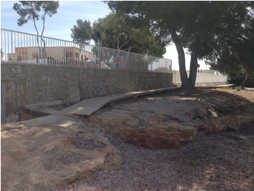
Fotografía 5. Pasarela de madera cercana al nuevo punto de vertido proyectado que conecta la playa de Es Canar con el paseo marítimo situado al este del municipio. Fuente: propia.
