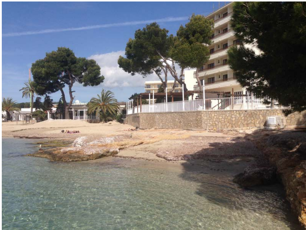
Fotografía 4. Imagen del nuevo emplazamiento donde se situará el nuevo punto de vertido. La prolongación del marco se ejecutará adosada al muro existente del hotel contiguo. Fuente: propia.
