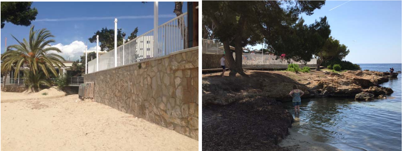
Foto 3. A la izquierda, vista del actual punto de vertido del torrente des Canar en la playa des Canar y fachada del Hotel Miami Ibiza. A la derecha, vista del emplazamiento del nuevo punto de vertido previsto sobre terreno rocoso.
