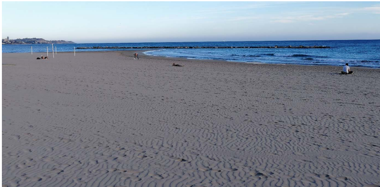
Figura 1 Región septentrional de la Playa del Postiguét vista desde el paseo marítimo (Paseo de Gomiz). Dique exento y hemitómbolo.
