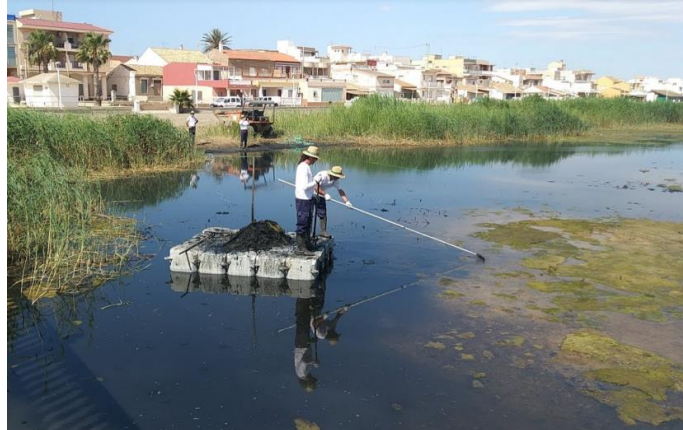
Imagen 2. Plataforma flotante de trabajo en aguas someras
