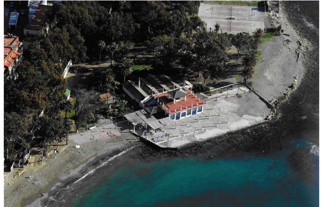
Fotografía 2. Entorno de la plataforma del edificio de los Baños del Carmen
