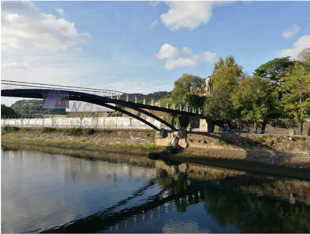
Fotografía 1: Pasarela existente aguas arriba del ámbito
