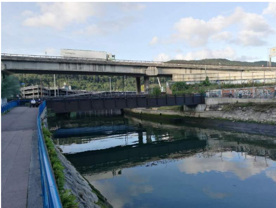
Fotografía 12: Pasarela peatonal existente al final del ámbito
