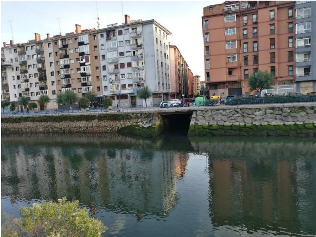
Fotografía 17: Salida de la tajea en Iztieta. Fotografía tomada desde Alzate.
