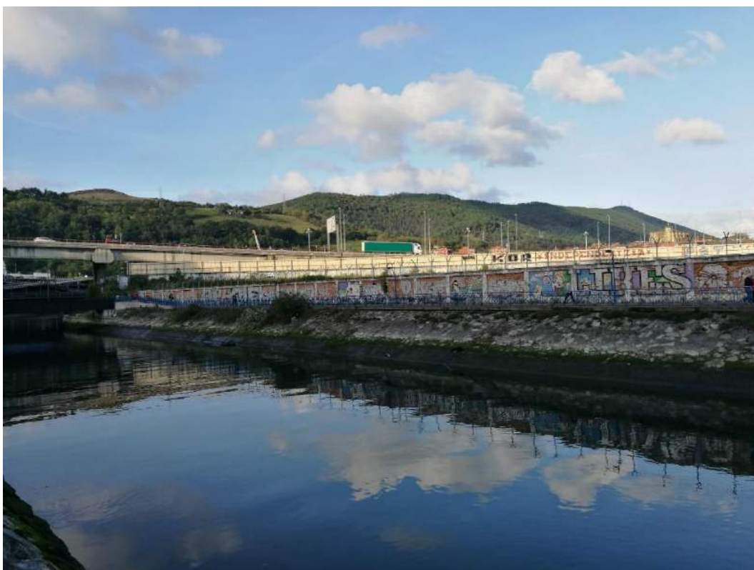
Fotografía 11: Tramo final de la escollera en la margen de Altzate
