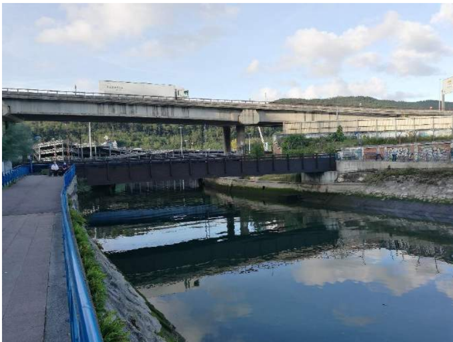
Fotografía: Pasarela de madera existente en Ondartxo (final del ámbito)
