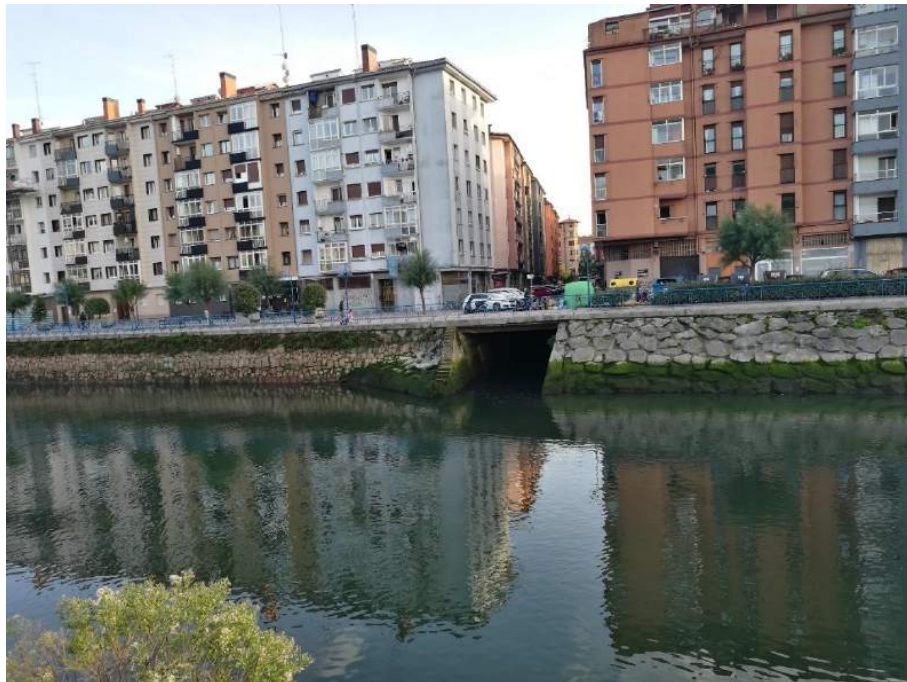
Fotografía: Salida de tajea en Iztietia. Fotografía tomada desde Altzate.
