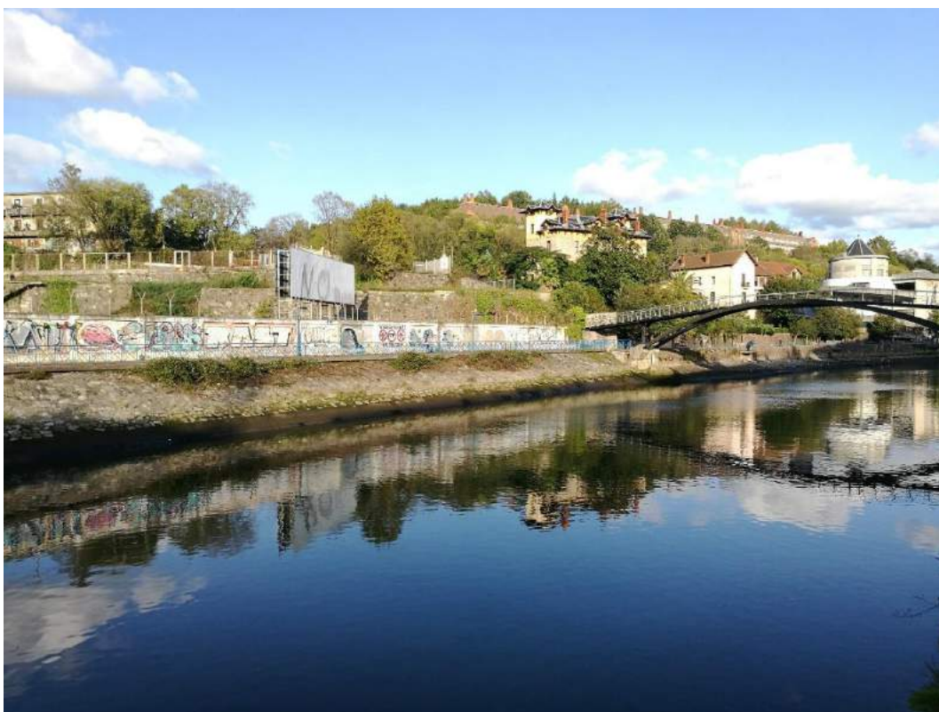
Fotografía 5: Escollera en la margen de Alzate y pasarela existente al fondo
