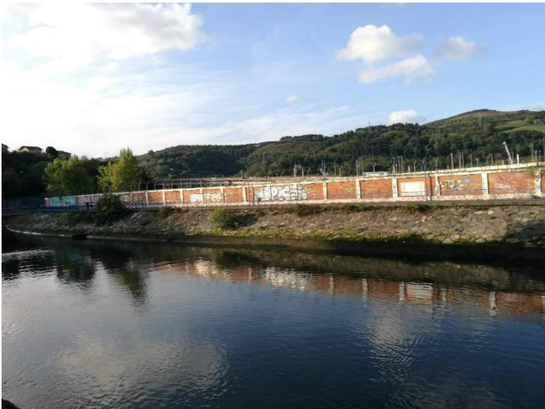
Fotografía 4: Escollera existente en la margen de Altzate
