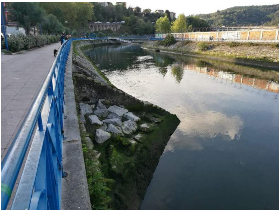
Fotografía 6: Salida de regata en la margen de Iztieta
