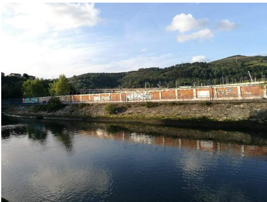
Fotografía: Escollera existente en la margen de Alzate
