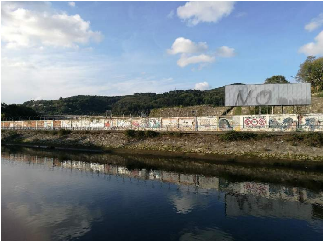
Fotografía 3: Escollera existente en la margen de Altzate
