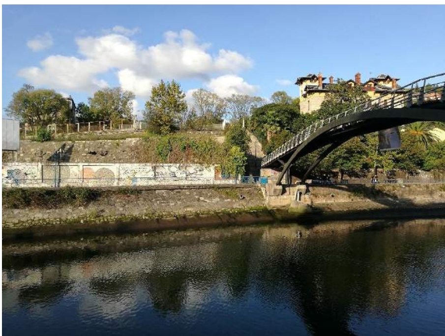
Fotografía: Pasarela existente al comienzo del ámbito (a la altura de Hondarribia Kalea)
