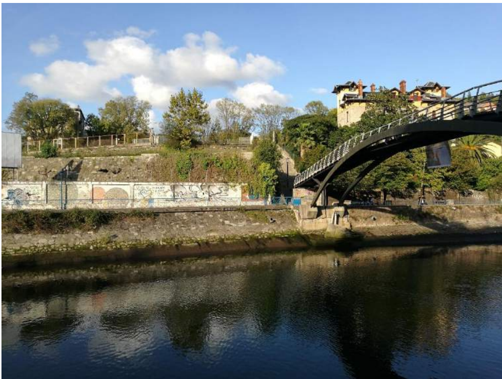
Fotografía nº2: Estribo de la pasarela aguas abajo
