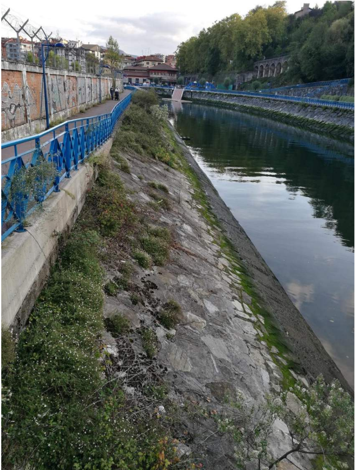
Fotografía 13: Detalle de la escollera en la zona más aguas abajo del ámbito. Se aprecia el paseo peatonal existente, entre el río y el cierre actual del ámbito.
