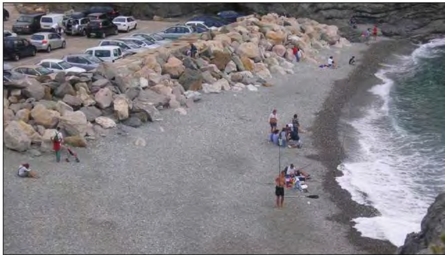
Figura 4. Ejemplo de obra rígida (Fuente: Directrices sobre actuaciones en playa, Dirección General de Costas)
