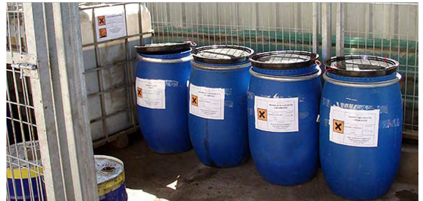
Figura 1. Ejemplo de separación de residuos peligrosos en obra
