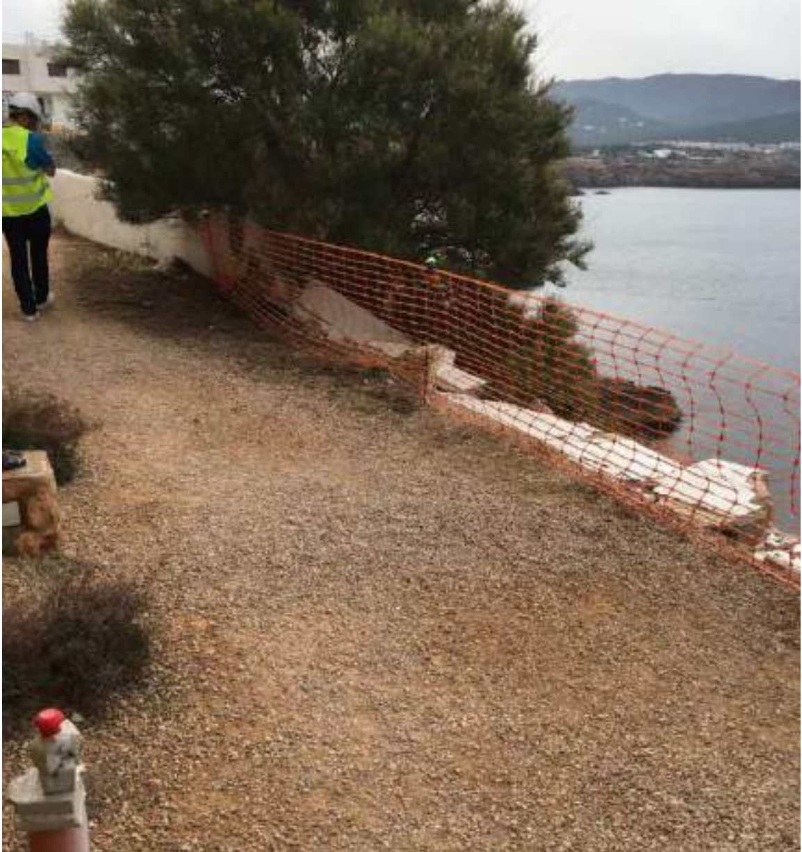
Foto 5: Representación tramo hito 497, (perteneceiente TRAMO 2 EN DPMT)
