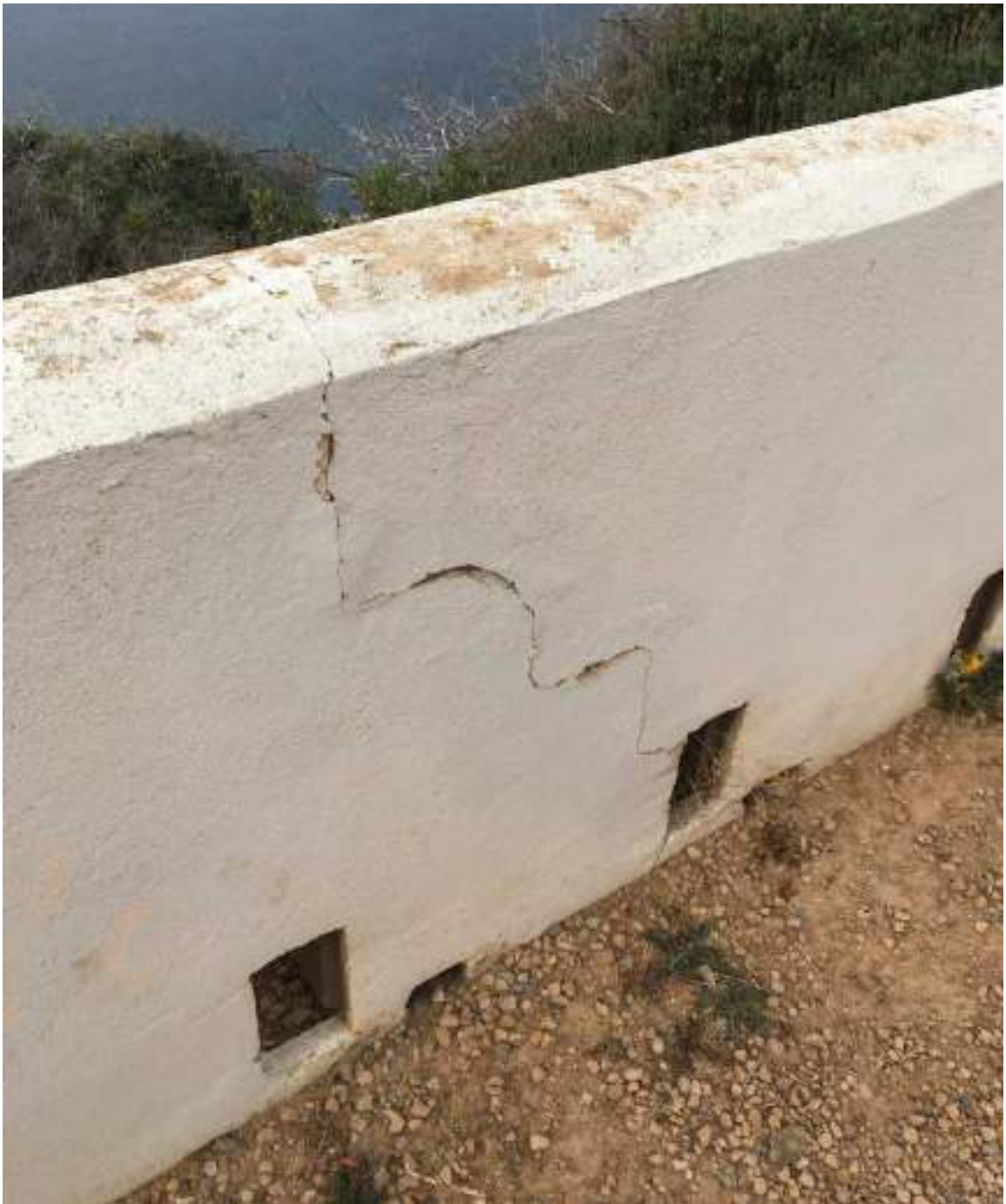
Foto 4: Representación tramo entre hito 495 y 497, (pertenece al TRAMO 2 EN DPMT)
