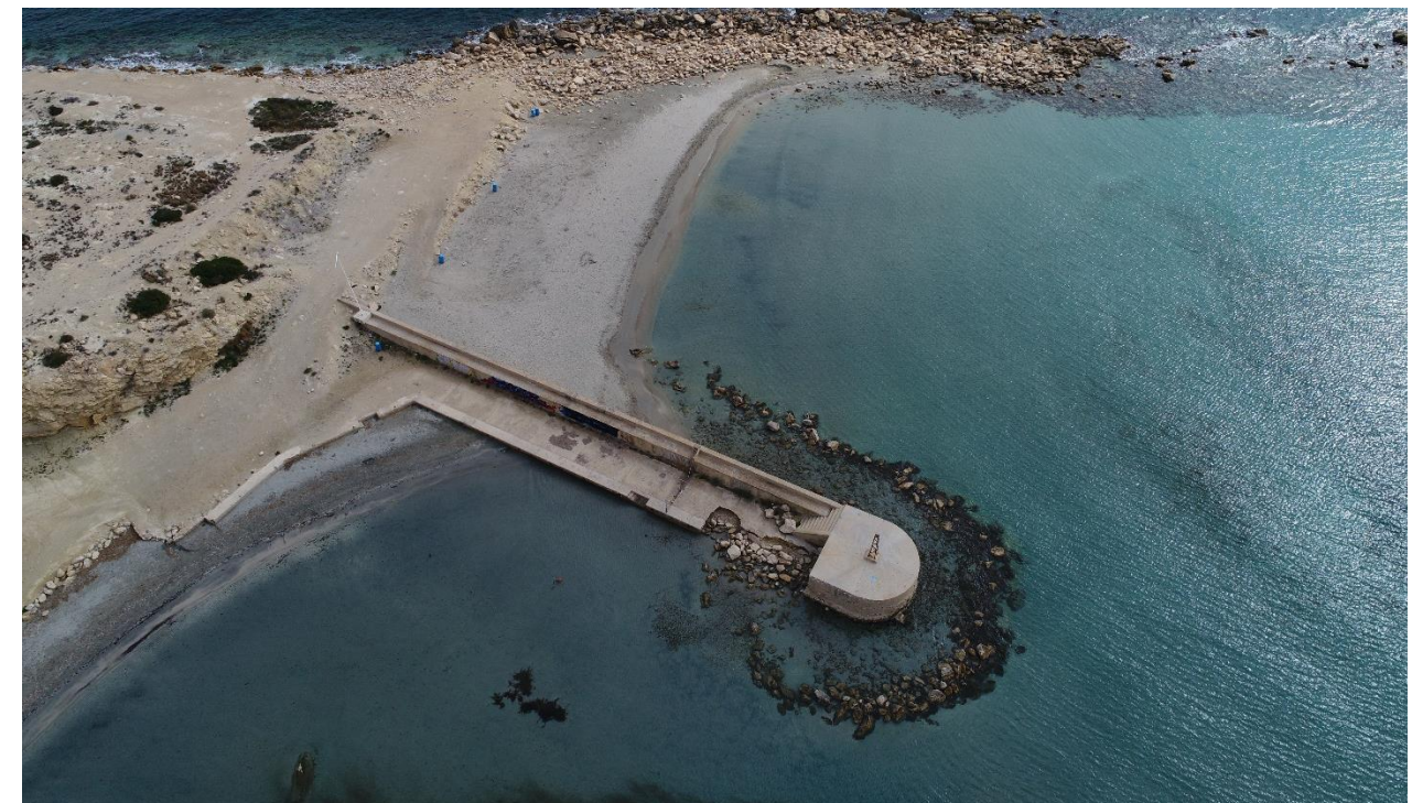
Imagen 2. Situación actual del muelle del hormigón. Fuente: Elaboración propia.
