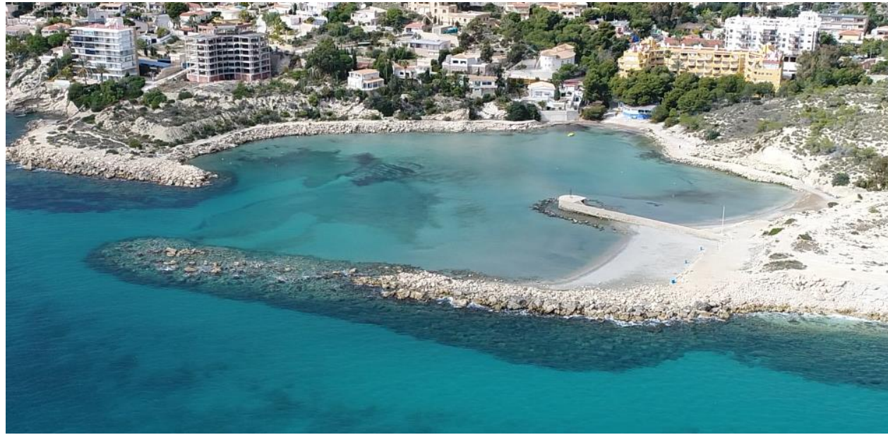
Imagen 3. Situación del actual dique exterior. Fuente: Elaboración propia.
