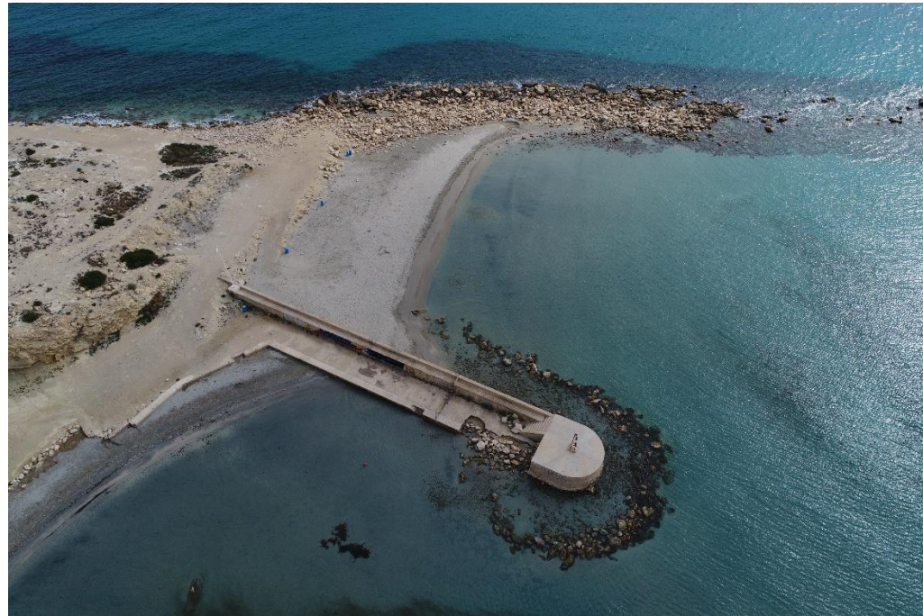
Imagen 16: Fotografía nº14 desde UAV. Fuente: Elaboración propia.
