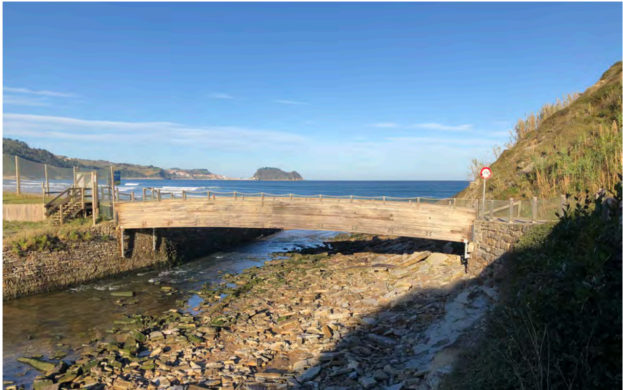
Figura 3. Alzado aguas arriba pasarela existente
