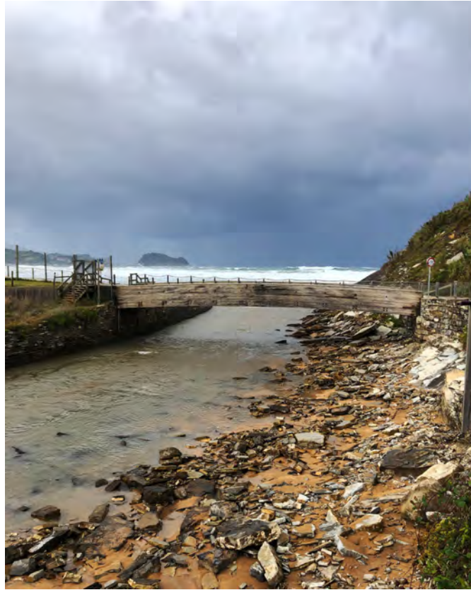
Figura 5. Alzado aguas arriba pasarela existente
