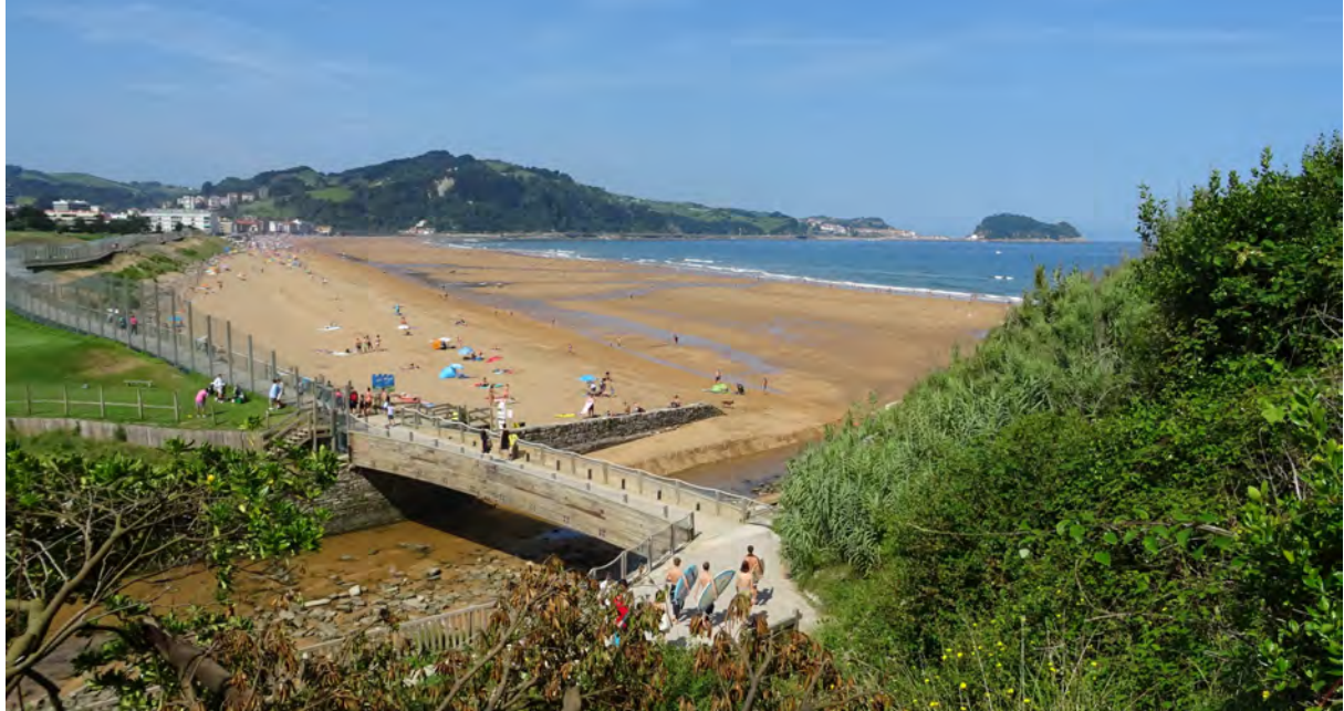
Figura 1. Vista general pasarela existente
