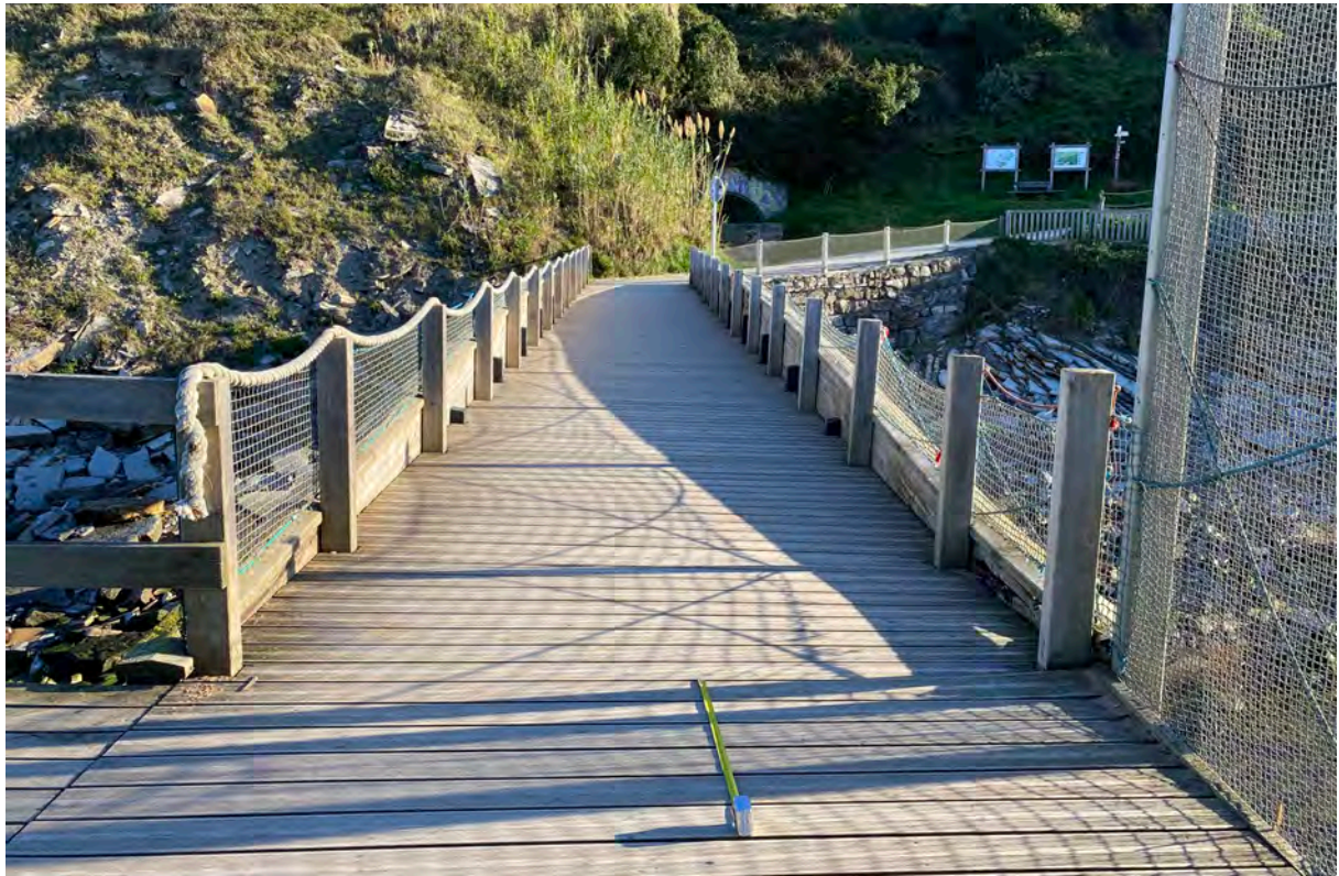
Figura 7. Vista superior pasarela existente
