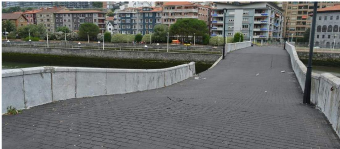
Figura 7. Depresión en la plataforma sobre pila 2
