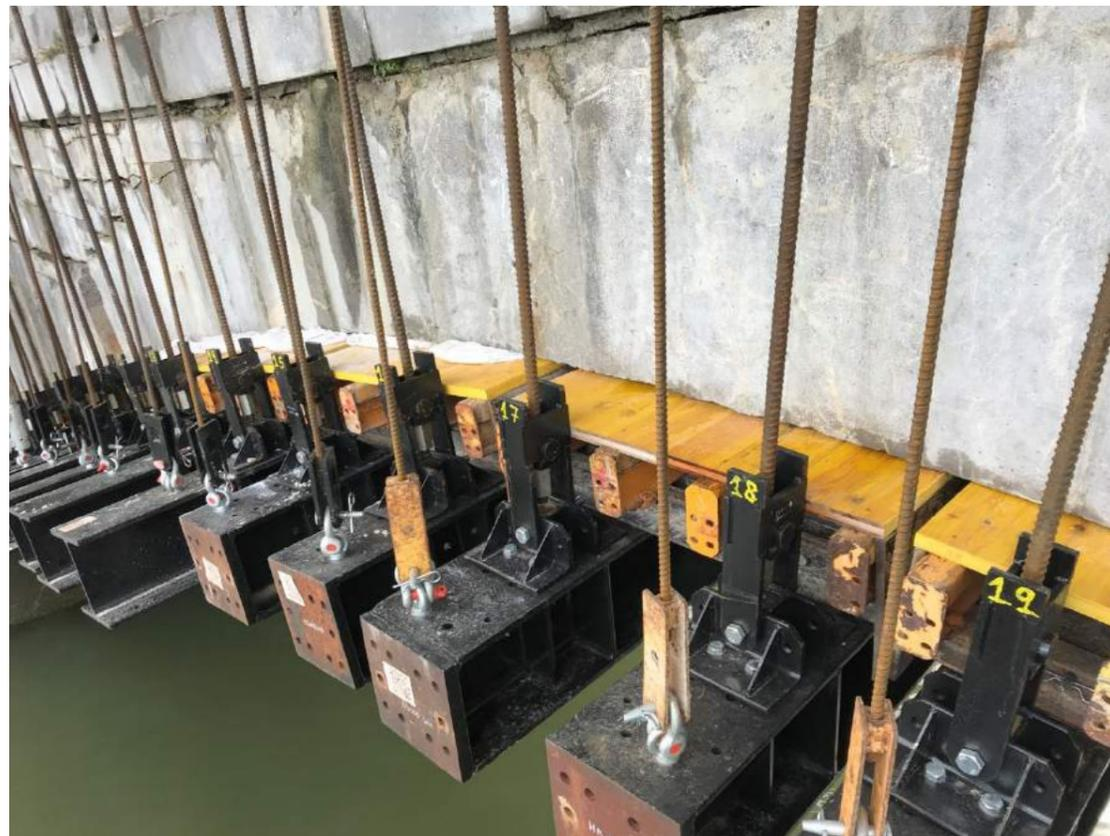
Figura 4. Vista aguas abajo de los encofrados colocados y sujetos mediante las barras de cuelgue
