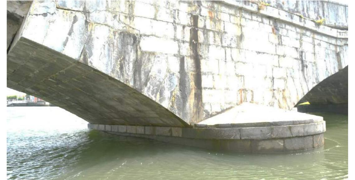
Figura 8. Giro de eje longitudinal de la pila 2, que cabecea hacia aguas abajo
