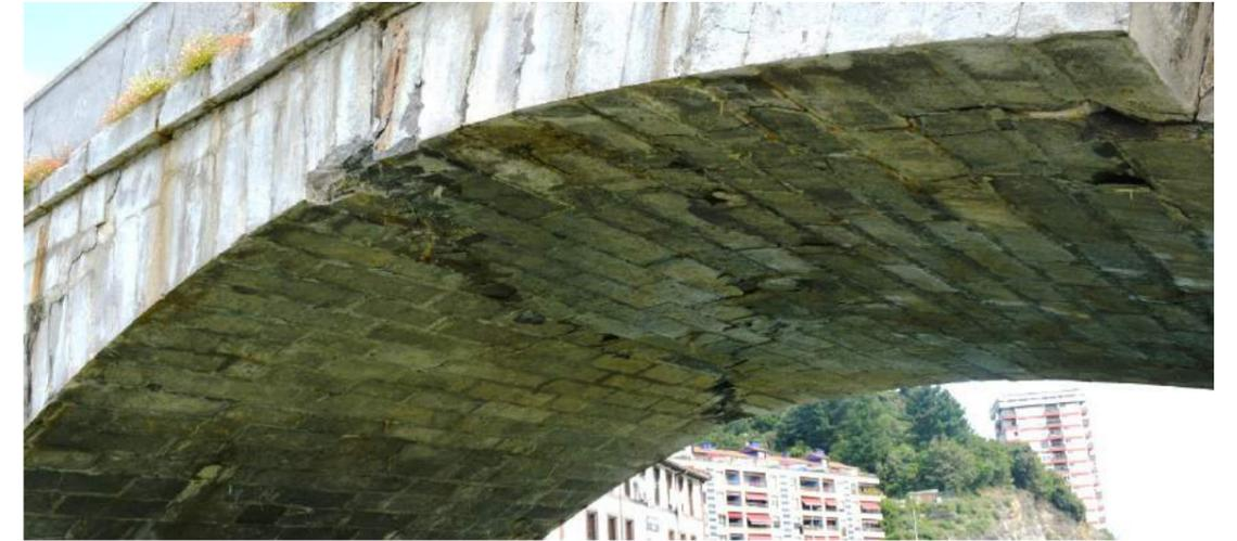
Figura 12. Rotura en compresión de intradós de B-3 desde aguas arriba
