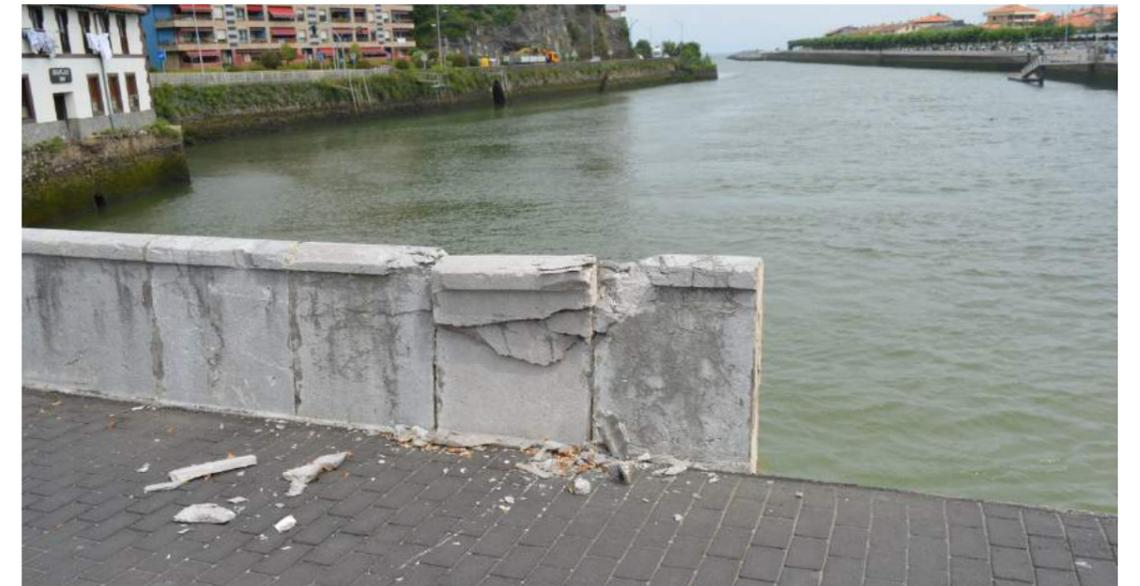
Figura 9. Rotura y pérdida del pretil aguas abajo
