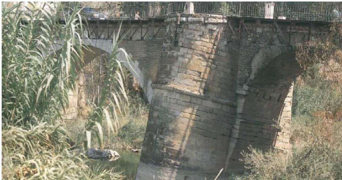
Figura 18. Puente Genil (Córdoba). Tablero reconstituido tras un vuelco parcial de pila y de las bóvedas adyacentes
