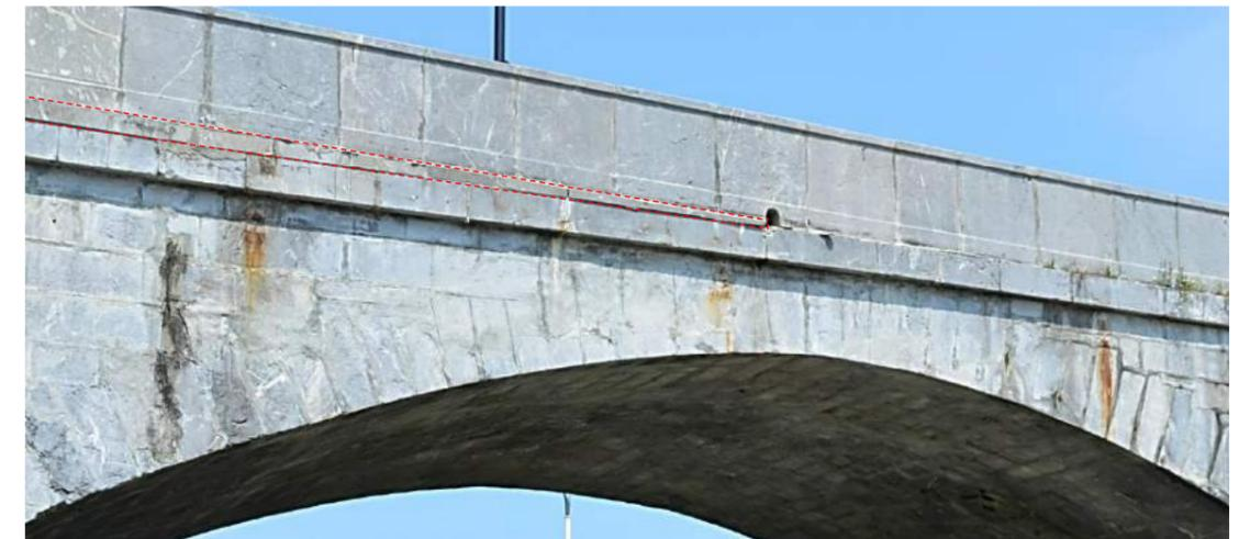
Figura 9. Fotografía actual del alzado de aguas arriba de la bóveda 1. Se observa el recrecido de la imposta utilizado para “horizontalizar” la misma y con ello el pretil y la visual general del puente.
