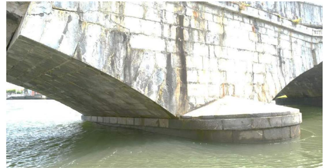
Figura 8. Giro de eje longitudinal de la pila 2, que cabecea hacia aguas abajo
