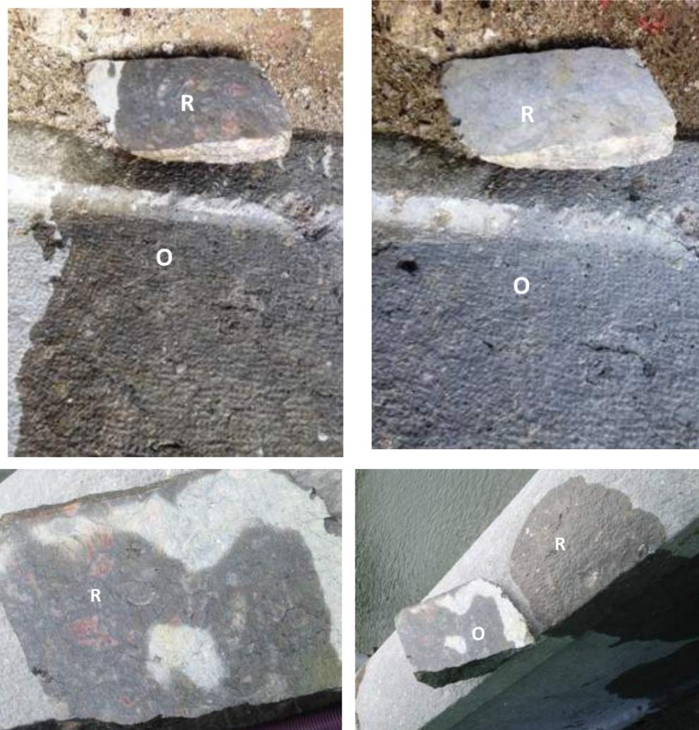
Figura 5. Comprobación entre el aspecto de la piedra original (O) y de reposición (R), seca y húmeda
