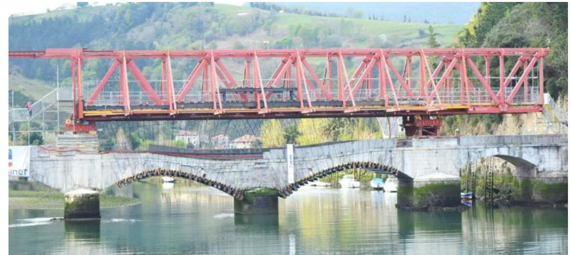
Figura 5. Vista del puente desde aguas abajo, en la configuración que se encuentra una vez finalizada la obra de emergencia, con los elementos de cuelgue dispuestos y la pasarela interna abierta al paso
