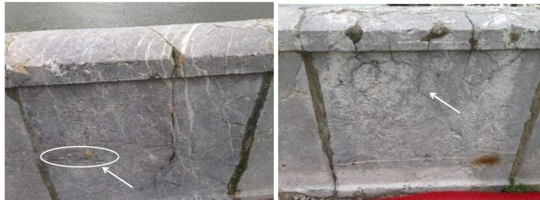
Figura 3. Microfisuras destacadas por la disolución diferencial.
