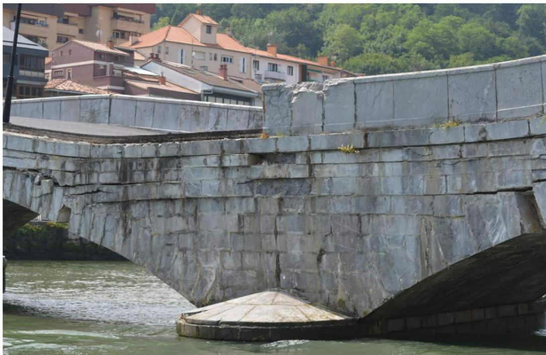
Figura 15. Tímpano con rotura a compresión de sus sillares, pretil roto a compresión y despegue de la bóveda
