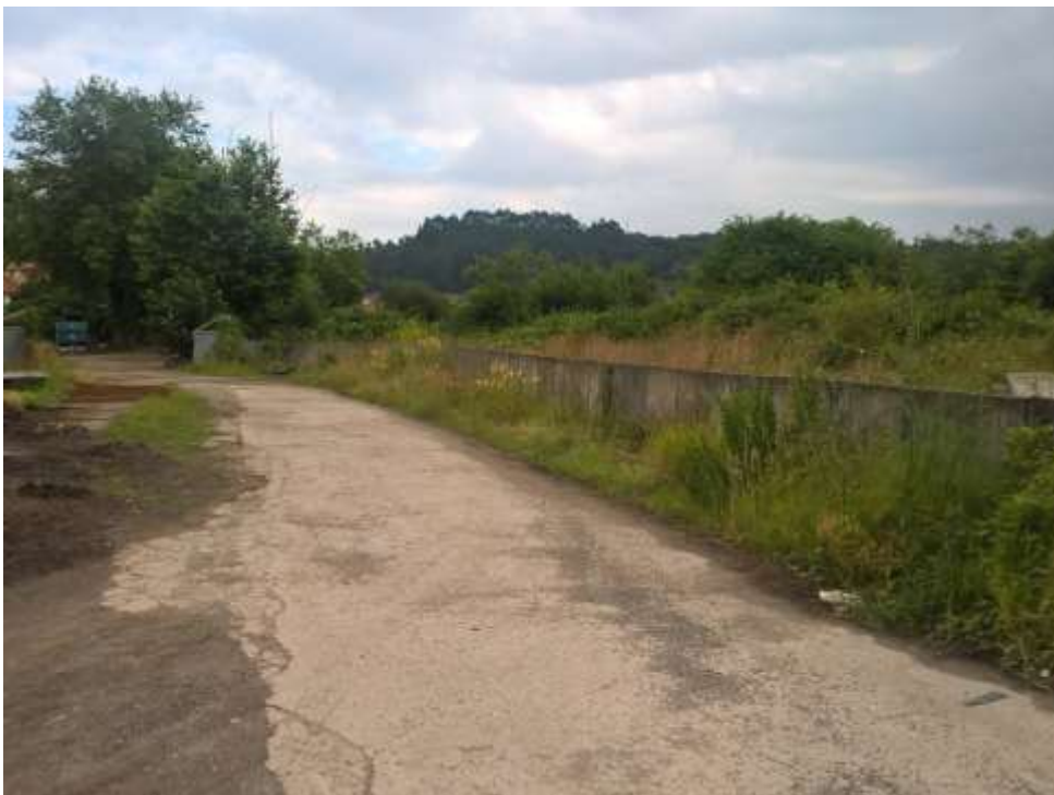
Fotografía nº8: Camino de acceso y muro prefabricado que delimita parte del ámbito.
