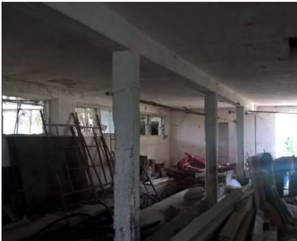
Fotografía nº10: Interior planta baja nave destinada a almacén de aperos.
