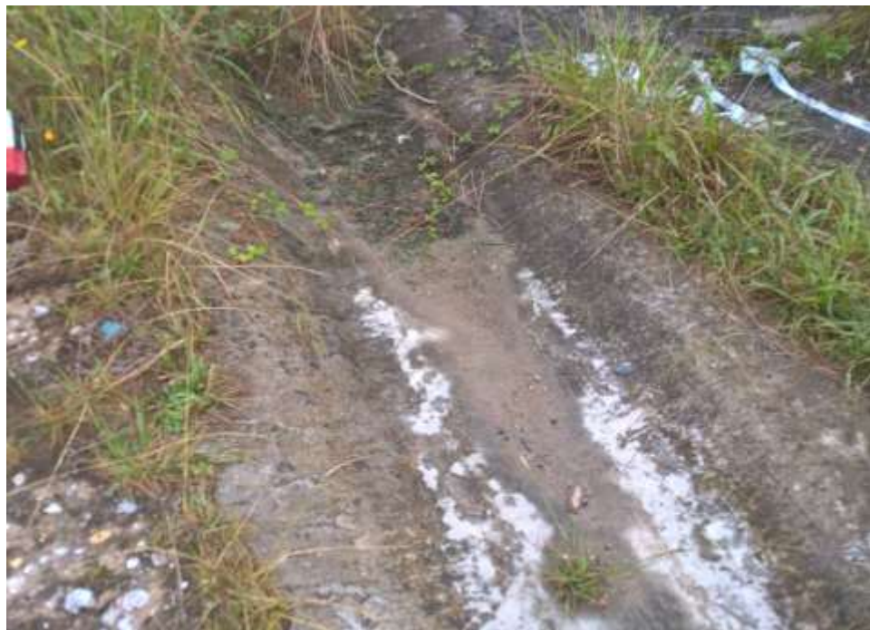
Fotografía nº22: Cuneta existente al norte de la zona de huertos urbanos.
