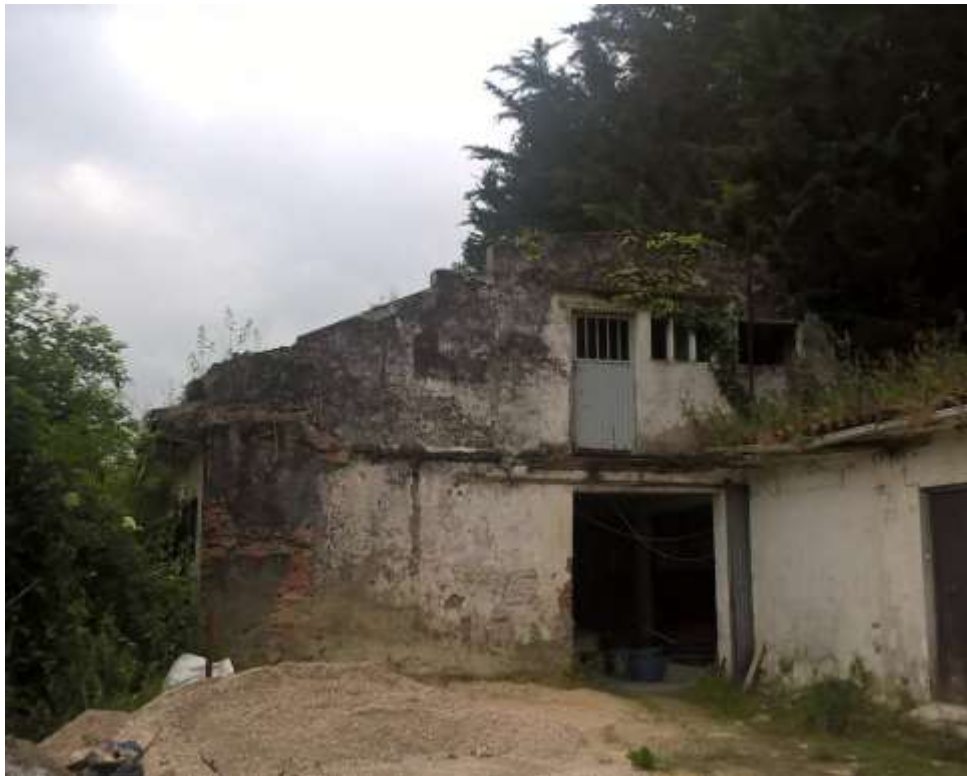
Fotografía nº7: Nave a reformar para almacén de aperos.
