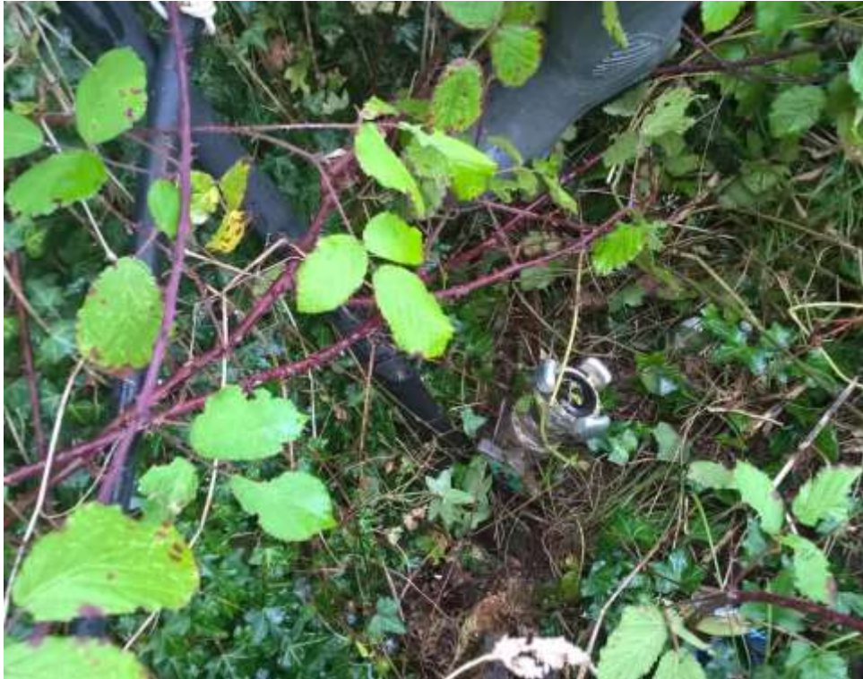
Fotografía nº21: Tubería de abastecimiento de agua existente.
