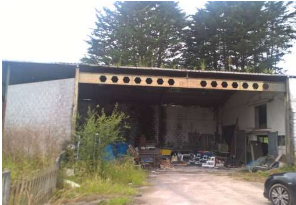
Fotografía nº9: Nave de servicios auxiliares.
