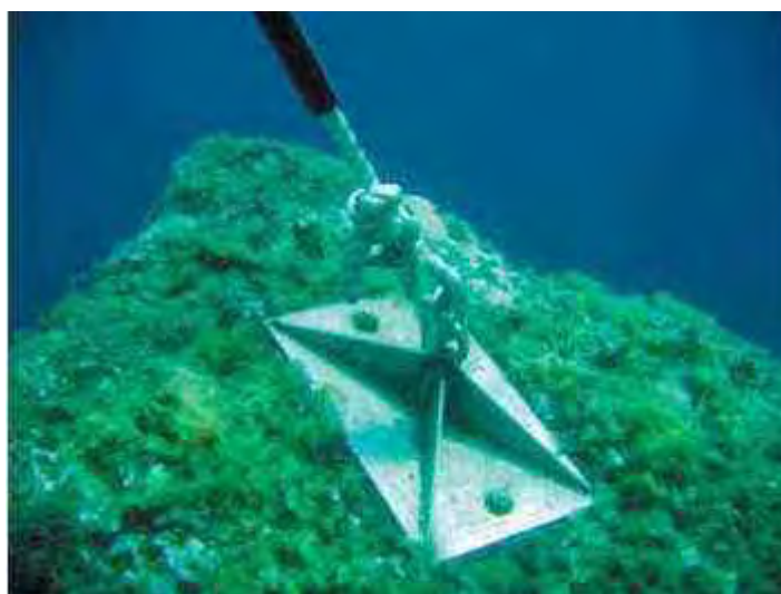
Figura 8.14. Anclaje por tacos químicos sobre lecho rocoso.
