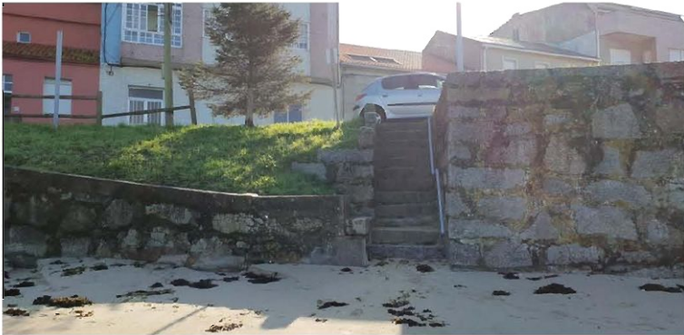
Imagen del actual estado de las escaleras de acceso al arenal de Canelas. La altura de sus tabicadas las convierten en inaccesibles para muchas personas.
