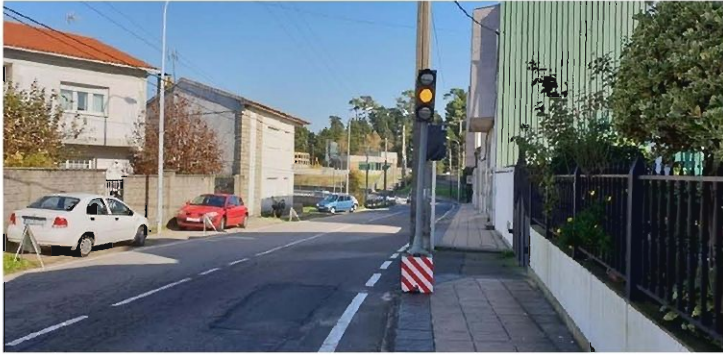
Imagen del tramo final del ámbito y del tercer semáforo de pruebas, actualmente ya retirado.
