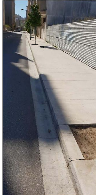
Ejemplo de acera ejecutada en hormigón en la Rúa Ramón López Piñeiro.
