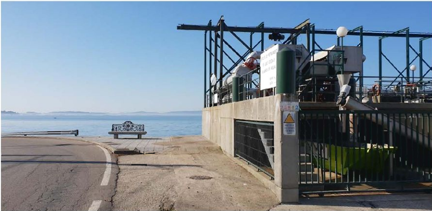
Imagen del estado actual de la EDAR de Vilagarcía de Arousa.
