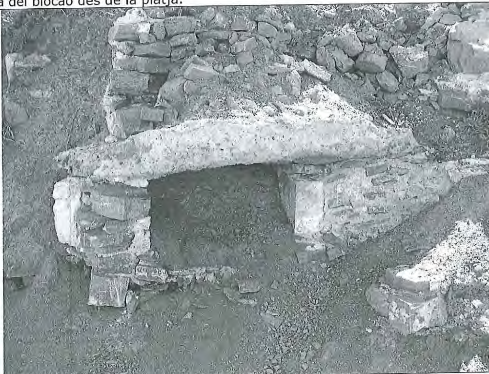
Detall d'un dels accessos del blocao que es troba tapiat per terra.
