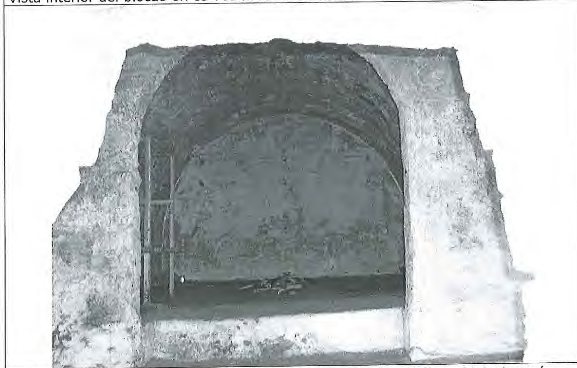
Vista interior del blocao on es pot veure la volta de pedra de l'espai interior més gran.
