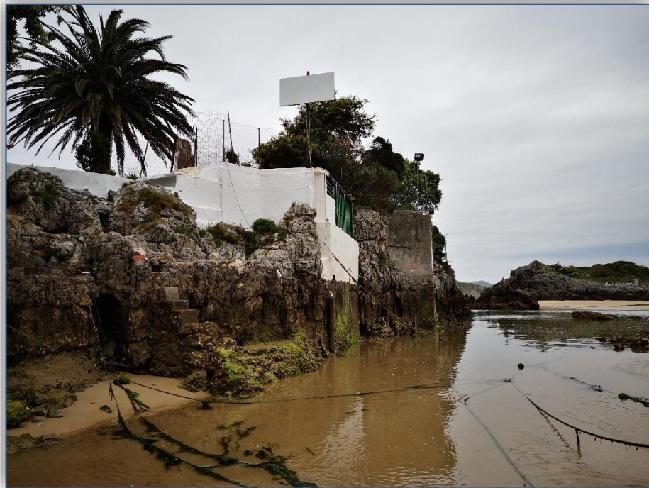
Imagen 10 - Vista forjado cetárea
