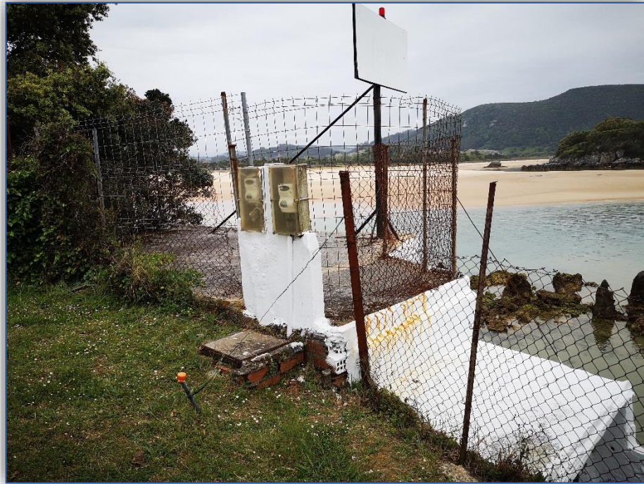
Imagen 09 - Vista forjado cetárea
