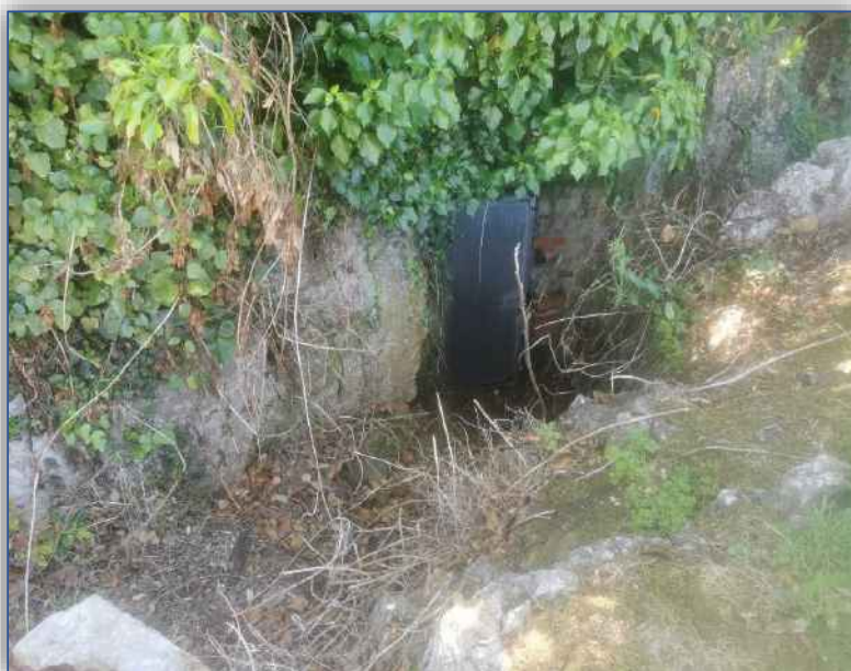
Imagen 06. Vista parte norte cetárea, escaleras y puerta de acceso
