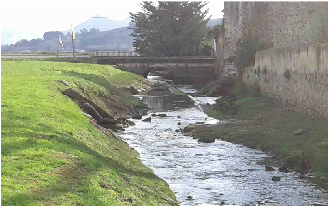
Figura 2. Tubería en el cauce que emerge en el tramo aguas arriba de la carretera CA-148.
