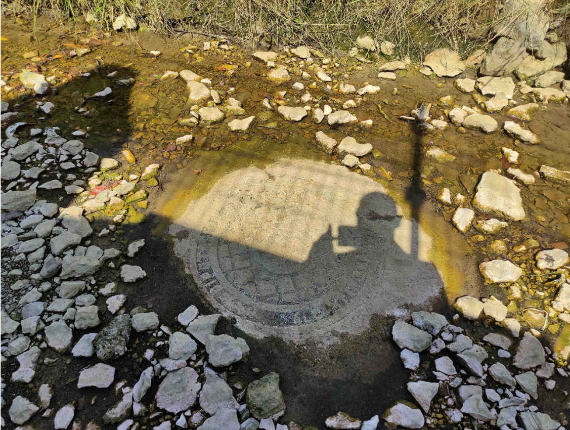
Figura 3. Aspecto de una de las tapas de los pozos existentes en el cauce. La foto se corresponde con una inspección en periodo estival.
