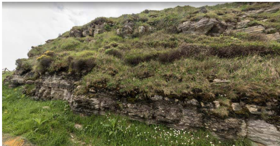
Diferencia de vegetación de acantilado con vegetación herbácea presente en el perímetro de los accesos
