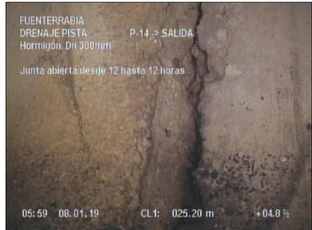
Fotografía: 84_4b 25,1m, Junta abierta desde 12 hasta 12 horas
