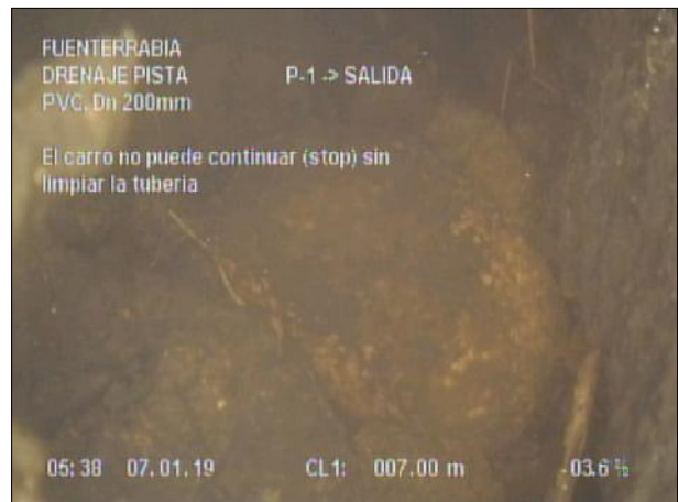
Fotografía: 4_3b 7m, El carro no puede continuar (stop) sin limpiar la tubería
