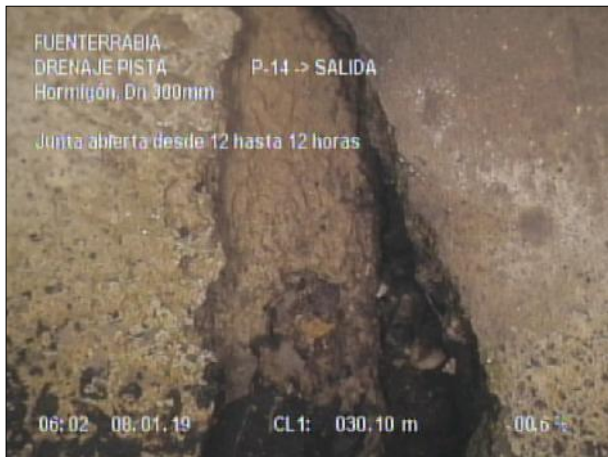
Fotografía: 86_6a 30,1m, Junta abierta desde 12 hasta 12 horas
