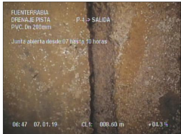
Fotografía: 25_5a 8,6m, Junta abierta desde 07 hasta 10 horas
