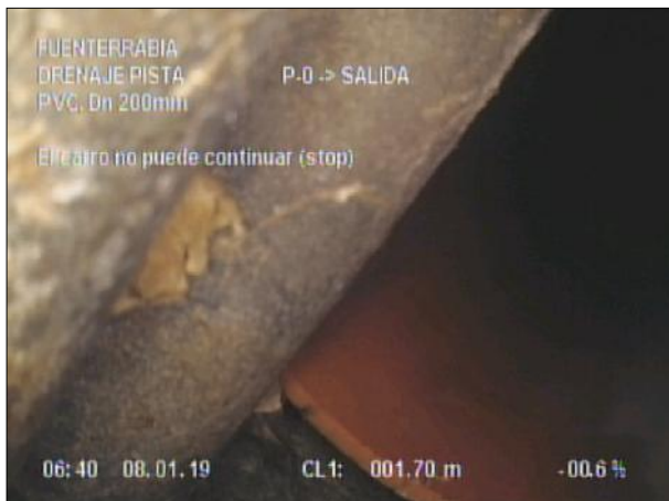
Fotografía: 91_3a 1,7m, El carro no puede continuar (stop)
