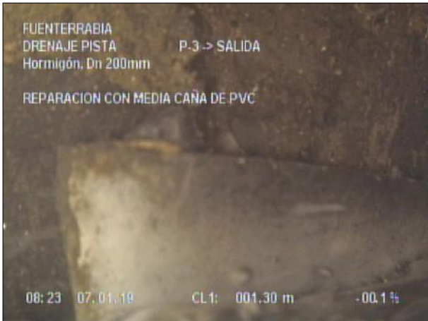
Fotografía: 13_2a 0,3m, REPARACION CON MEDIA CAÑA DE PVC
