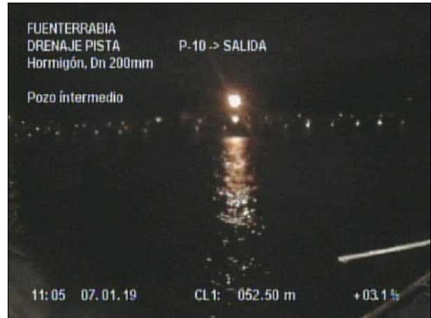
Fotografía: 54_8b 51,7m, Pozo intermedio
