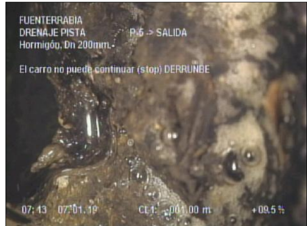
Fotografía: 31_2b 1m, El carro no puede continuar (stop) DERRUNBE
