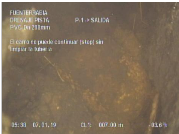
Fotografía: 4_3a 7m, El carro no puede continuar (stop) sin limpiar la tubería
