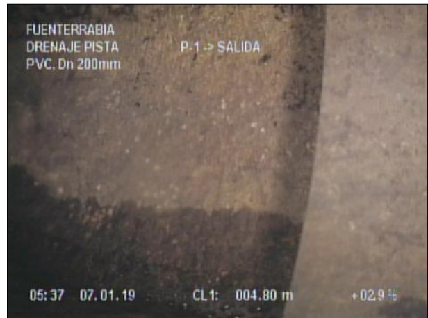
Fotografía: 3_2b 4,6m, Cambio del material. Nuevo material hormigon)
