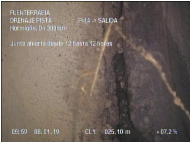
Fotografía: 84_4a 25,1m, Junta abierta desde 12 hasta 12 horas
