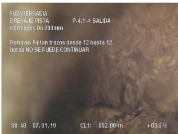
Fotografía: 40_3a 2m, Roturas. Faltan trozos desde 12 hasta 12 horas NO SE PUEDE CONTINUAR
