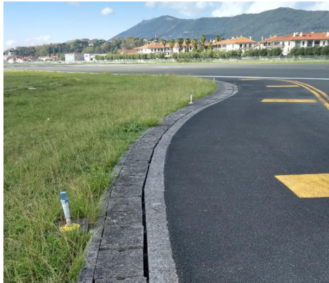
Imagen 1. Canaleta de drenaje existente. Fuente: Elaboración propia.
