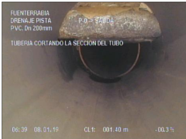
Fotografía: 90_2a 1,4m, TUBERÍA CORTANDO LA SECCION DEL TUBO
