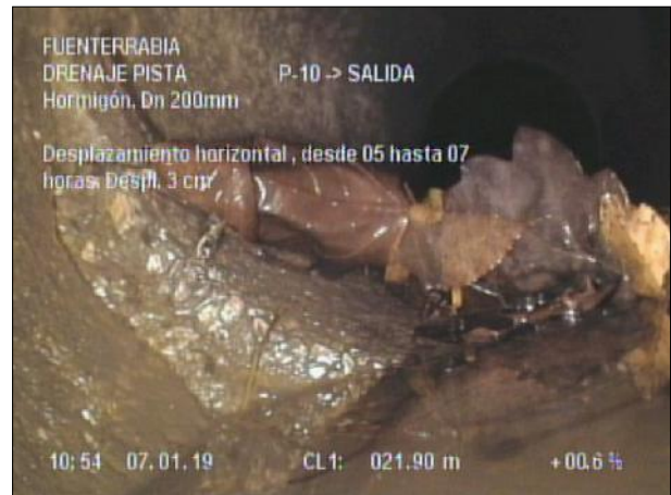
Fotografía: 48_2b 21,9m, Desplazamiento horizontal , desde 05 hasta 07 horas. Despl. 3 cm
