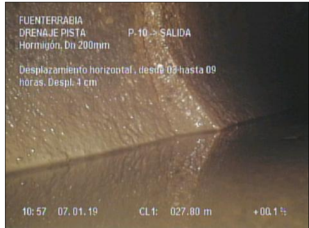
Fotografía: 50_4b 27,8m, Desplazamiento horizontal, desde 03 hasta 09 horas. Despl. 4 cm
