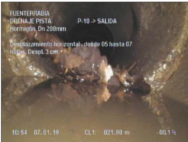
Fotografía: 48_2a 21,9m, Desplazamiento horizontal , desde 05 hasta 07 horas. Despl. 3 cm
