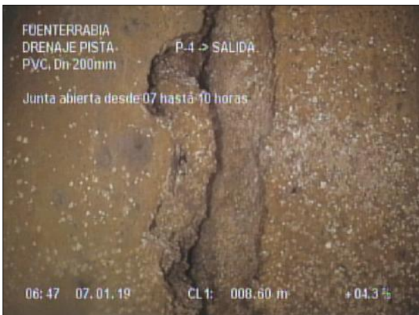
Fotografía: 25_5b 8,6m, Junta abierta desde 07 hasta 10 horas
