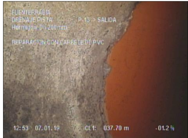
Fotografía: 78_4b 37,5m, REPARACION CON CARRETE DE PVC
