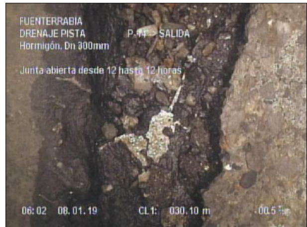
Fotografía: 86_6b 30,1m, Junta abierta desde 12 hasta 12 horas
