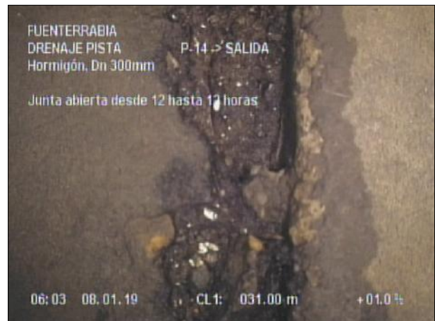
Fotografía: 87_7b 31m, Junta abierta desde 12 hasta 12 horas
