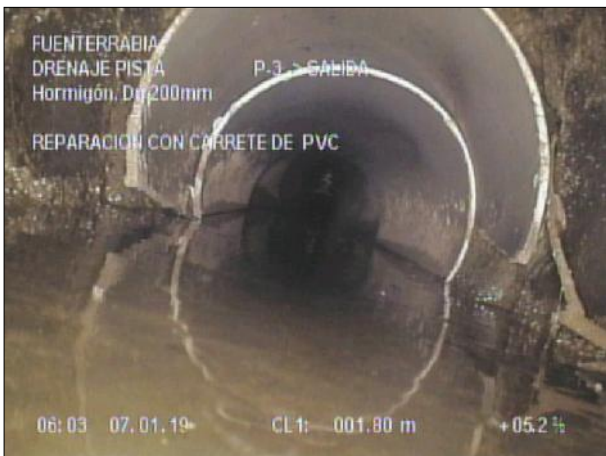
Fotografía: 10_3a 1,8m, REPARACION CON CARRETE DE PVC
