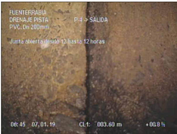
Fotografía: 24_4a 3,6m, Junta abierta desde 12 hasta 12 horas
