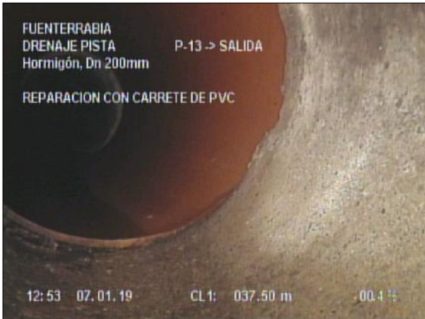
Fotografía: 78_4a 37,5m, REPARACION CON CARRETE DE PVC
