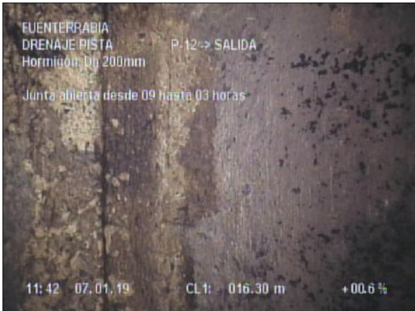
Fotografía: 61_4a 16,3m, Junta abierta desde 09 hasta 03 horas
