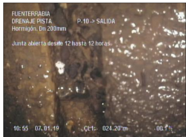
Fotografía: 49_3b 24,2m, Junta abierta desde 12 hasta 12 horas
