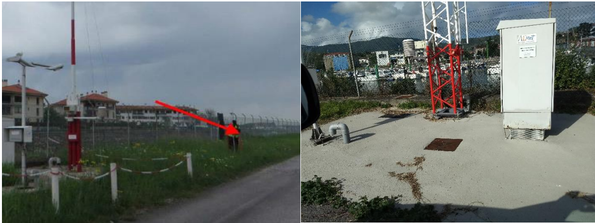
Imagen 24 (Izq) Postes LESO-OBS-00124-00X-2015, (der) Nuevas instalaciones. Fuente: Elaboración propia.
