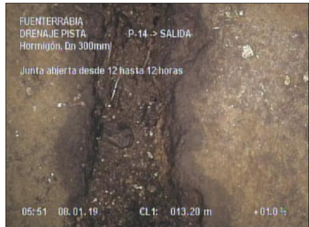
Fotografía: 82_2b 13,2m, Junta abierta desde 12 hasta 12 horas
