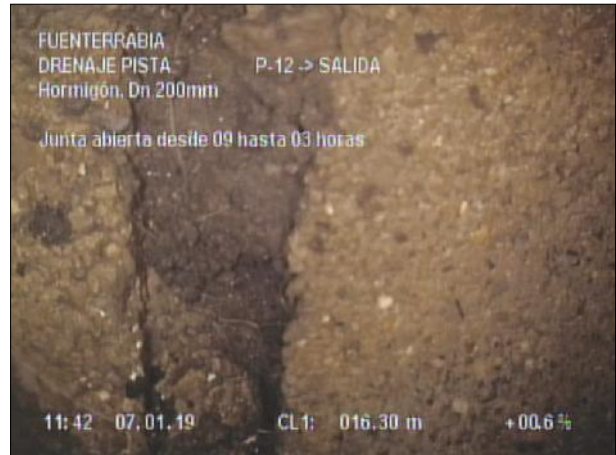
Fotografía: 61_4b 16,3m, Junta abierta desde 09 hasta 03 horas
