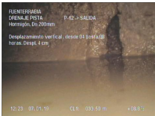
Fotografía: 69_5a 33,5m, Desplazamiento vertical, desde 04 hasta 08 horas. Despl. 4 cm
