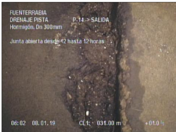
Fotografía: 87_7a 31m, Junta abierta desde 12 hasta 12 horas
