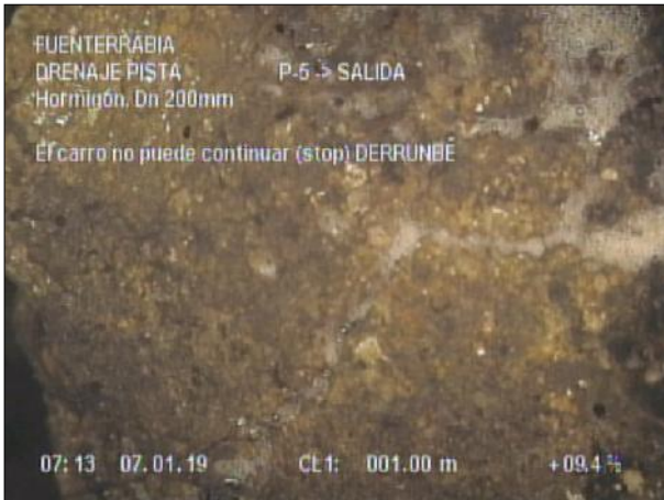
Fotografía: 31_2a 1m, El carro no puede continuar (stop) DERRUNBE
