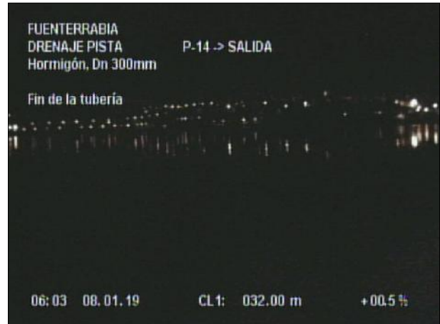
Fotografía: 88_8b 32,1m, Fin de la tubería
