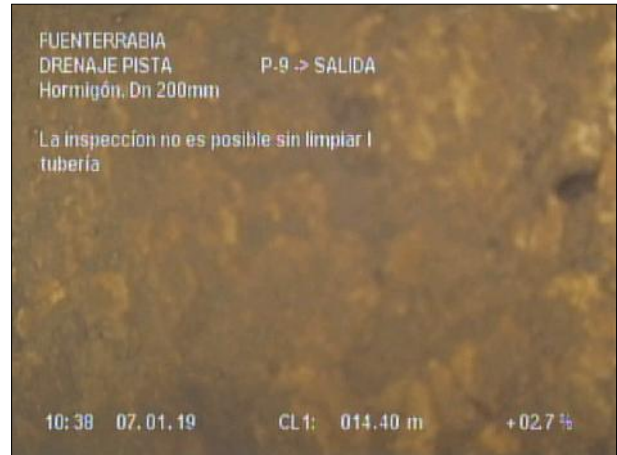
Fotografía: 46_2b 14,4m, La inspección no es posible sin limpiar l tubería
