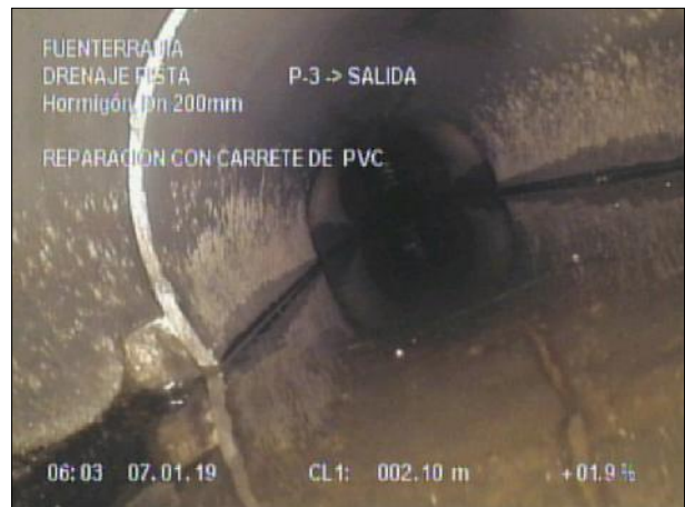
Fotografía: 10_3b 1,8m, REPARACION CON CARRETE DE PVC
