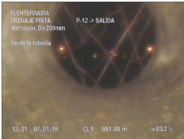
Fotografía: 74_10a 52,3m, Fin de la tubería
