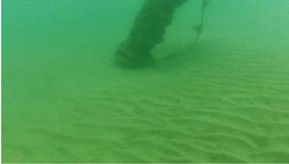
Vista general de la conducción de 800 mm totalmente enterrada. Sólo asoma la derivación y el difusor.
