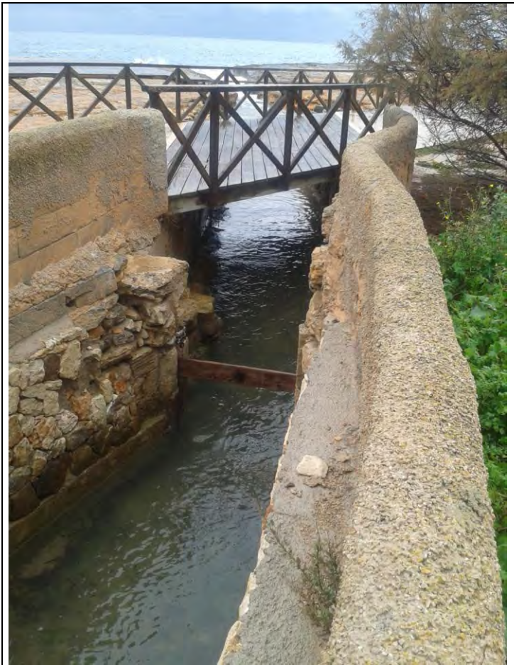
Fotografía 8. Vista del puente peatonal sobre el canal de entrada
