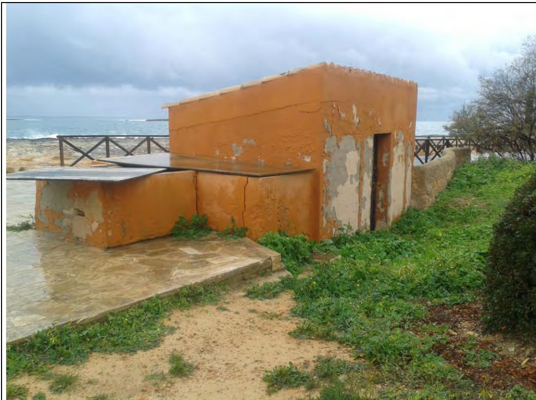
Fotografía 7. Vista de la caseta de bombeo con su acceso.
