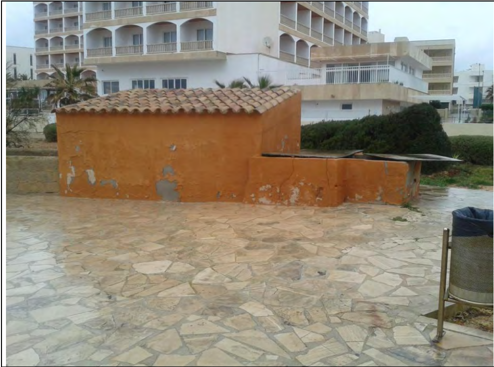
Fotografía 5. Otra vista de la caseta de bombeo.
