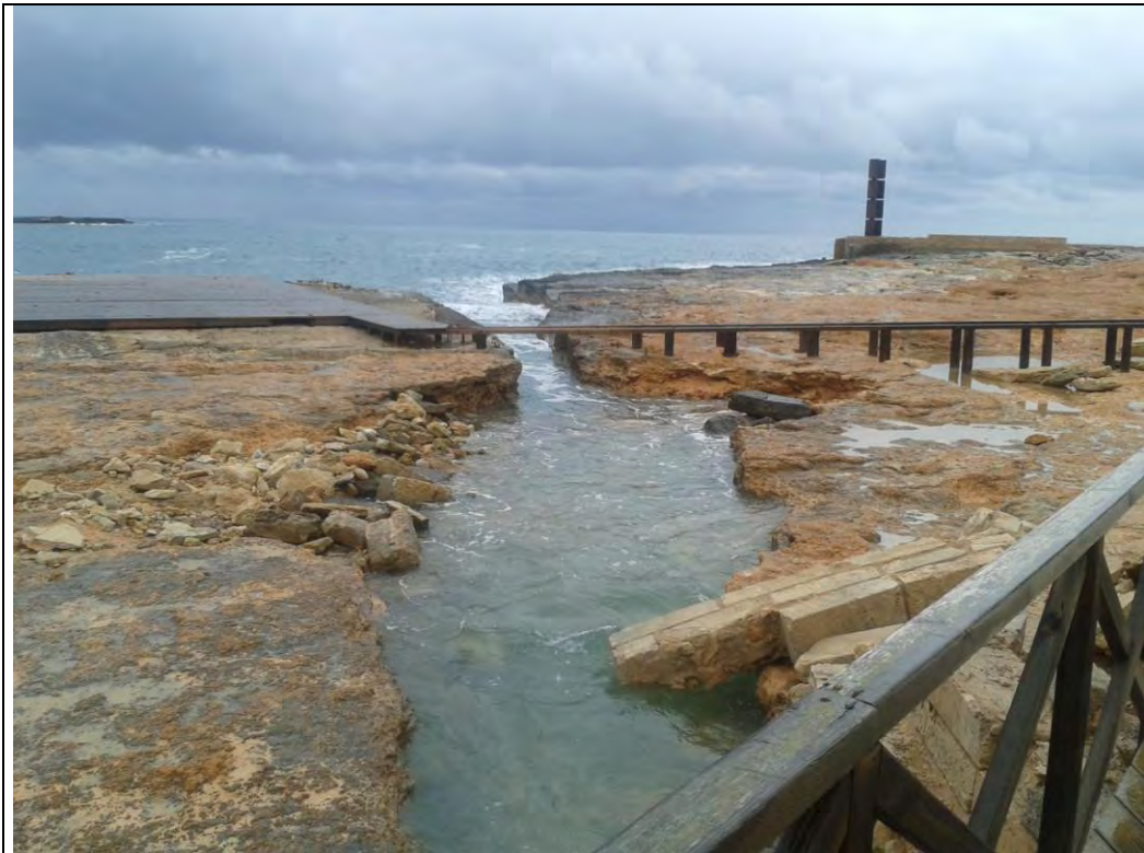
Fotografía 1. Vista del canal de entrada desde el paseo peatonal.
