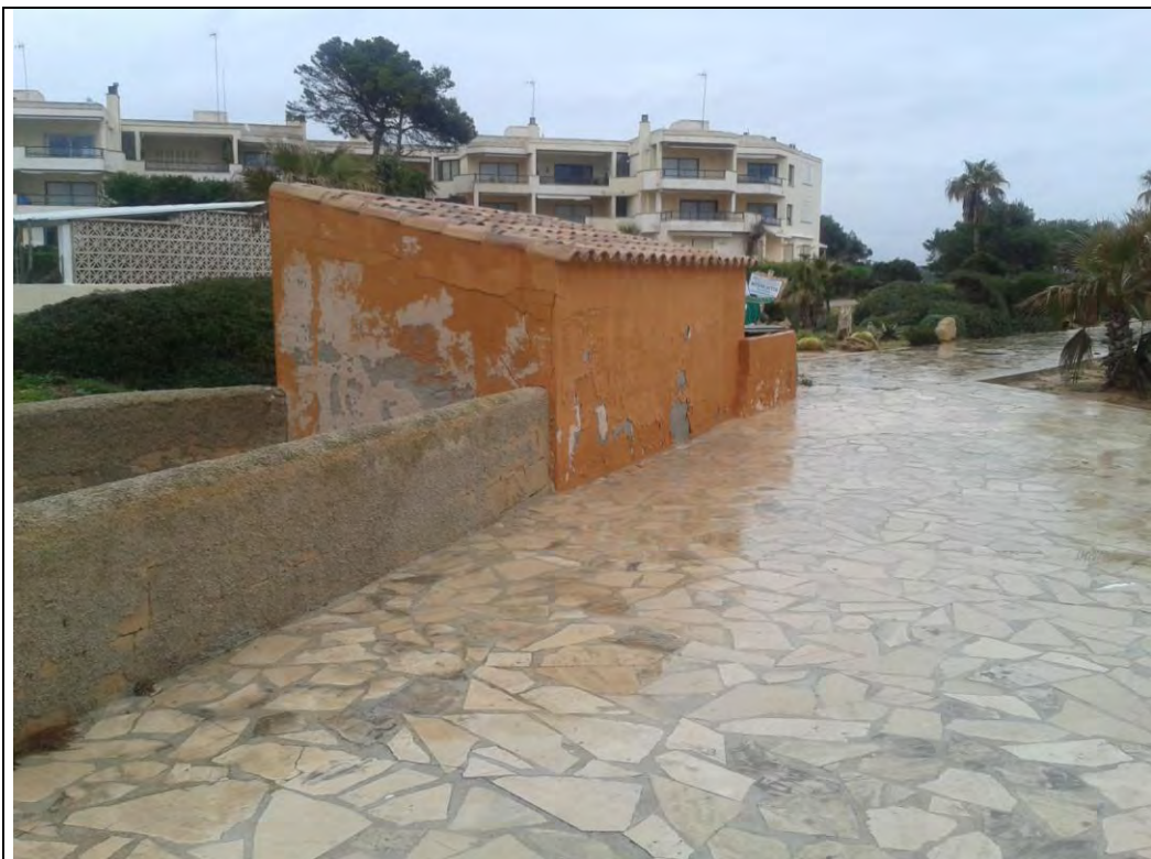
Fotografía 4. Vista de la caseta de bombeo y del murete que protege al tráfico peatonal de la caída en altura.
