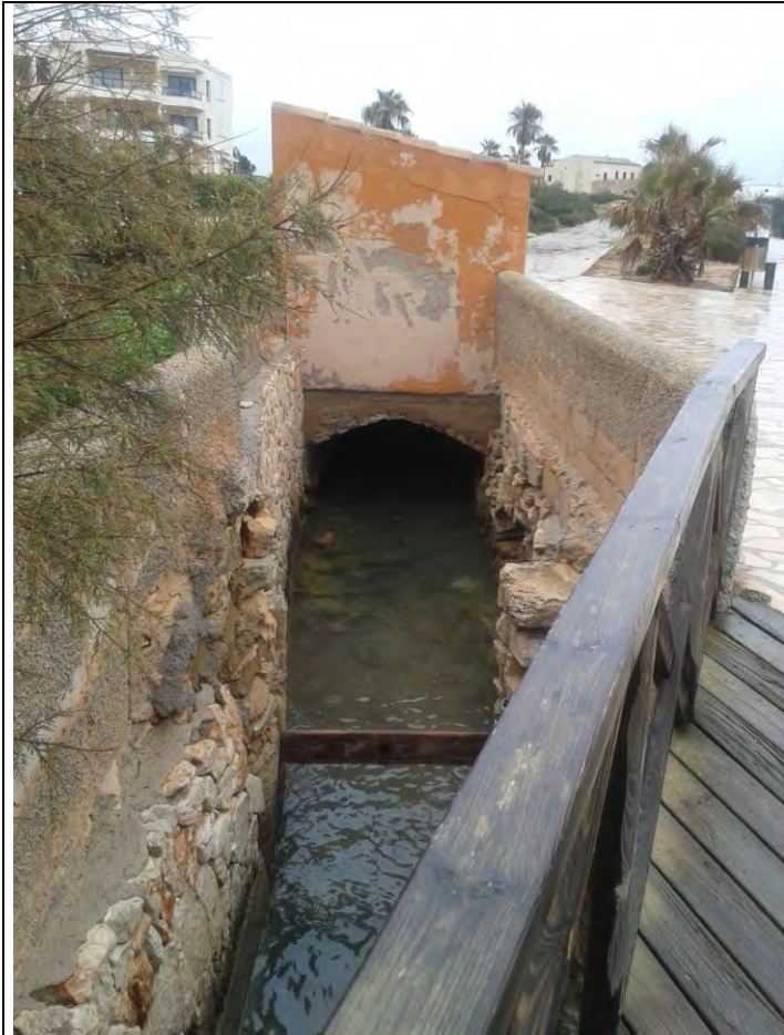
Fotografía 3. Detalle de la compuerta y de la caseta de bombeo desde el paseo peatonal.
