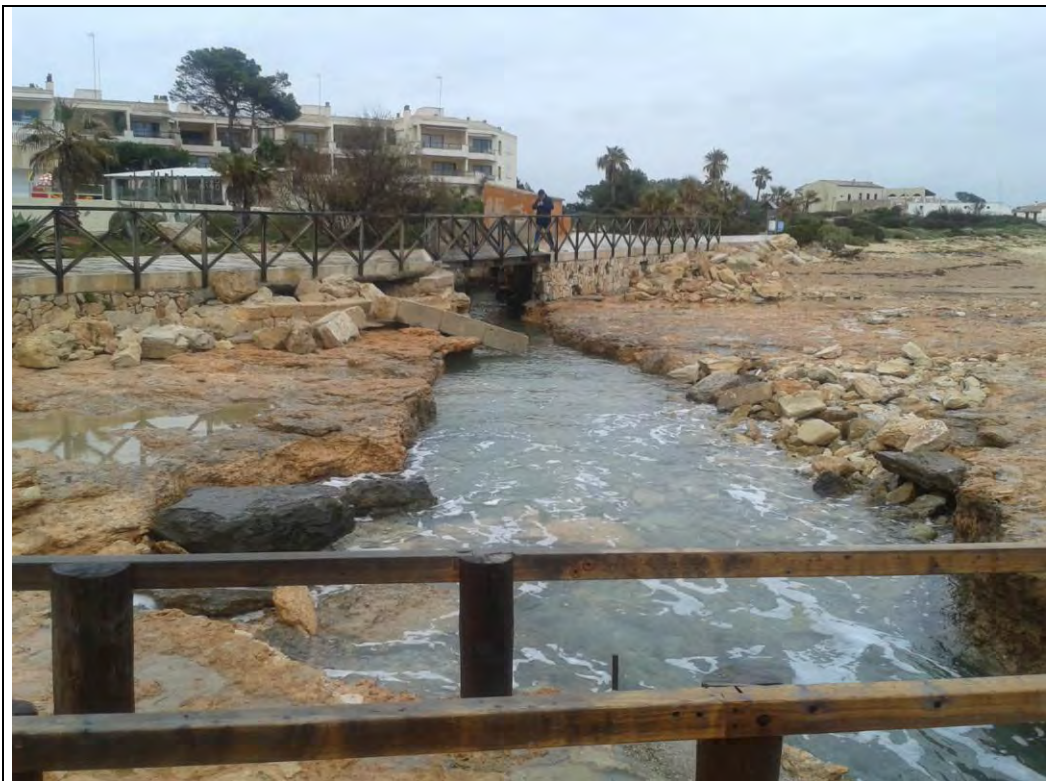
Fotografía 2. Vista del canal desde su embocadura.
