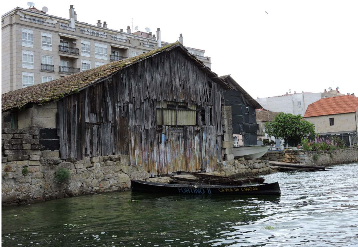
Vista de la Carpintería de Casqueiro (primer plano) y la Carpintería de Calragho (segundo plano) desde el mar. 2015
