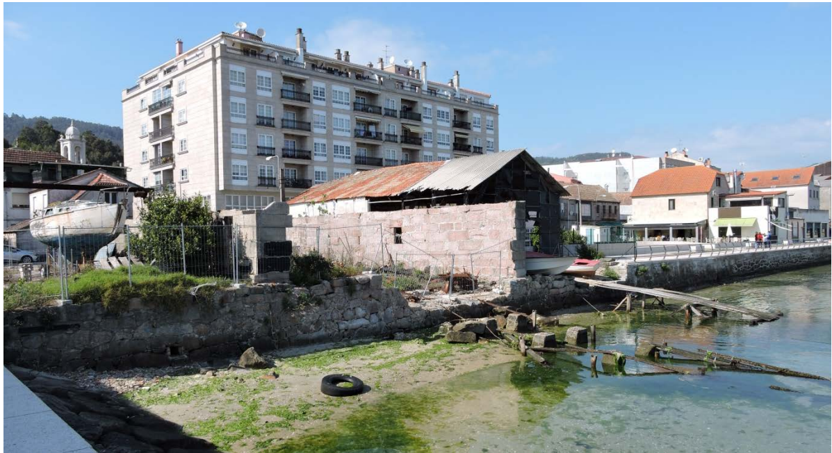
Vista de la Carpintería de Casqueiro (primer plano) y la Carpintería de Calragho (segundo plano) desde el mar. 2019
