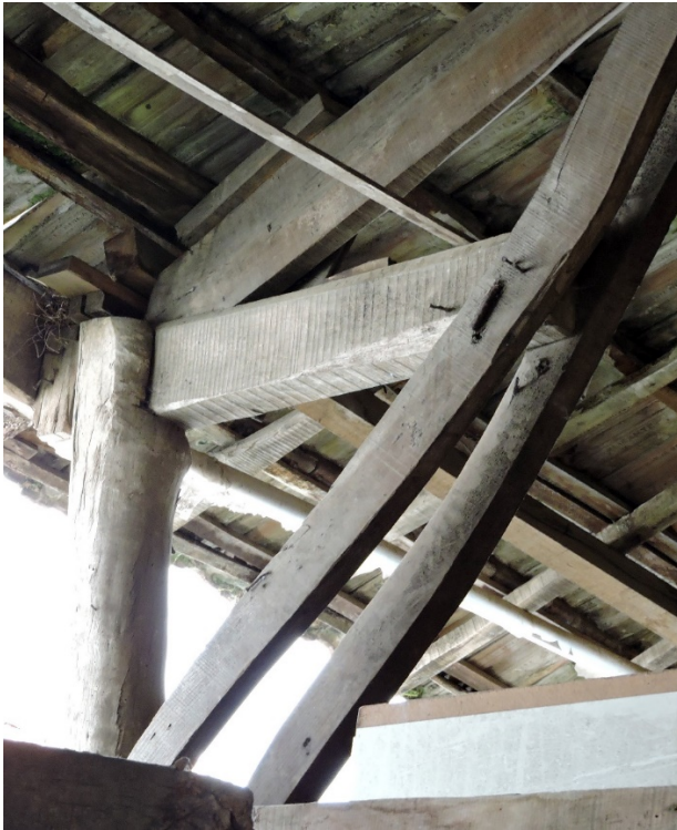
Encuentro del pórtico: Pilar circular/Tirante cortado/Pares/tornapuntas
