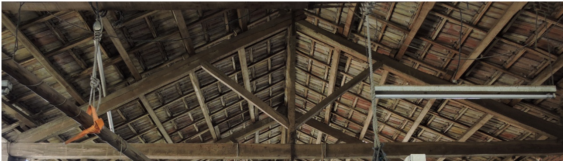
Cercha tipo de madera aserrada.
