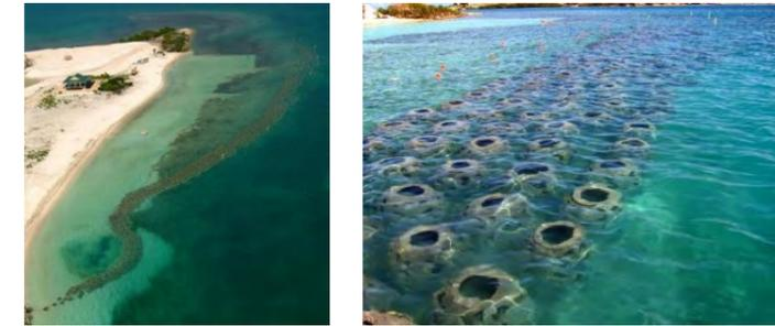
Imagen 29: Ejemplo aplicación de arrecifes modulares. Fuente: Reef Balls.
